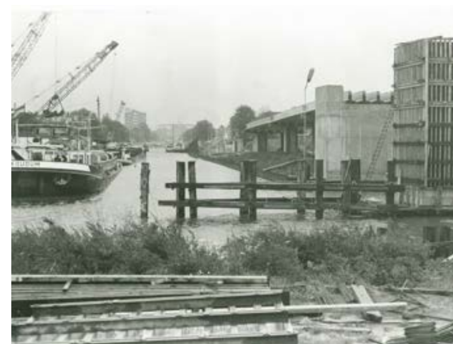
Aanleg van de busbaan in 1985 (foto: Frank Straatemeier/Groninger Archieven)
