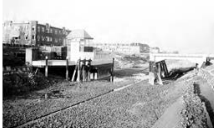
Aanleg Zaagmuldersbrug in 1938 (foto: Groninger Archieven)
