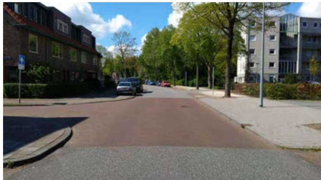
De klaprooslaan is qua vormgeving en materiaalgebruik vergelijkbaar met de toekomstige GOW-30 uitvalsweg (foto: gemeente Groningen)
