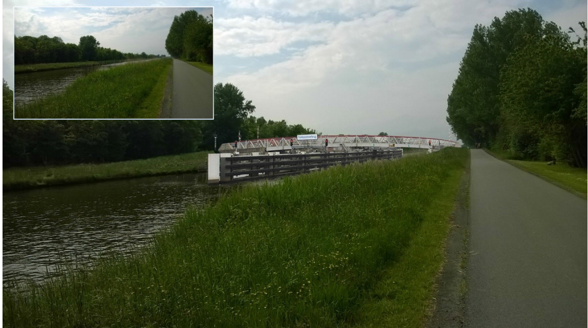
Impressie: getoogde draaibrug westzijde Paddepoelsterbrug (standplaats: noordzijde Van Starckenborghkanaal, kijkrichting: westen). Kader: huidige situatie.
