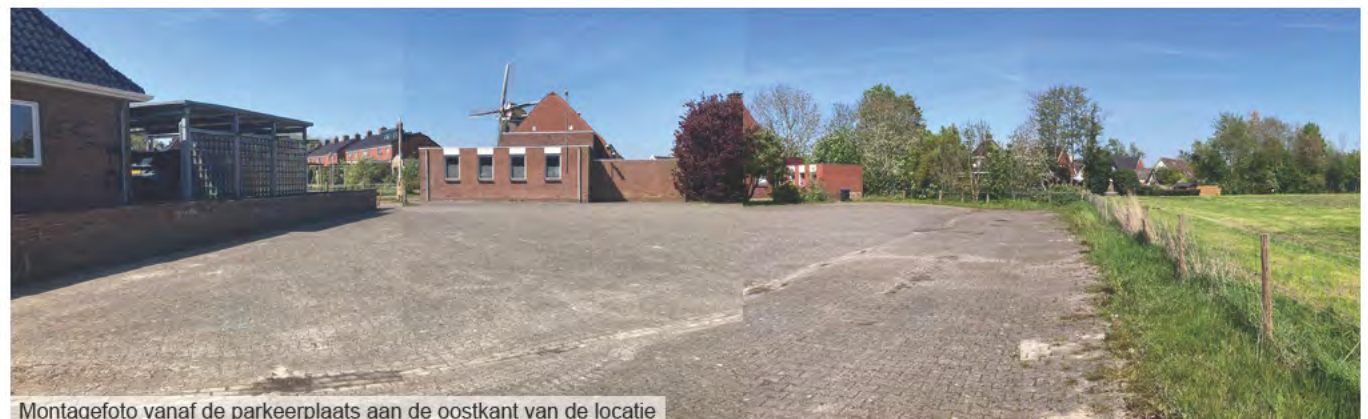
Montagefoto vanaf de parkeerplaats aan de oostkant van de locatie
