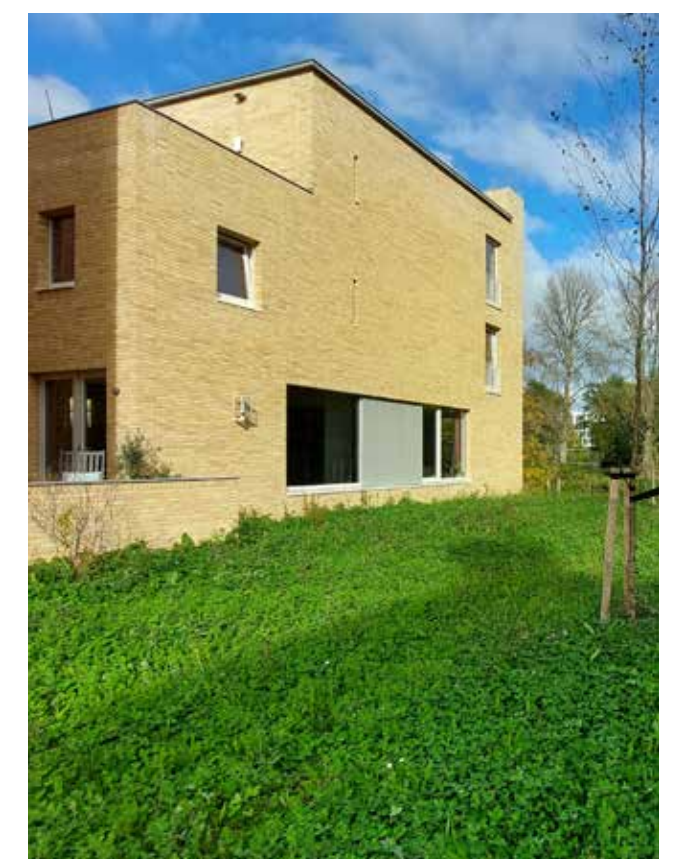
Gevelopeningen in hoek, Engelse Park, Groningen
