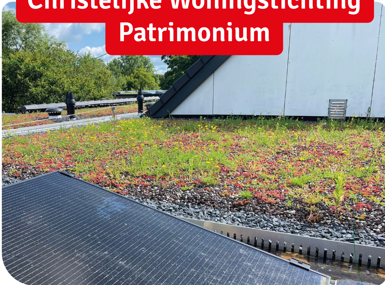
Zonnepanelen en gedeeltelijk groen dak aan de Boelemaheerd na isolatie en verduurzaming van het complex.
