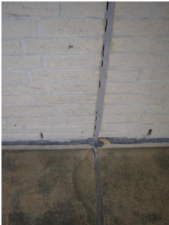
Foto 32: Dilataatie t.p.v. ankerloze spouwmuur door de galerij en het metselwerk.
