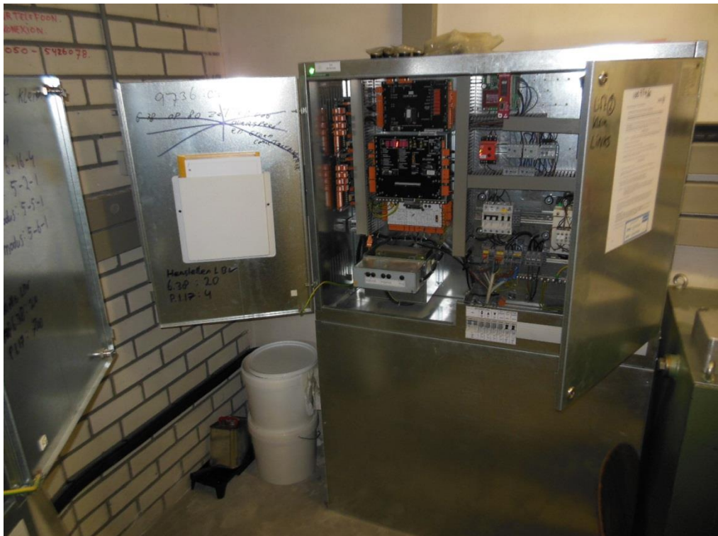
Foto 42: Schakelkast liftinstallatie.
