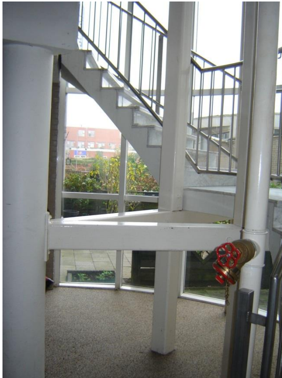
Foto 11: Hoofdtrap met prefab betonnen trapelementen op staalconstructie.
