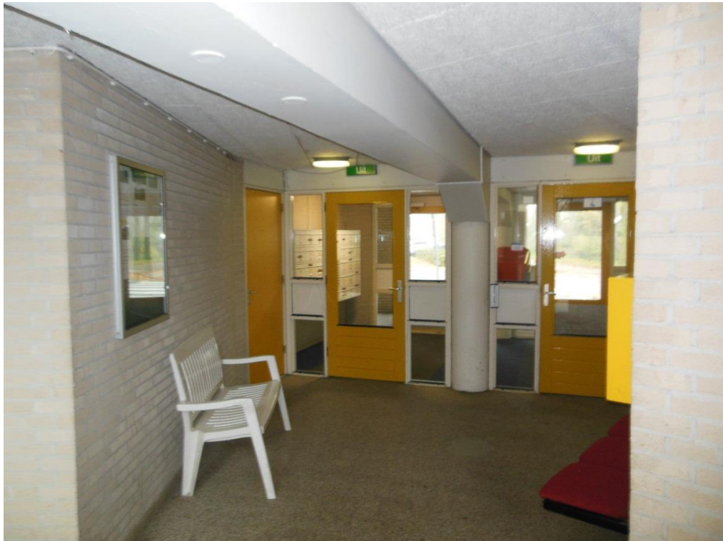
Foto 9: Entreehal met betonkolommen en betonbalk, plafond houtwolcementplaat.
