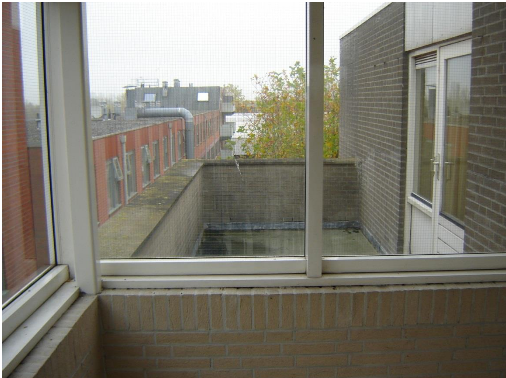
Foto 22: Bovenste verdieping met metselwerk borstwering.
