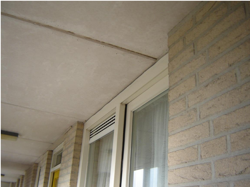
Foto 30: Oplegging galerij op achtergevel appartementen. Deels met L-staal boven de voordeuren.
