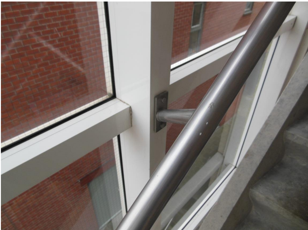
Foto 26: Bevestiging balustrade aan gevel.
