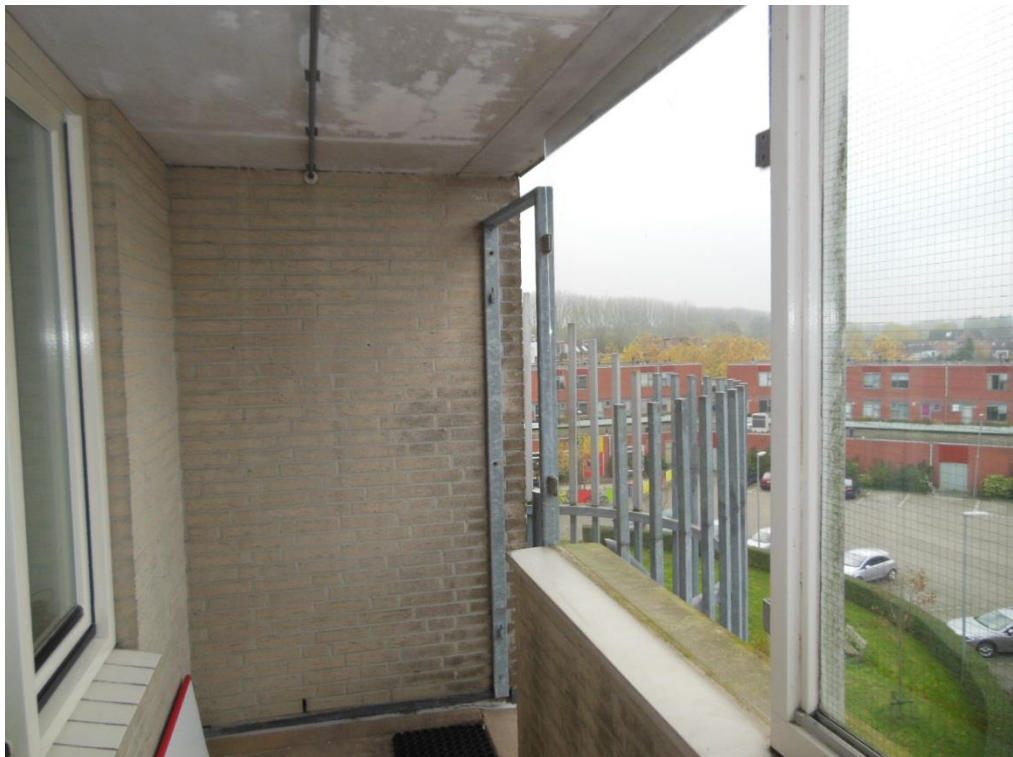
Foto 36: Galerij met noodtrap opgehangen aan metselwerk.
