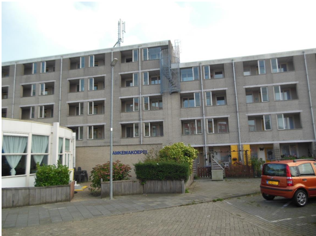
Foto 6: Achtergevel met stalen noodtrappenhuis van vloer 4 (3 e verdieping) naar vloer 5 (4 e verdieping).
