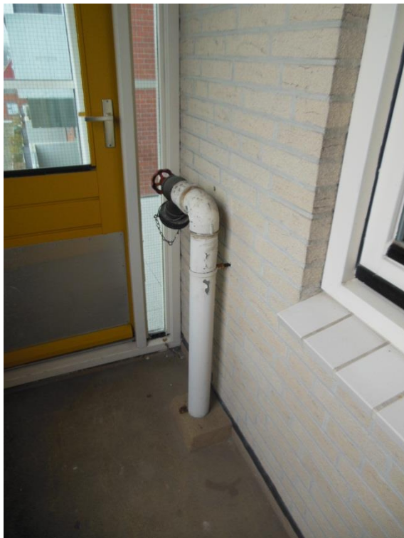
Foto 28: Droge blusleiding in beton van de galerij gestort.
