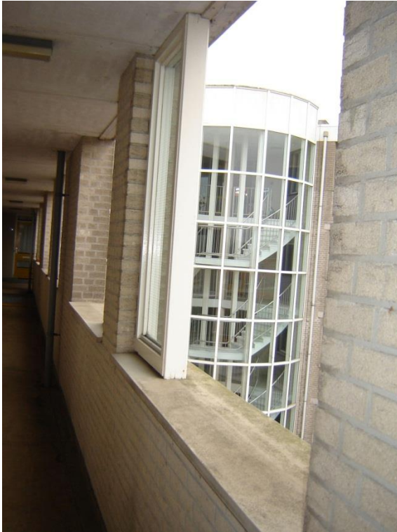
Foto 29: Galerij oplegging op penanten.
