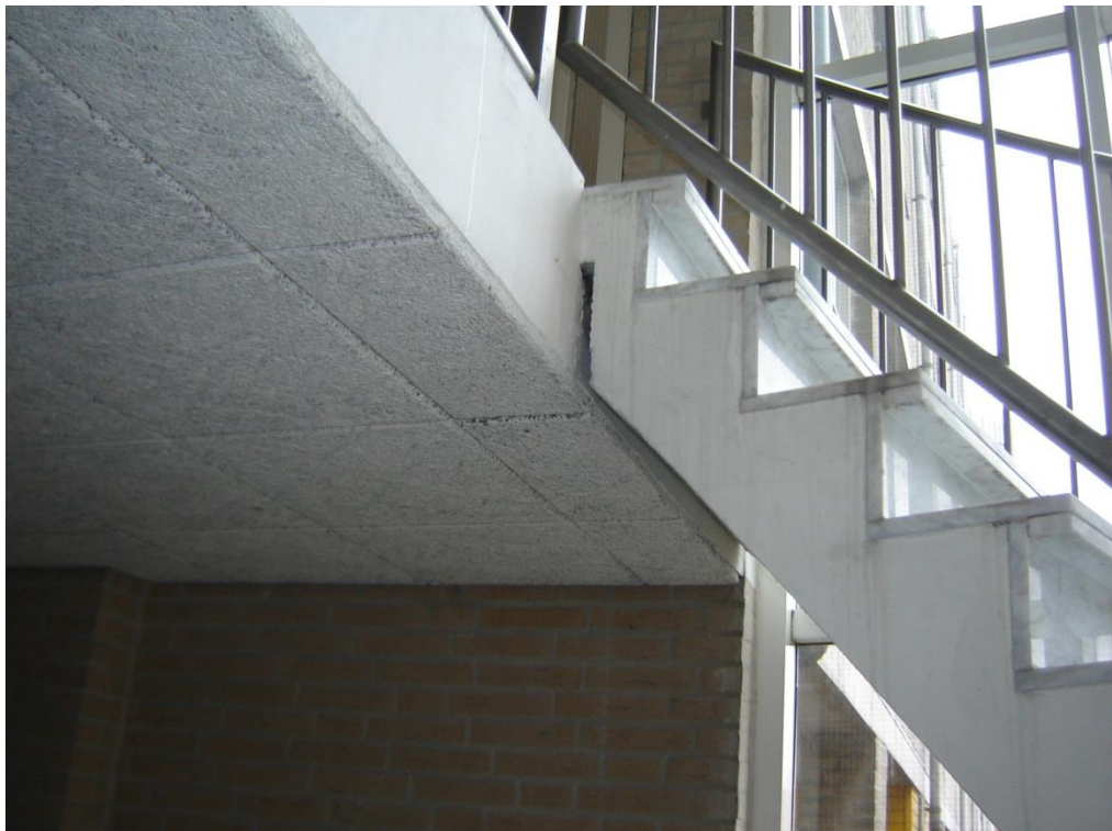
Foto 12: Oplegnok prefab trap op vloer.
