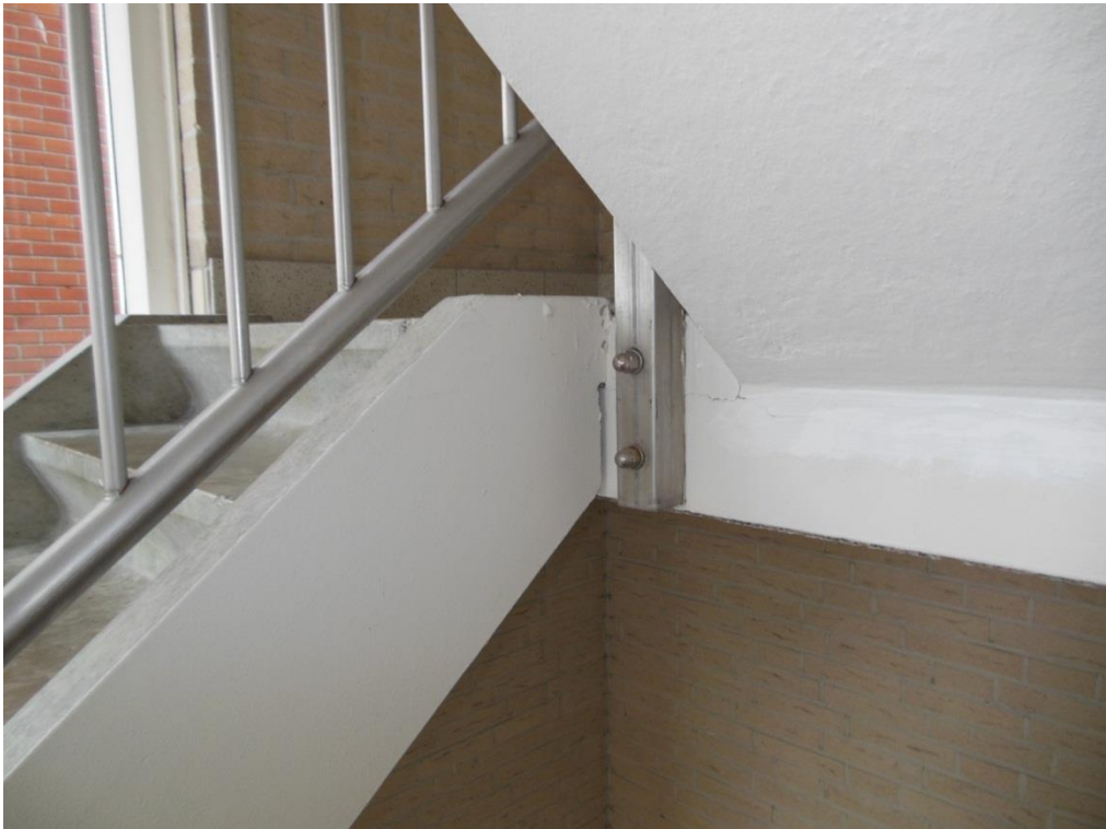
Foto 25: Prefab trap met oplegnok op vloer en bevestiging RVS balustrade.
