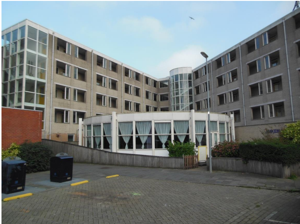
Foto 5: Achtergevel met middenin het hoofdtrappenhuis.
