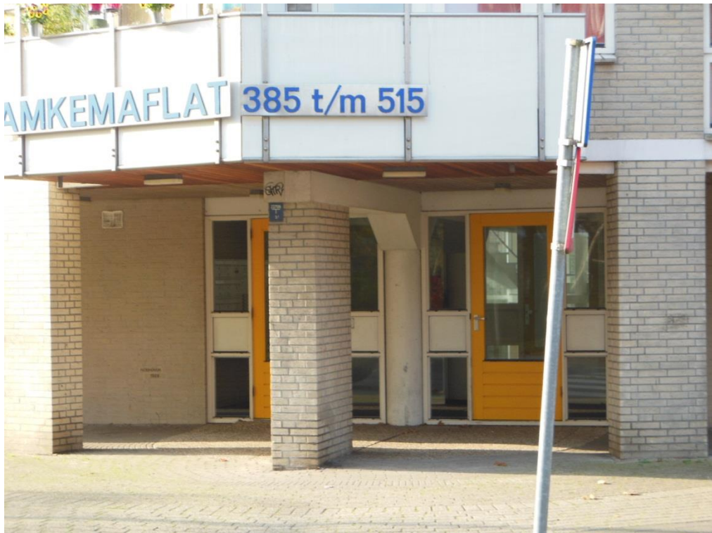
Foto 8: Hoofd entree Amkemaheerd met metselwerk penanten en betonbalk.
