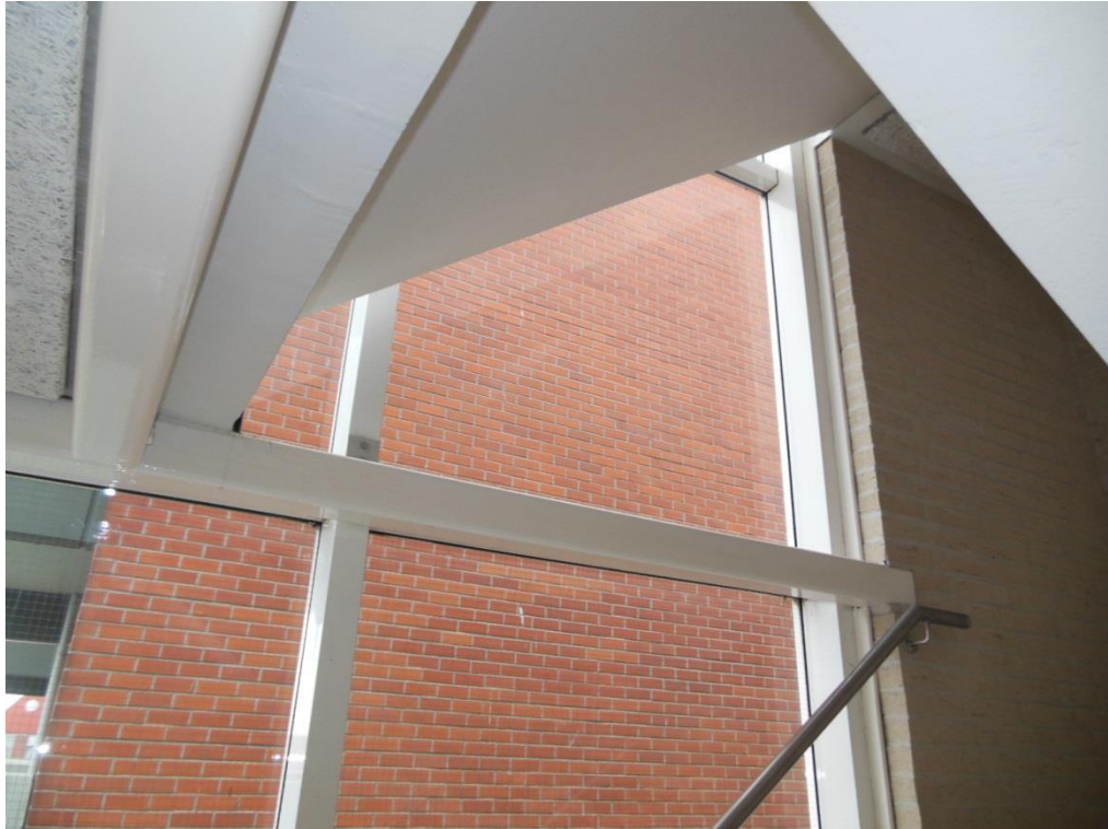
Foto 19: Trap eindgevel bestaat boven de begane grond uit een staalconstructie met prefab trappen.
