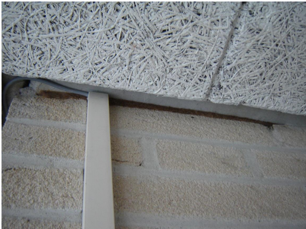
Foto 40: Vilt toegepast t.p.v. oplegging vloer op metselwerk.
