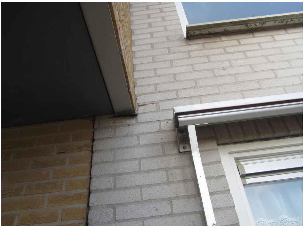
Figuur 17: Aansluiting bouwdeel D op ouder bouwdeel, ter plaatse van entree
