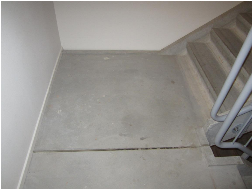
Figuur 28: Tussenbordes centraal trappenhuis opgelegd in wand
