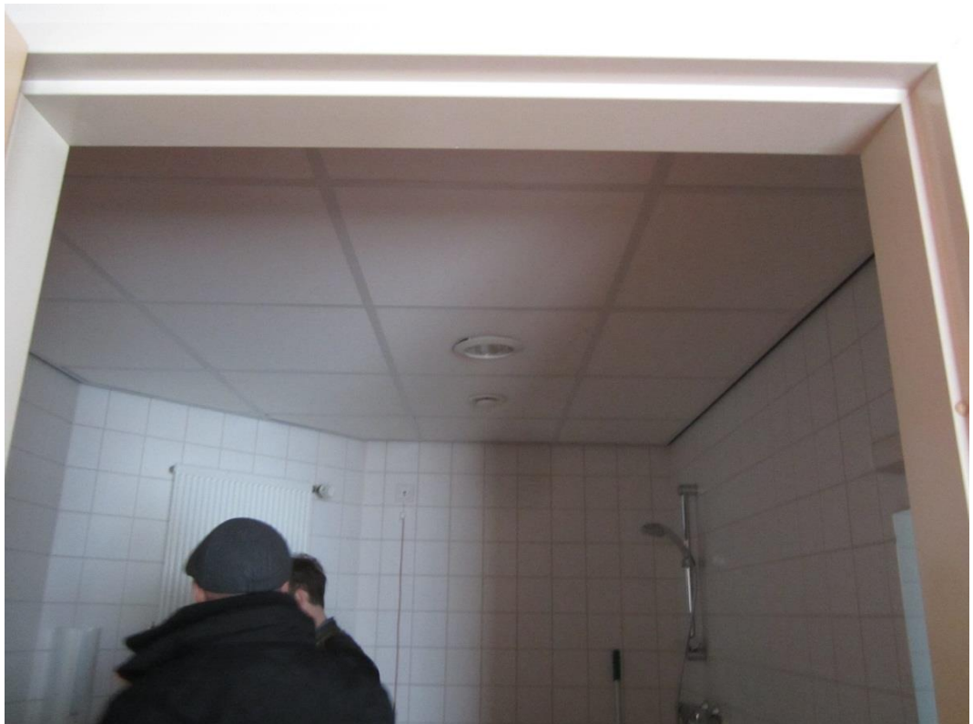
Figuur 31: Verlaagd systeemplafond
