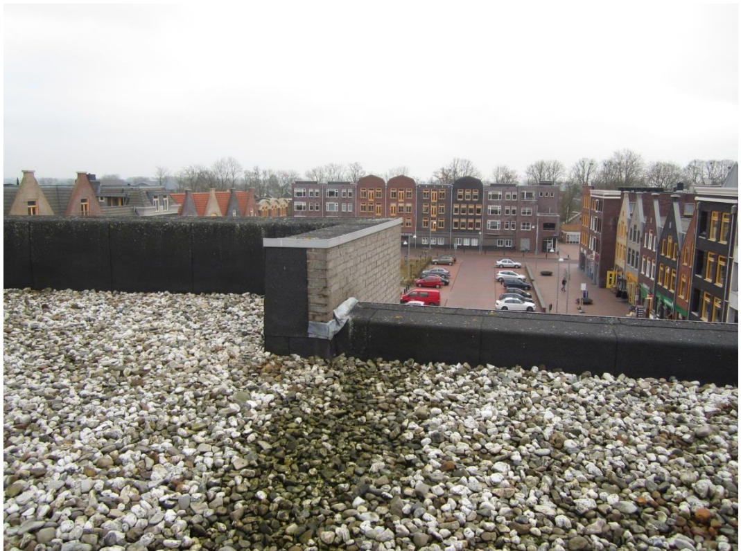
Figuur 27: Dakrand metselwerk met lichte achterconstructie
