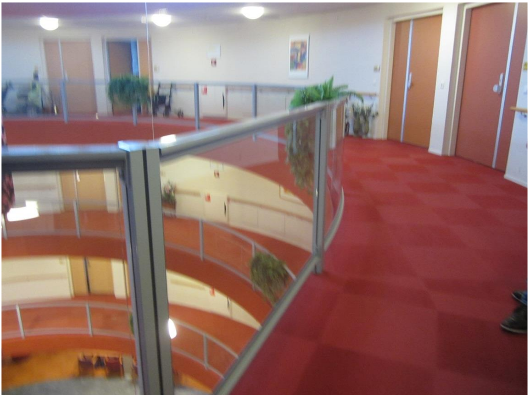
Figuur 25: Balustrade glas en RVS
