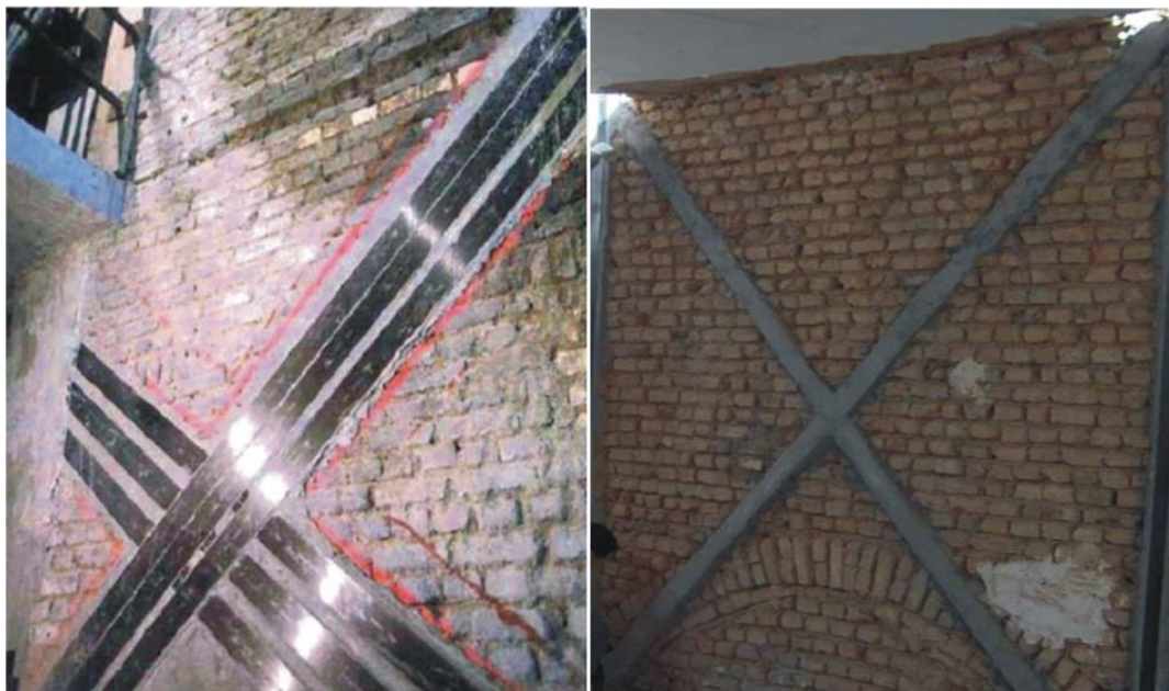
Figuur 9: Verhogen afschuifcapaciteit metselwerk d.m.v. CFRP lamellen
