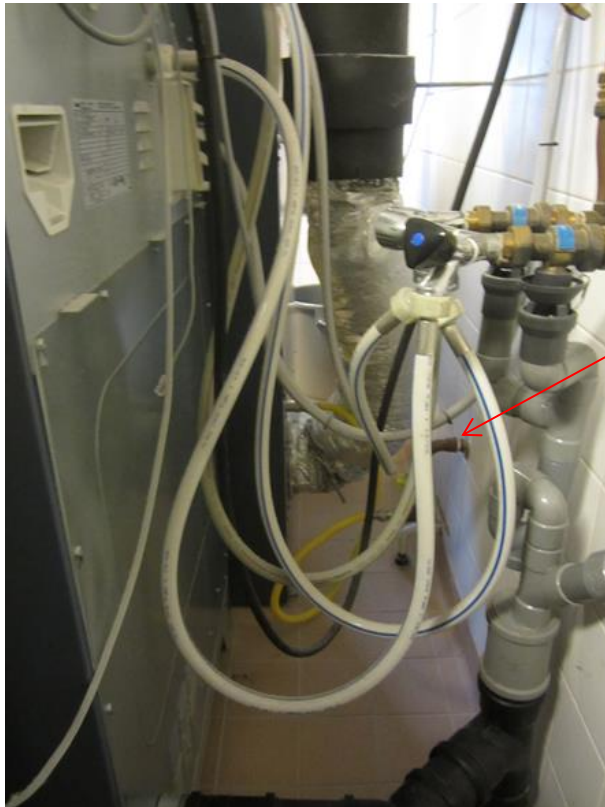
Figuur 35: Aansluiting gasgestookte wasdroger
