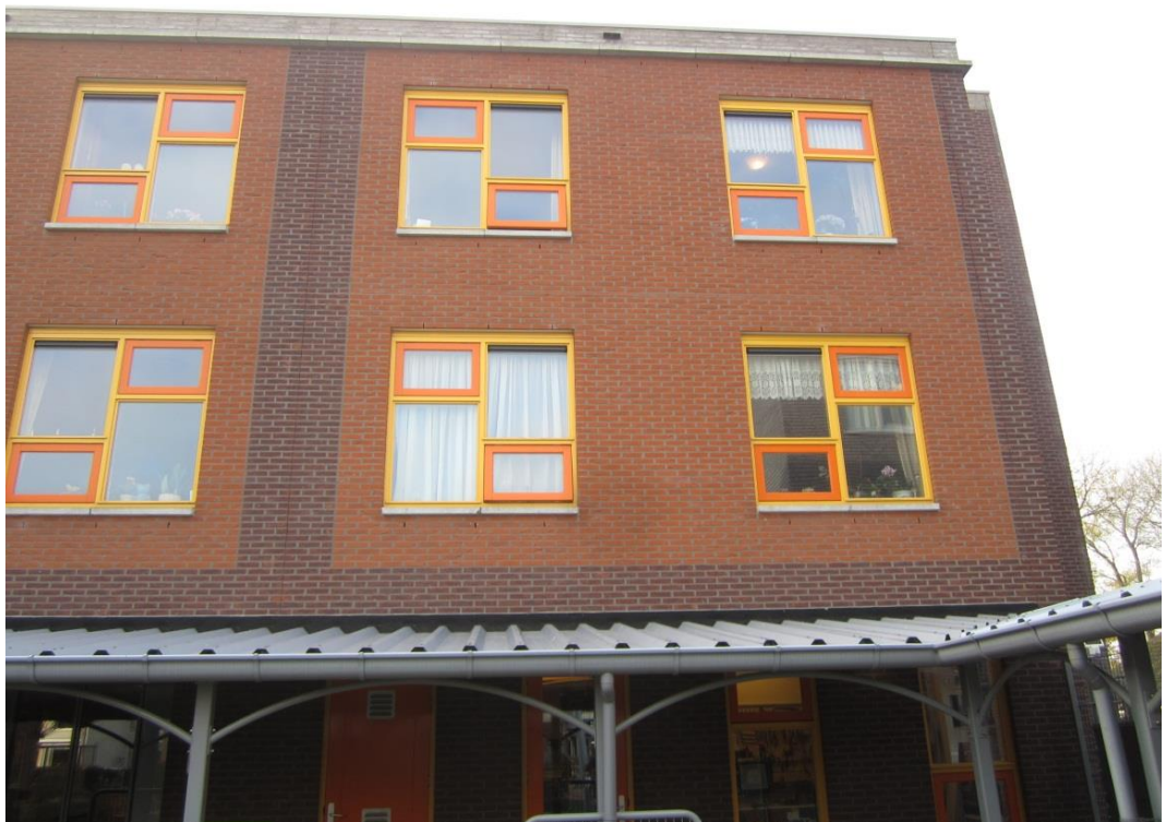
Figuur 22: Stalen lateien boven kozijnen
