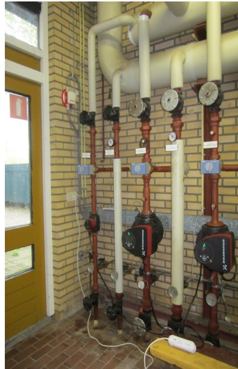
Foto B13: Gas en verwarmingsleidingen door beganegrondvloer.
