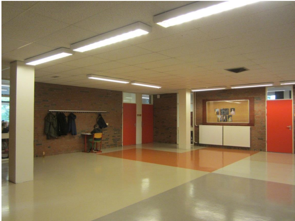
Foto B9: Gemetselde niet dragende binnenwanden.
