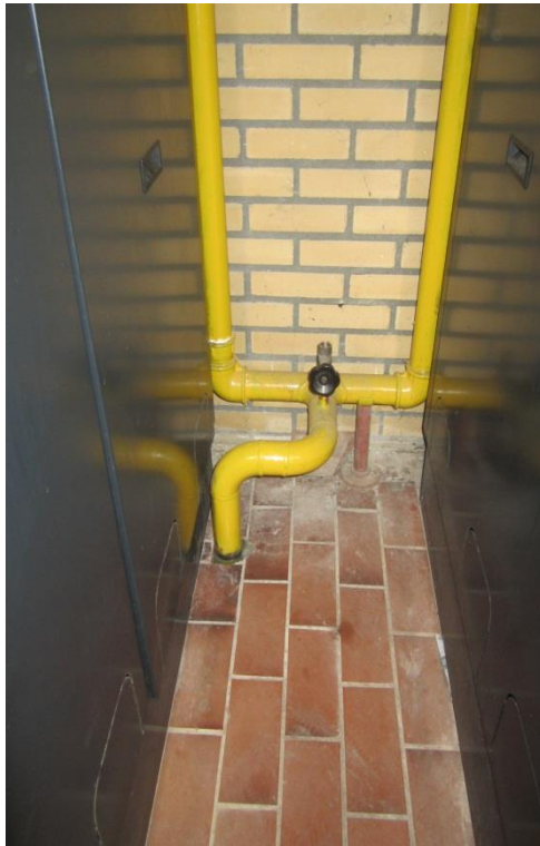
Foto B13: Gas en verwarmingsleidingen door beganegrondvloer.
