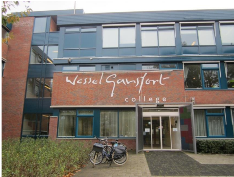
Figuur 2: Hoofdentree Wessel Gansfort College – Oostgevel
