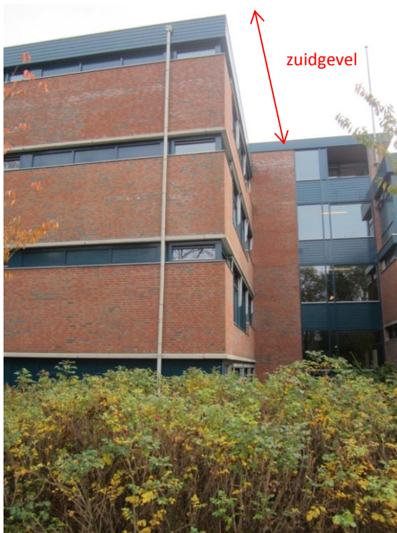
Foto B3: Overzicht Zuidgevel.
