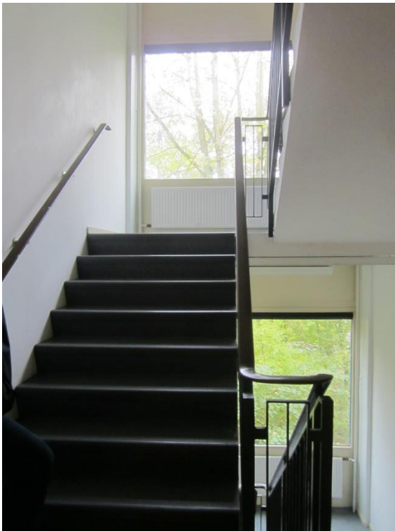
Foto C2: Trappenhuis tussen de betonnen stabiliteitswanden.
