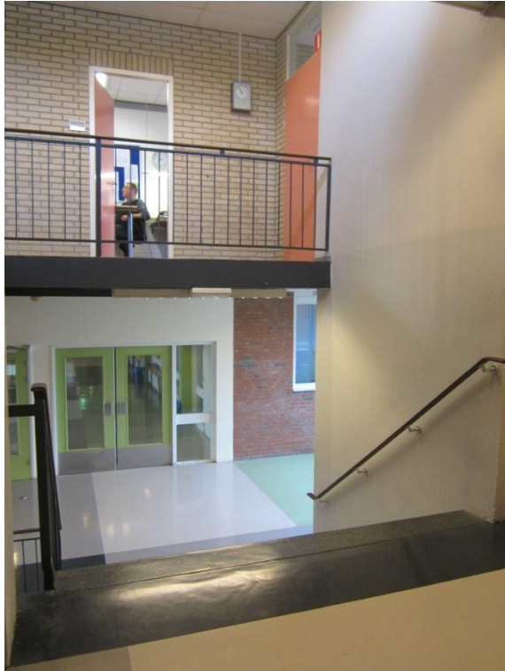
Foto C3: Splitlevel aansluiting met aangrenzend bouw.
