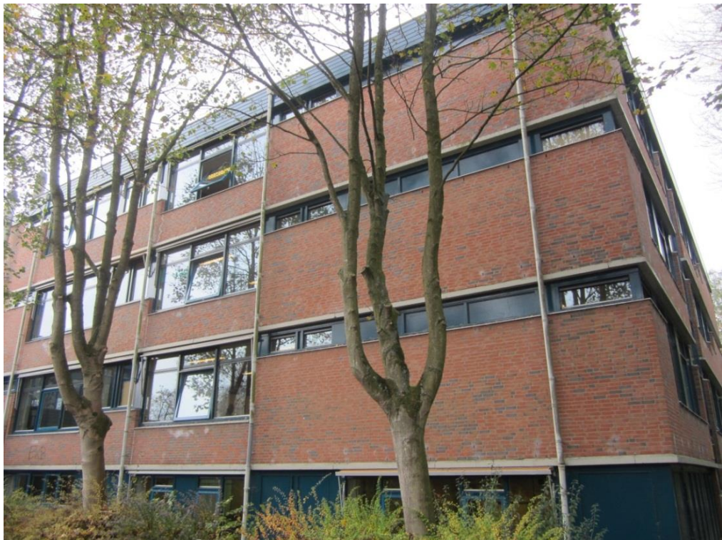
Foto B4: Overzicht Oostgevel.
