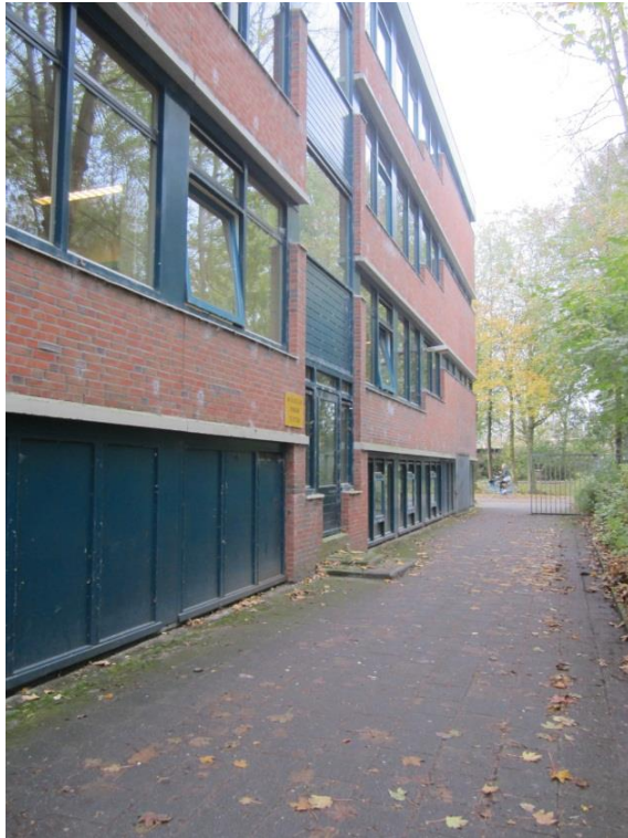
Foto B1: Overzicht Noordgevel.
