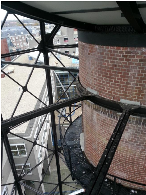
Foto C2: Koppeling metselwerk schacht.
