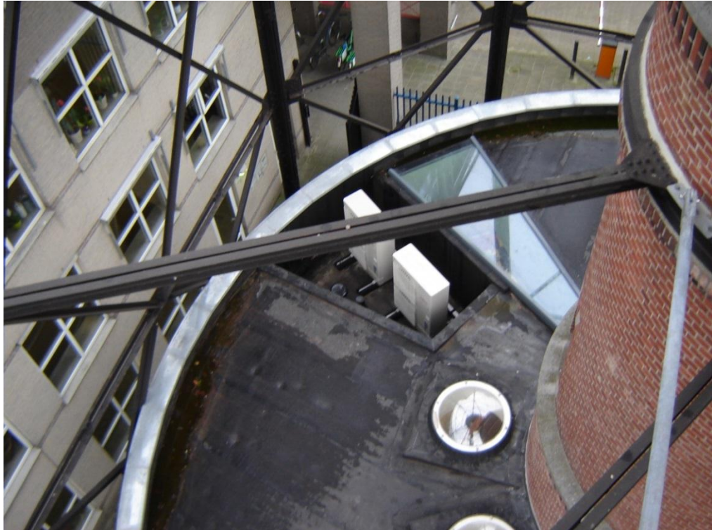
Foto B8: Dakaanzicht onderbouw.
