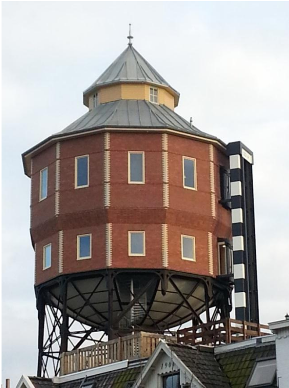
Foto B1: Toren gevelaanzicht.
