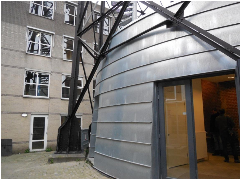
Foto B3: Staalconstructie vs. zinken gevel onderbouw.
