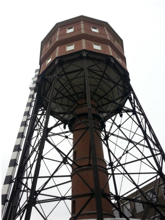
Foto C1: Staalconstructie met metselwerk opbouw.
