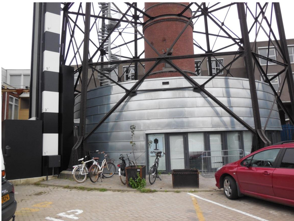
Foto C6: V-verband onderste vak stabiliteitsverband.
