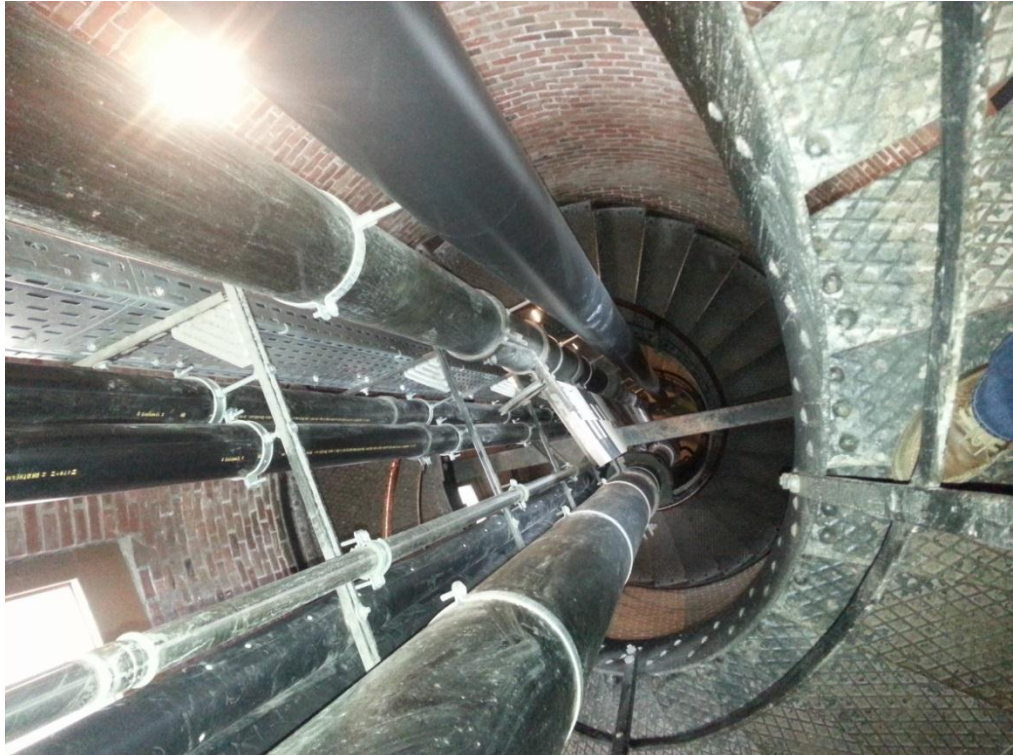
Foto B14: Leidingwerk t.p.v. metselwerkschacht.
