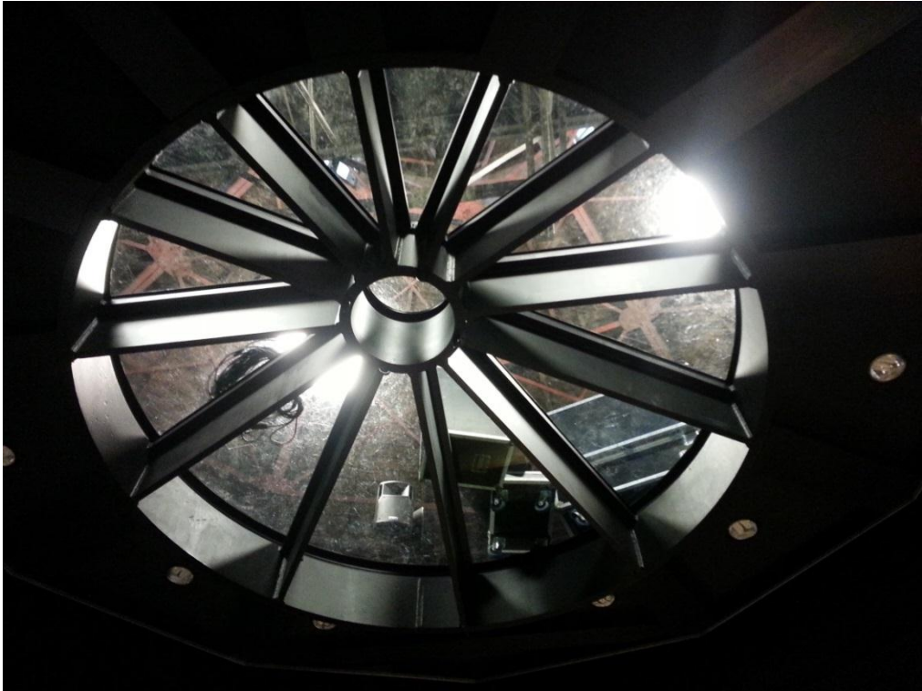
Foto B15: glazen vloerdelen in de ronde zaal.
