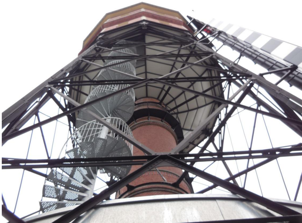
Foto B9: Stalen vluchttrap.
