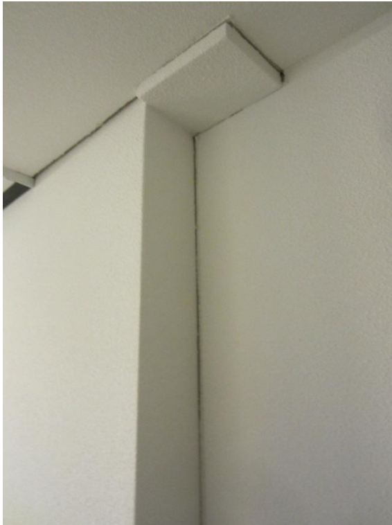
Foto B1: Dilatatie Brug en toren A
