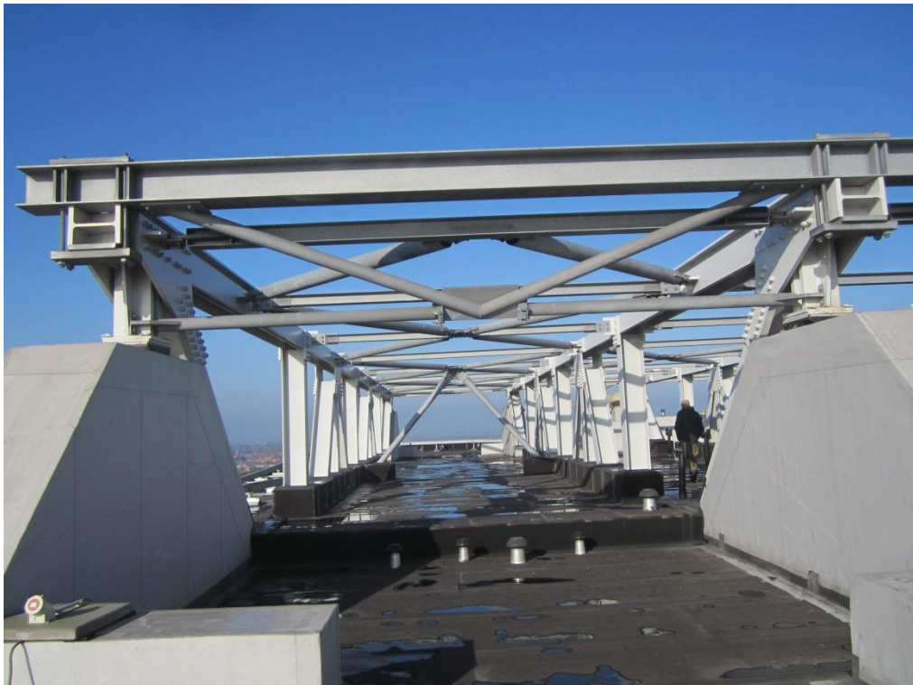
Foto C8: Stabiliteitsverbanden t.b.v. hoofdspanten
