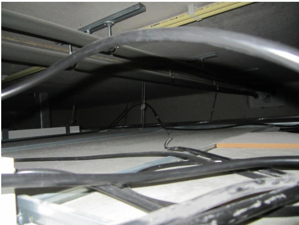
Foto B8: Verankering verlaagd plafond en daarin opgenomen armaturen
