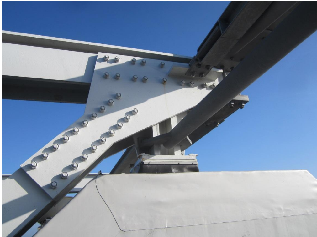
Foto C7: Schuivende oplegging hoofdspant
