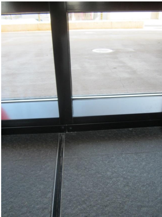
Foto B2: Dilatatie vloer hal tussen toren A en bouwdeel C
