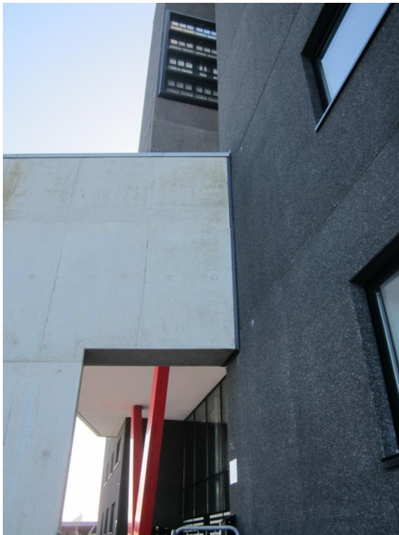
Foto B6: Verankering luifel aan toren B
