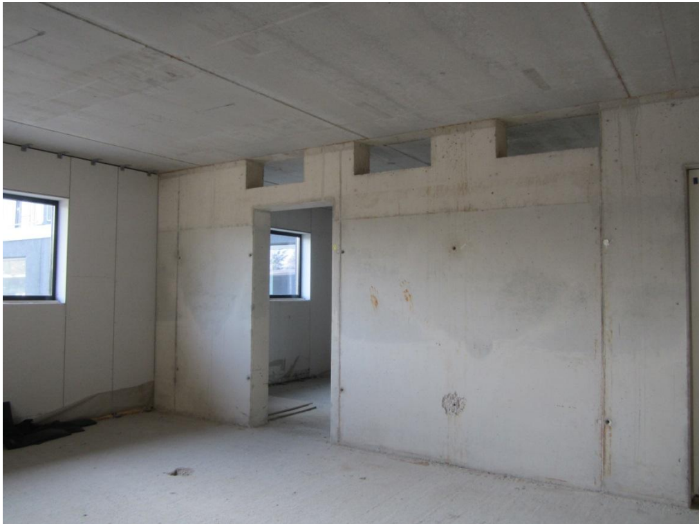
Foto C3: Opening in de stabiliteitswand t.b.v. Ventilatiekanalen
