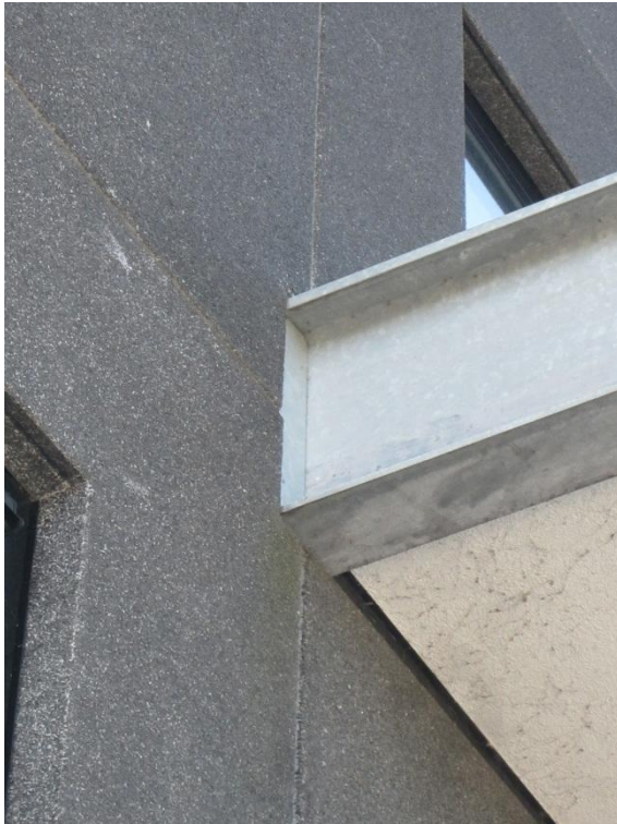
Foto B5: Bevestiging luifel aan toren A
