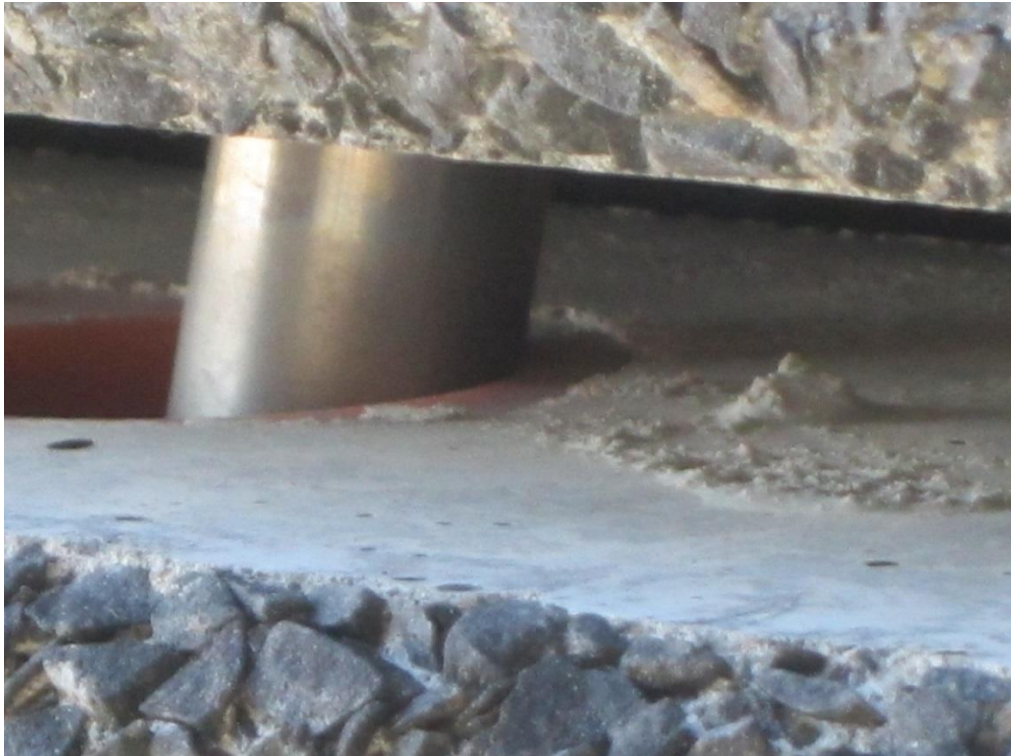
Foto B3: Anker/deuvel prefab betonelement
