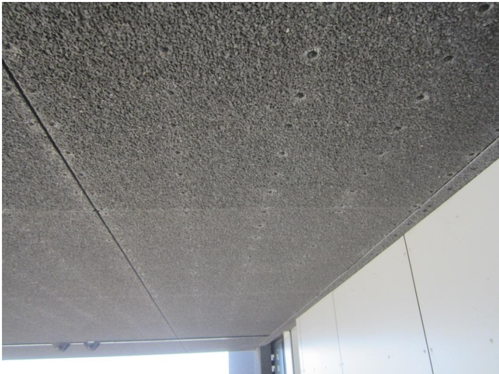
Foto B7: Verankering Colorpanal plafondplaten aan brug
