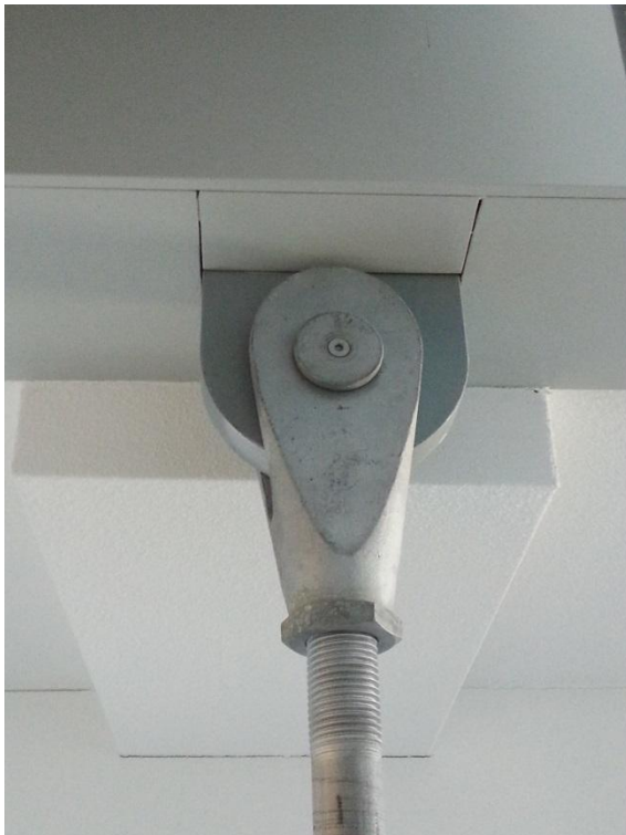
Foto C4: Trekstangen t.b.v. ophanging brug
