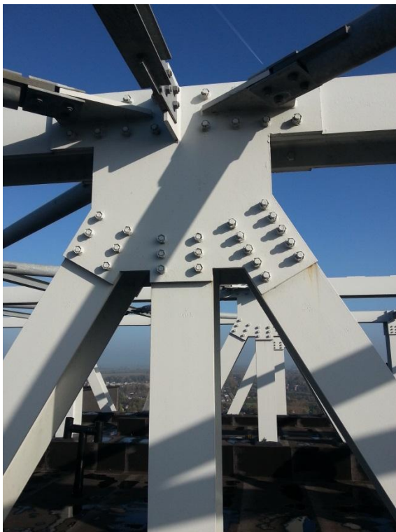
Foto C6: Bovenknoop hoofdspant
