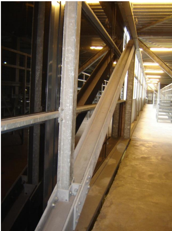
Foto 18: Druk/trekschoor als in vorige foto aangegeven.
