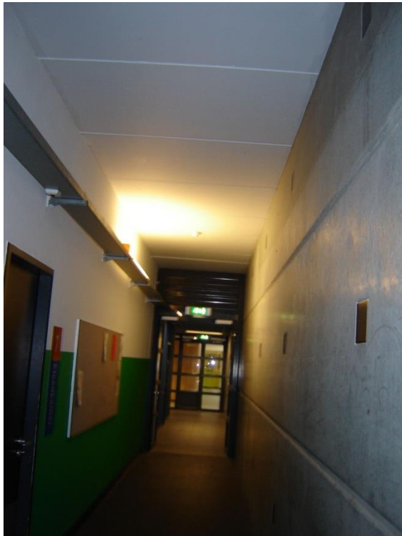
Foto 27: Gang voor kleedkamers ijshockeybaan met rechts een prefab dragende wand.
