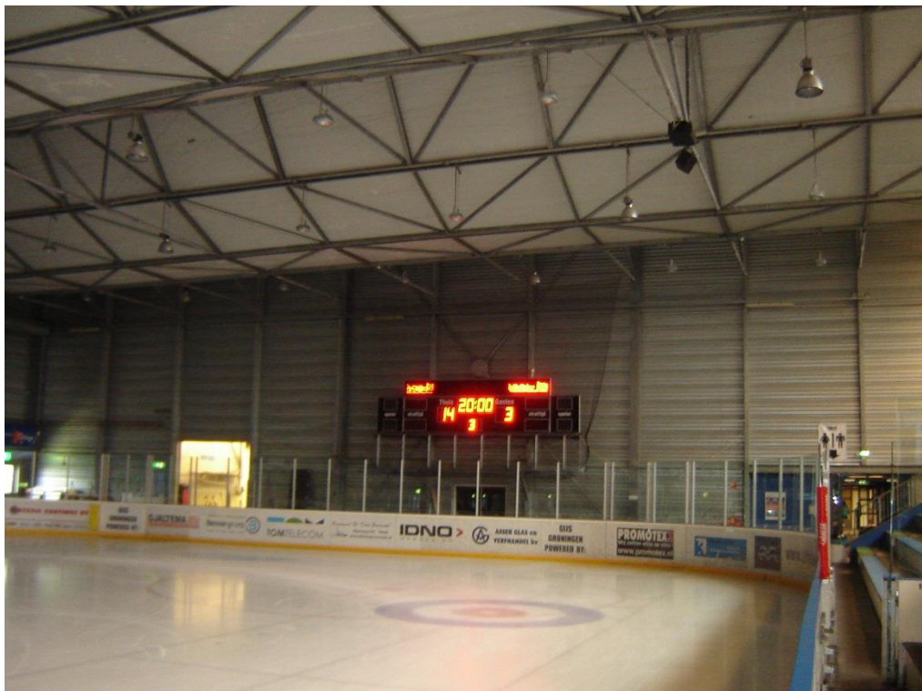
Foto 31: IJshockeybaan: lichte wanden, scorebord en stabiliteitsverbanden.
