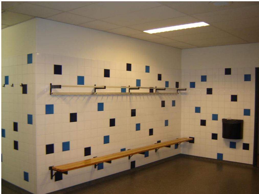
Foto 10: Interieur kleedkamer met gemetselde scheidingswanden en systeem plafond.
