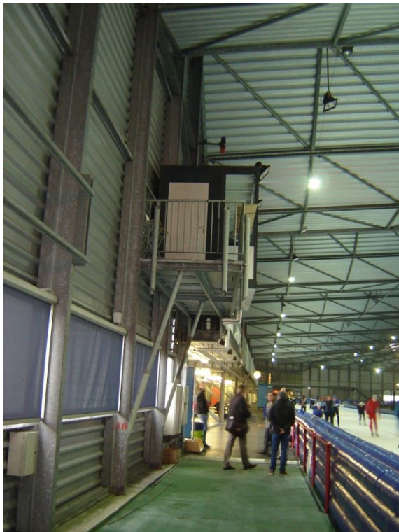
Foto 20: Scheidsrechterhuisje "opgehangen" aan stalen gevel kolommen.
