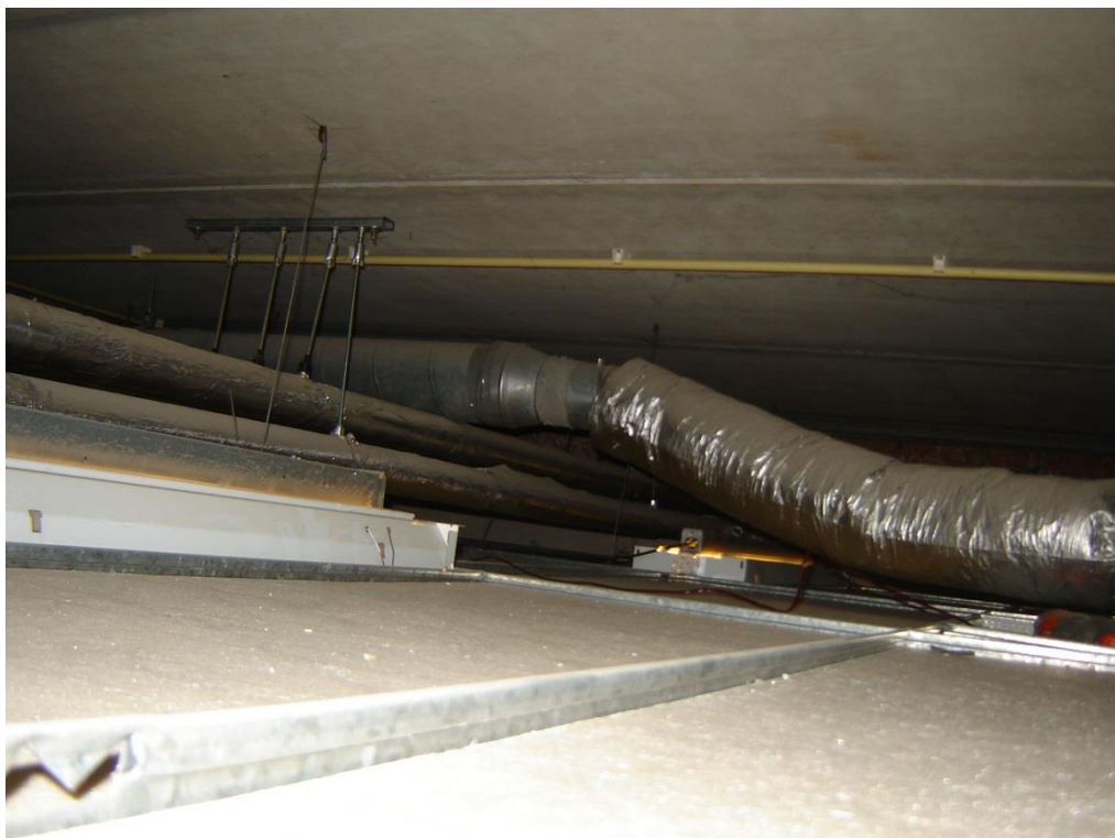
Foto 12: Installaties boven systeemplafond.
