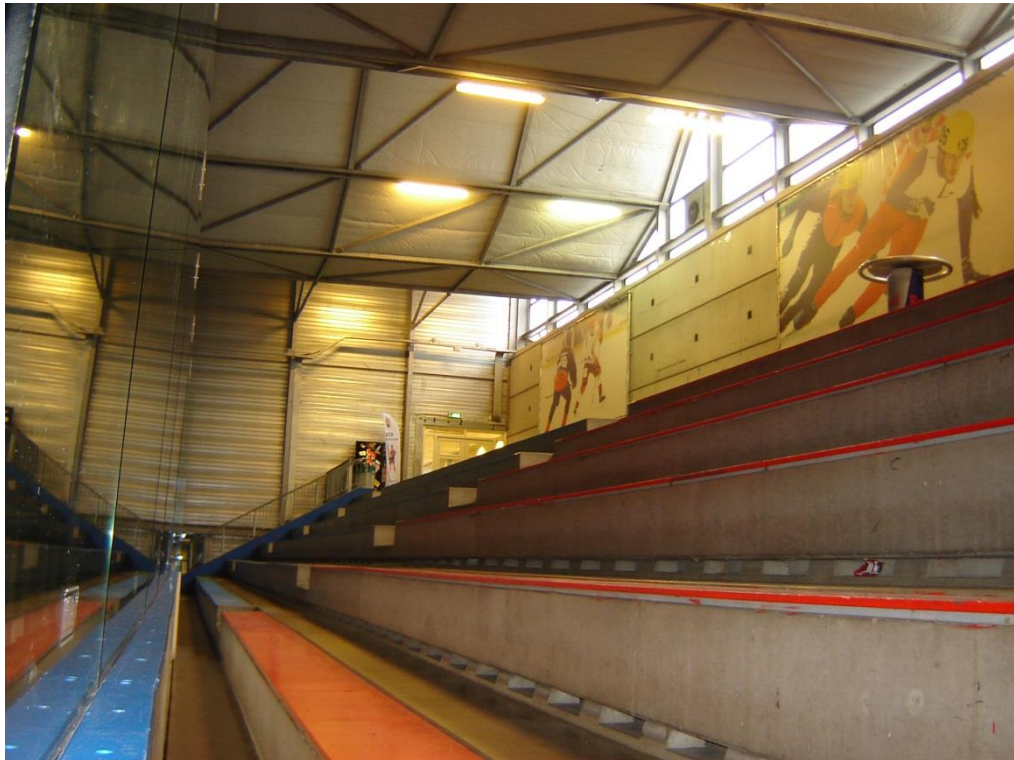
Foto 33: Prefab tribune elementen op metselwerk. Glazen afscherming naar de ijshockeybaan.
