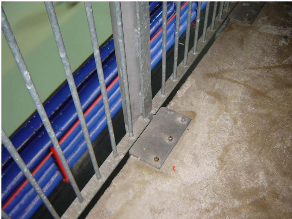
Foto 22: Bevestiging hekwerken.
