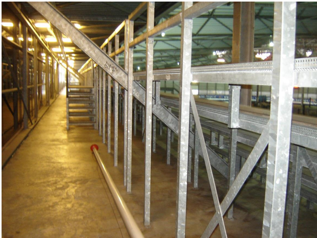
Foto 24: Stalen tribune op verdieping 400 m ijsbaan.
