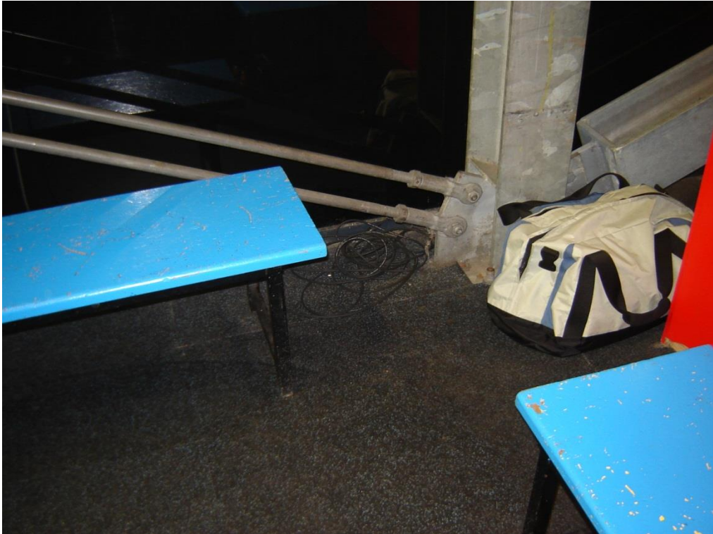
Foto 17: In de 400 m ijsbaan: Links oorspronkelijke verband met stafstaal en wartels, rechts is dit vervangen door een druk/trekschoor.
