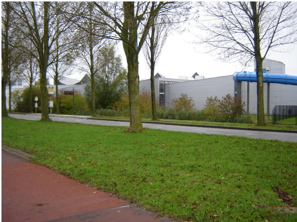
Foto 4: Gevel recreatie bad.
