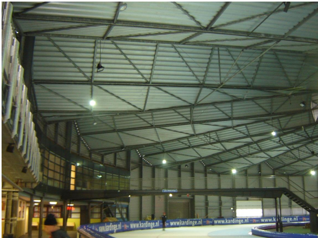
Foto 14: Dakconstructie in bocht ijsbaan met stalen loopbrug naar midden terrein.
