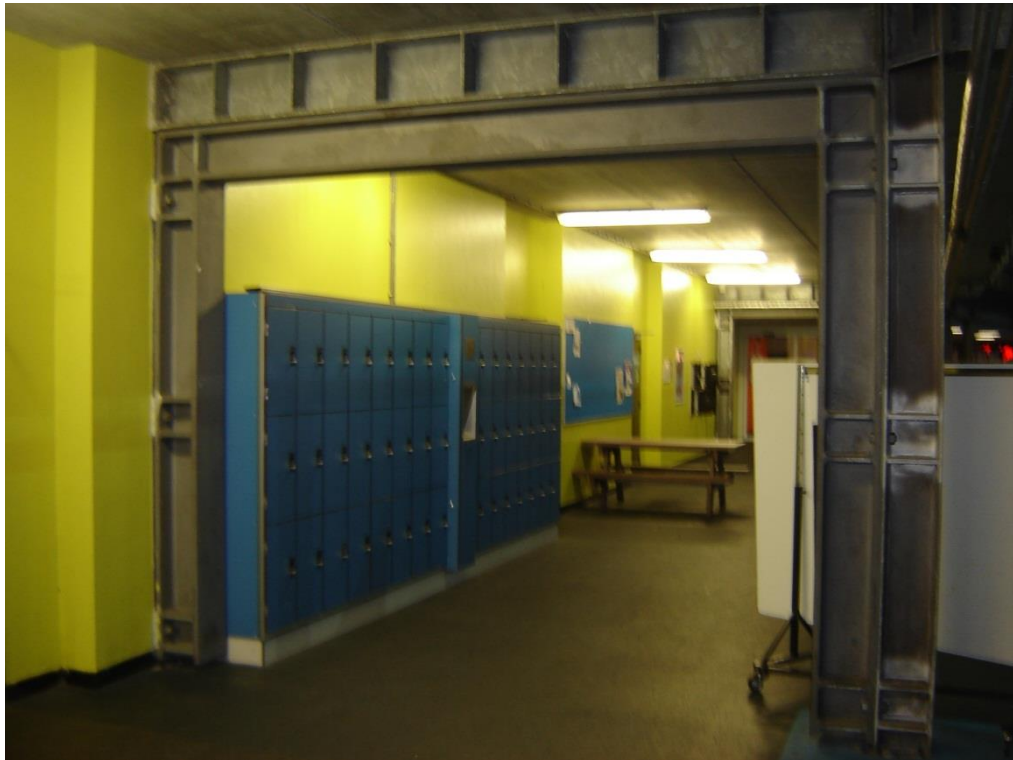
Foto 15: In de 400 m ijsbaan zijn een paar diagonalen vervangen door portalen.
