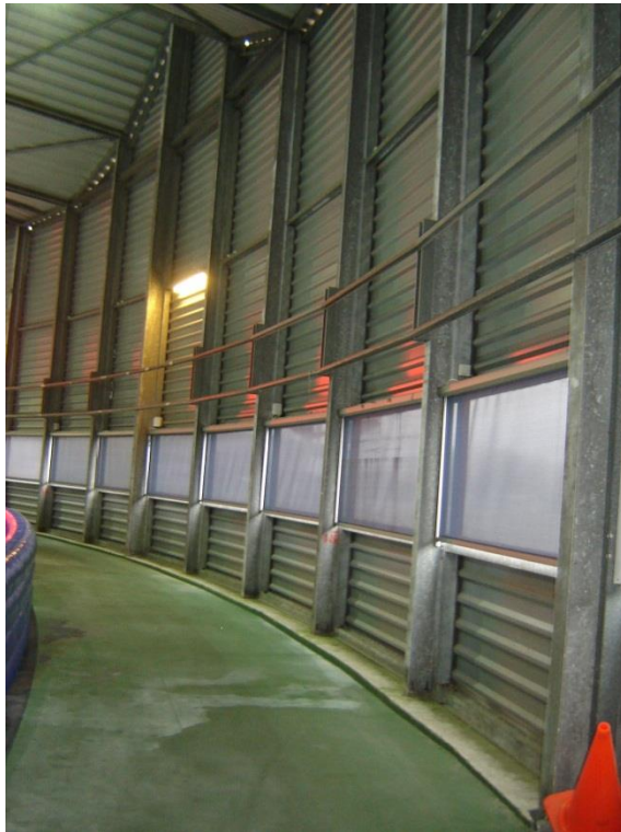
Foto 21: Stalen gevel met glasstrook in 400 m ijsbaan.
