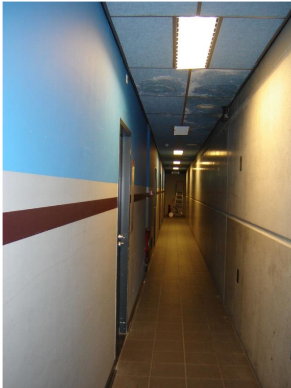
Foto 11: Interieur gang met metselwerk wanden (niet dragend) en systeem plafond met houtwolcementplaten.
