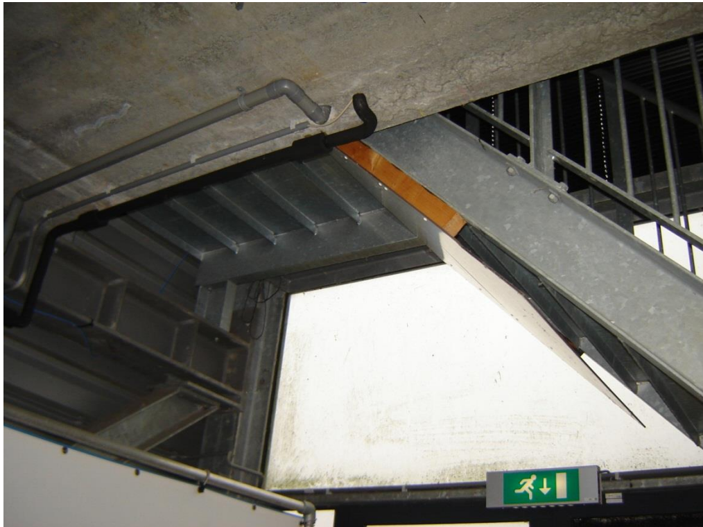
Foto 19: Stalen trap en bordes in 400 m ijsbaan.
