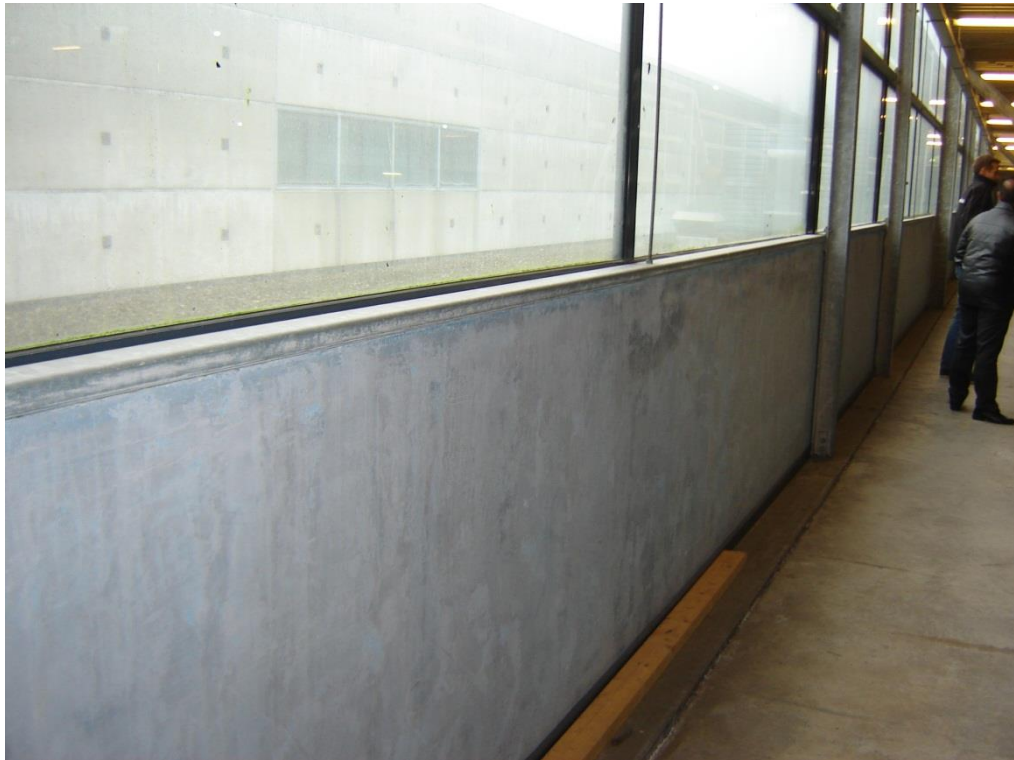
Foto 25: Vulling van kalkzandsteen borstwering op verdieping 400 m ijsbaan.
