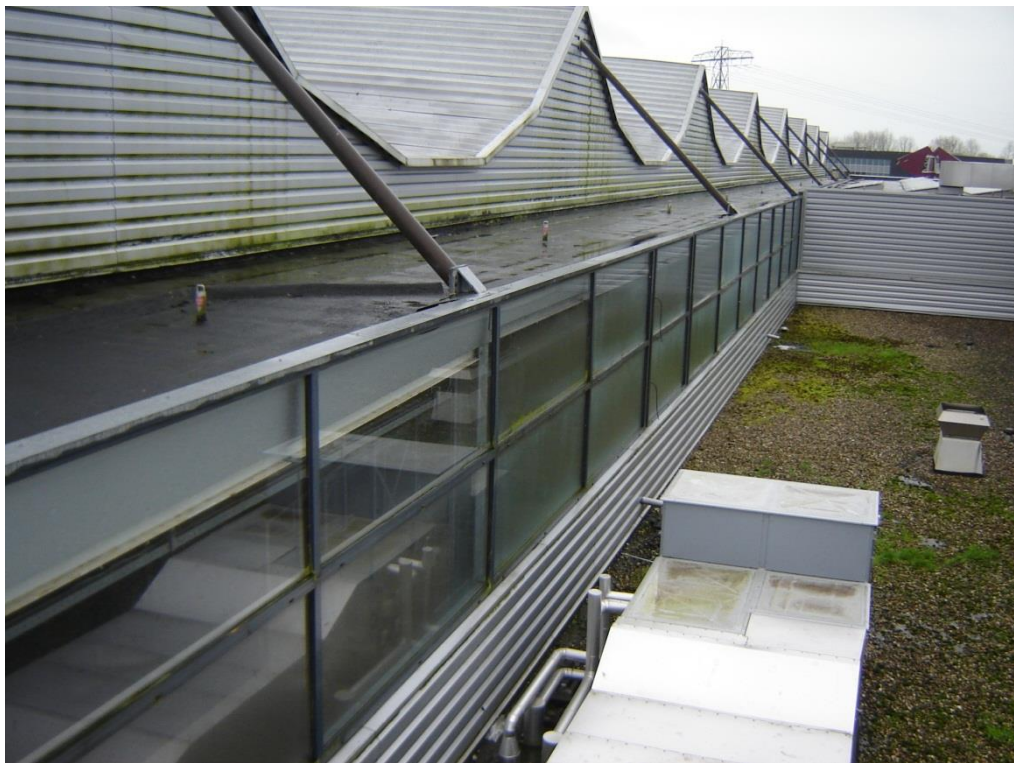
Foto 47: Gevel met glaspui naar eerste verdieping 400 m ijsbaan.
