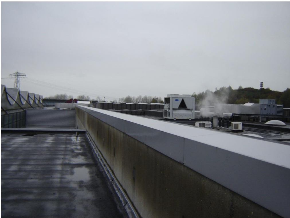
Foto 46: Beton spouwmuur boven dak.
