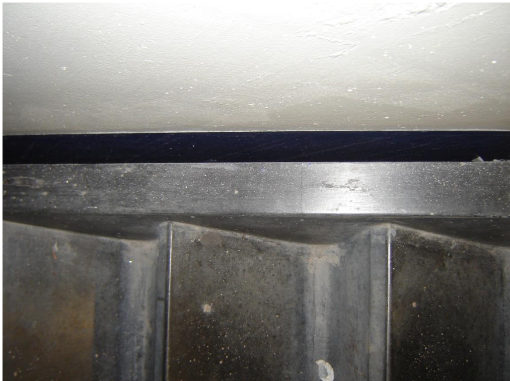
Foto 34: Vrije ruimte tussen wand en prefab trap.
