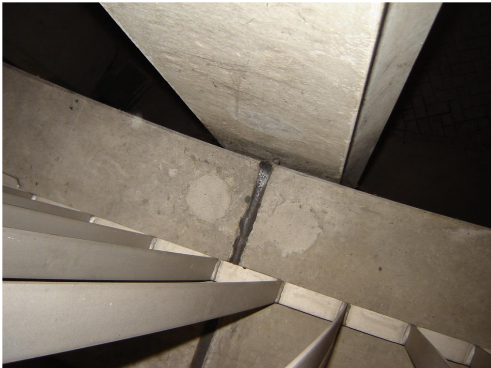
Foto 62: Voeg tussen kolom/balk en vloerelementen koppeling met aangegoten doken.
