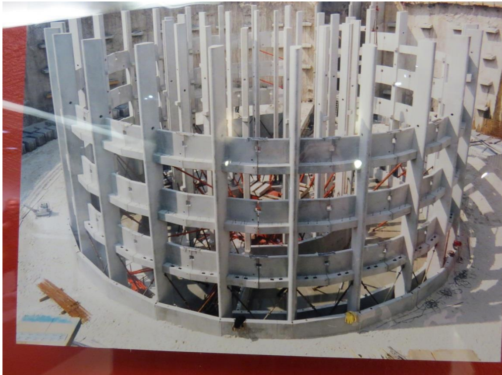
Foto 3: Foto van de bouw. De kolommen met uitragende borstweringselementen en op de neus de doken voor de vloerplaatbevestiging.
