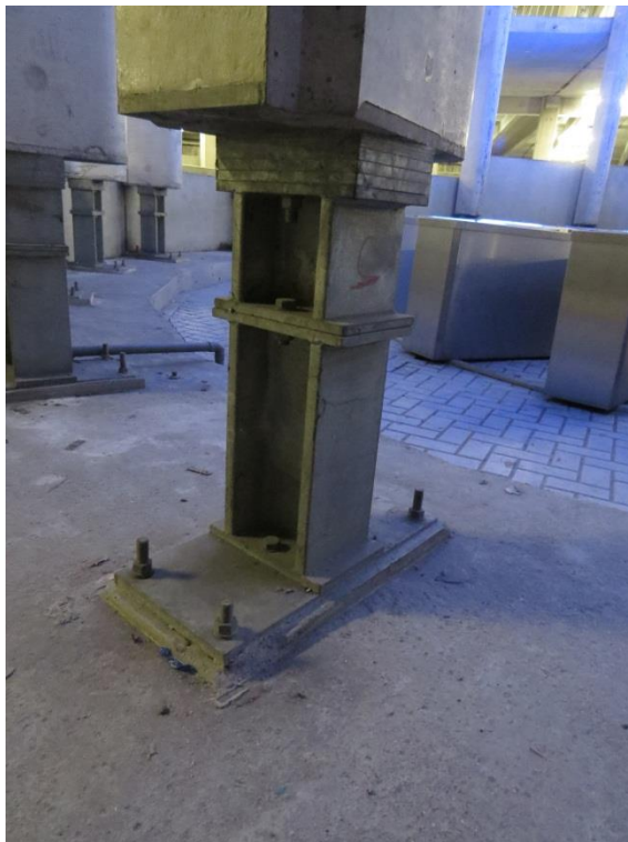
Foto 52: Stalen tussenstuk in de kolom om vijzelen mogelijk te maken.
