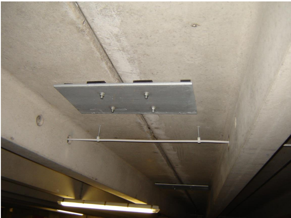
Foto 28: Doorkoppeling van TT-vloerplaten.
