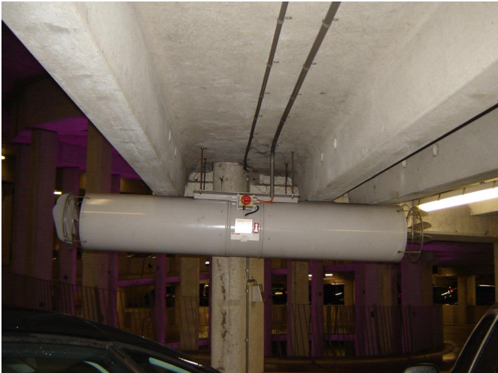
Foto 8: Ophanging stuwdruk ventilator aan draadeinden.
