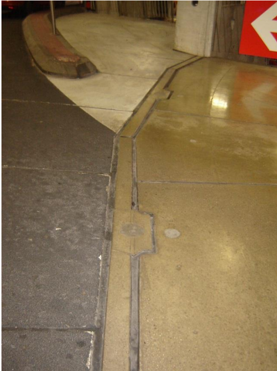
Foto 59: Elastische voeg in aansluiting naar prefab balken.
