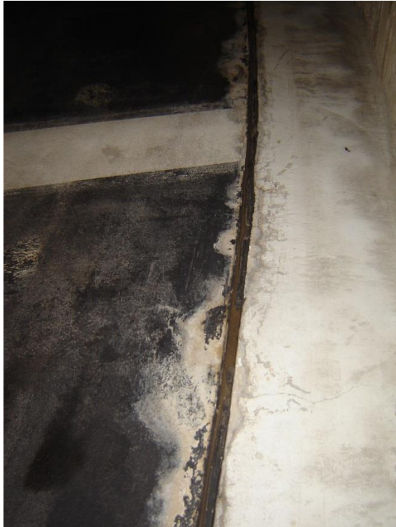
Foto 61: Elastische voeg tussen TT-vloerplaten en de diepwandconstructie.
