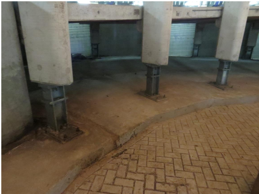
Foto 54: Stalen tussenstuk in de kolom om vijzelen mogelijk te maken.
