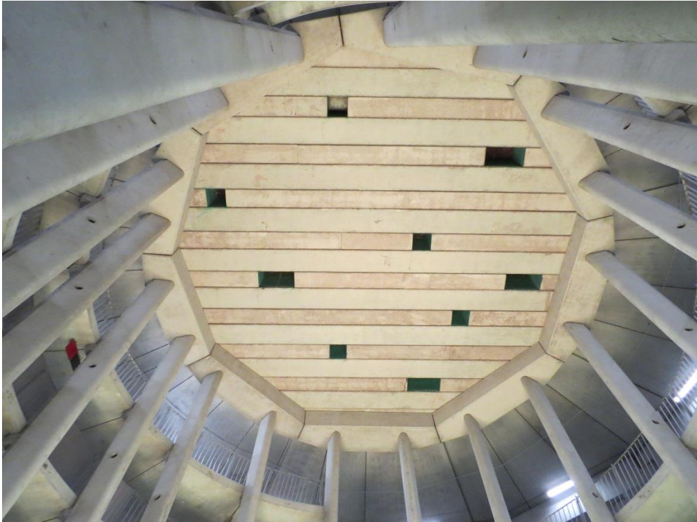
Foto 55: Dek van voorgespannen railliggers.
