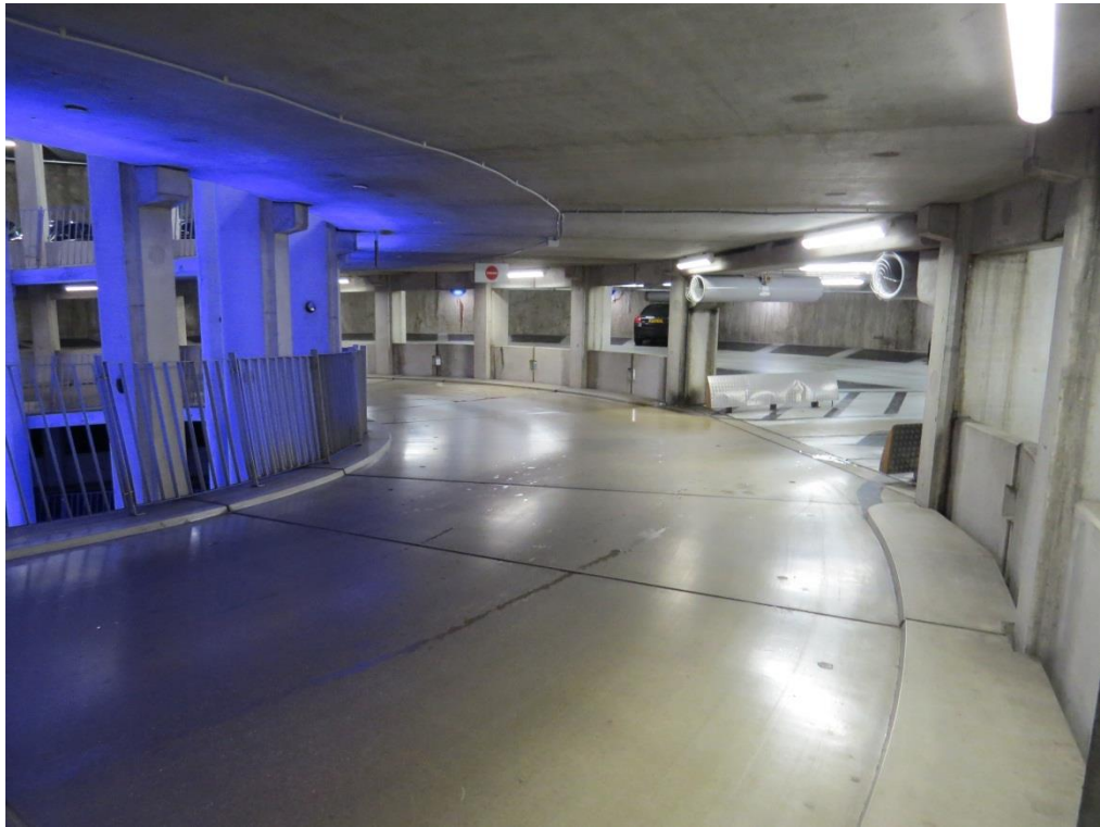
Foto 35: Binnenring in de parkeergarage.
