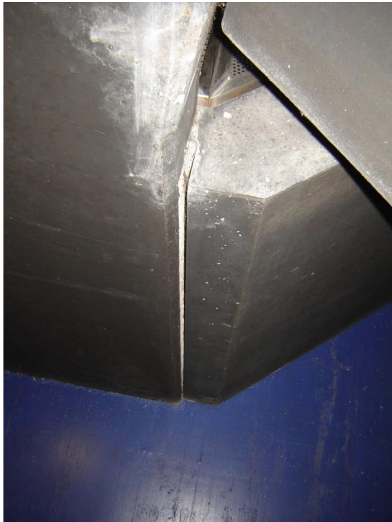
Foto 33: Oplegging prefab trap met neus.
