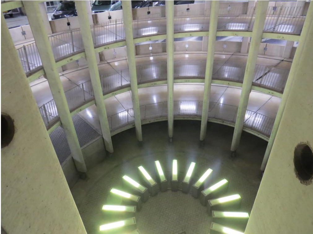
Foto 47: Prefab kolommen in één keer doorgaand over de gehele hoogte.
