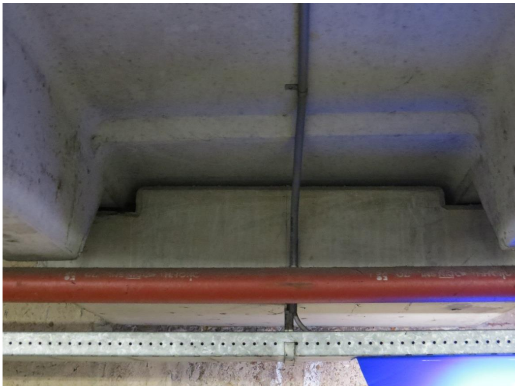
Foto 36: Oplegnok aan diepwand.
