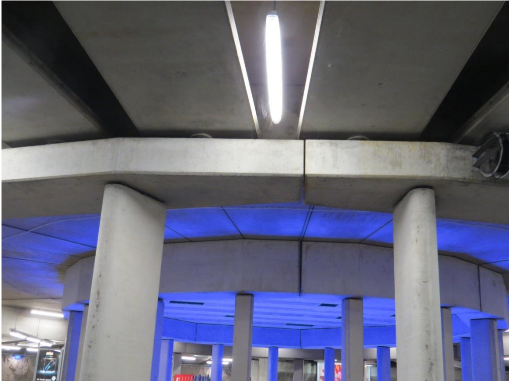
Foto 43: Voorgespannen railbalken als kelderdek.
