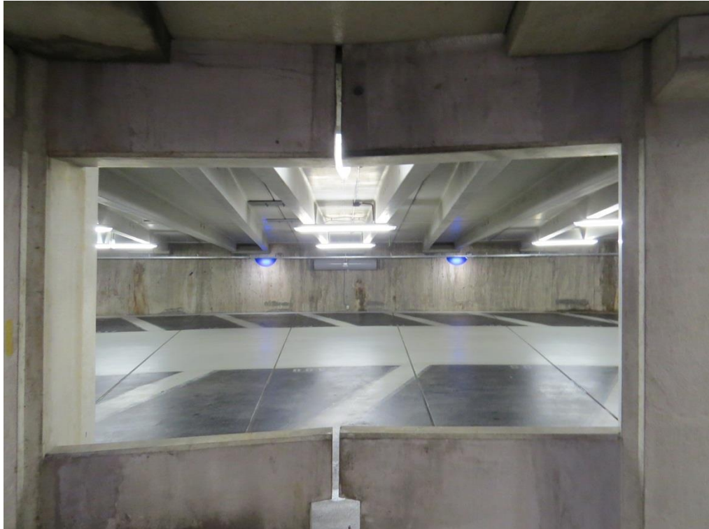
Foto 57: Doorkijk vanuit het midden naar de diepwand.
