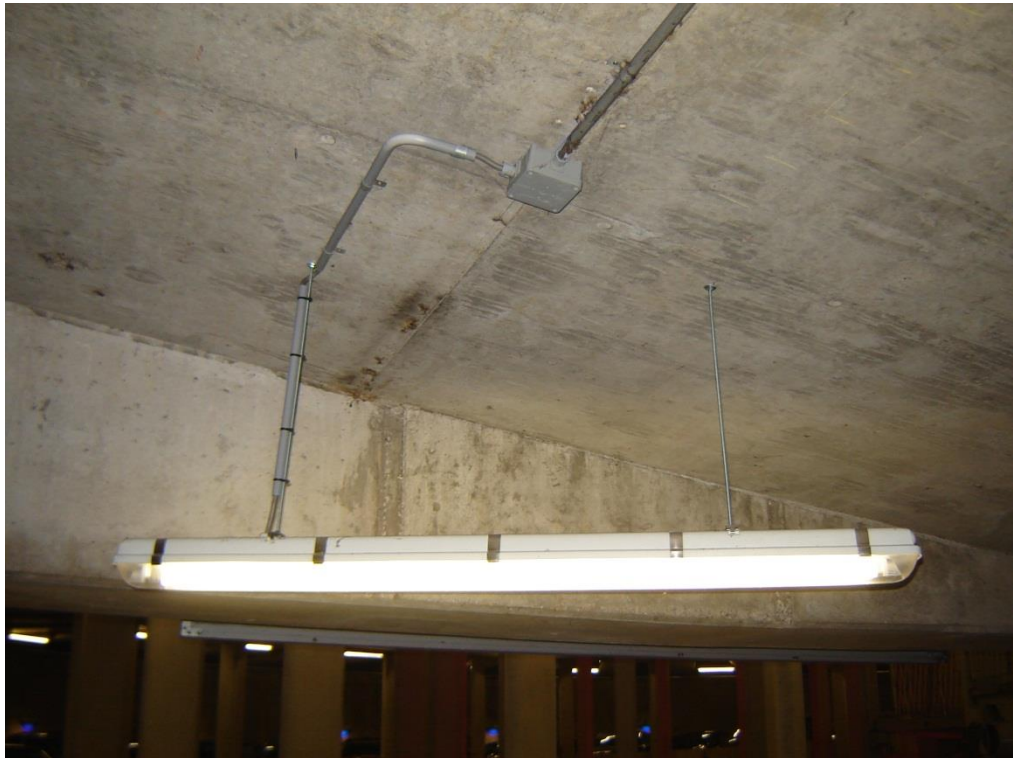
Foto 9: Ophanging verlichting aan lange draadeinden t.p.v. de inrit.
