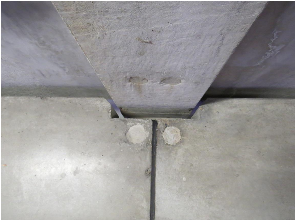
Foto 56: Voeg tussen kolom/balk en vloerelementen koppeling met aangegoten doken.
