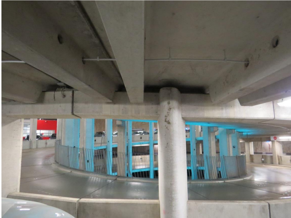
Foto 37: Aan de kolom geïntegreerde prefab borstweringselement t.b.v. oplegging TT-vloerplaten.
