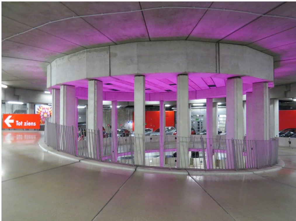
Foto 42: Prefab kelderdek op prefab balken op de kolommen.
