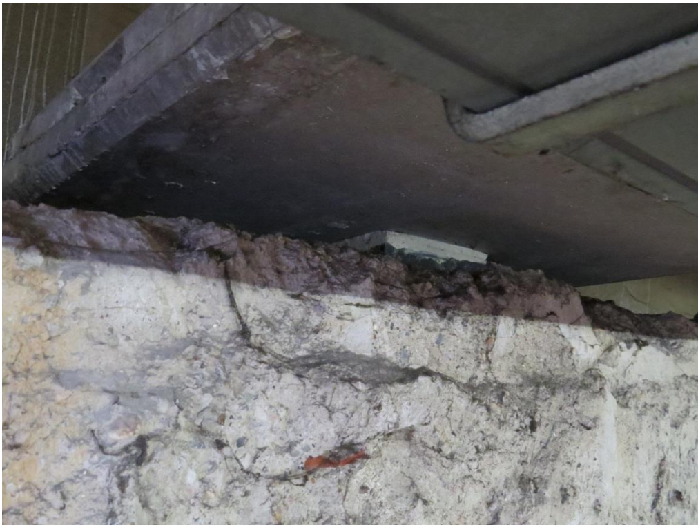
Foto 44: Oplegging voorgespannen railbalken op diepwand.
