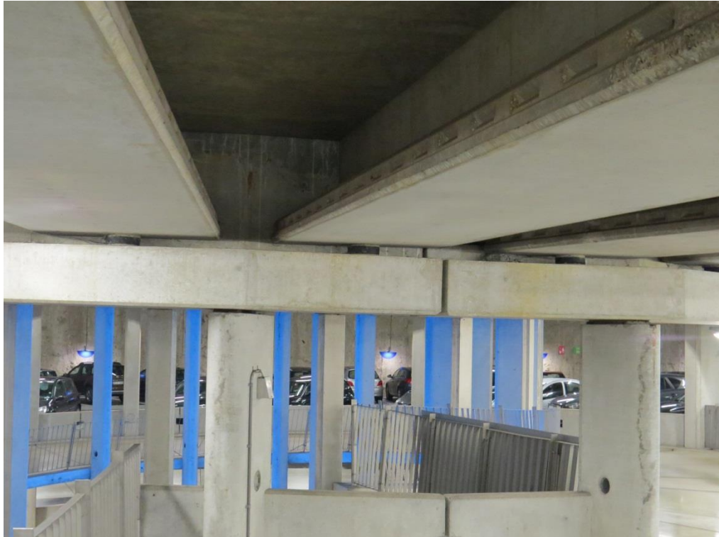
Foto 45: Voorgespannen railbalken als kelderdek.
