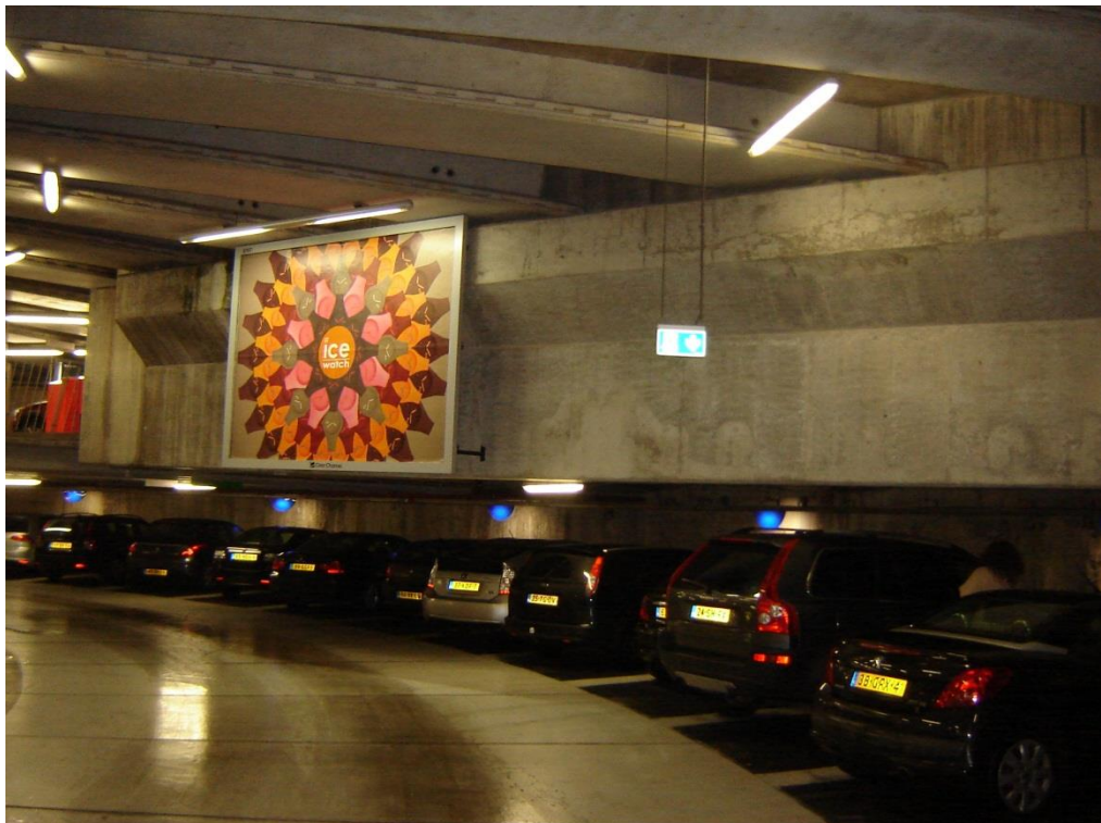
Foto 6: Zijkant voorgespannen inritwand met reclame bord.
