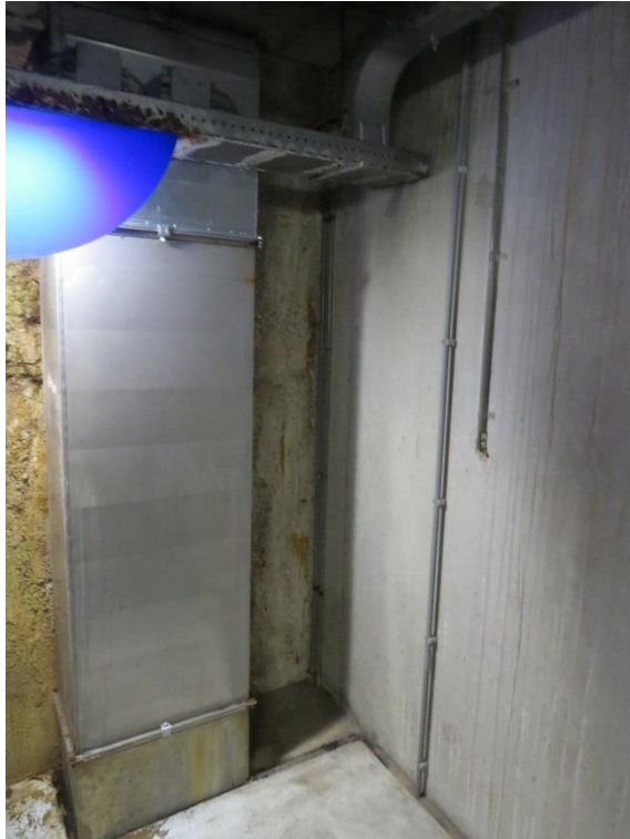
Foto 41: Kanaaldoorvoer.
