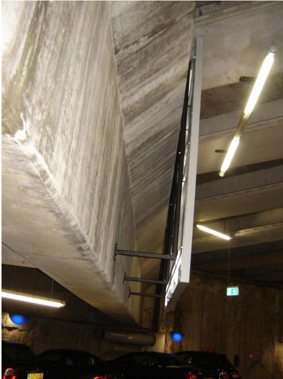
Foto 7: Bevestiging reclame bord.
