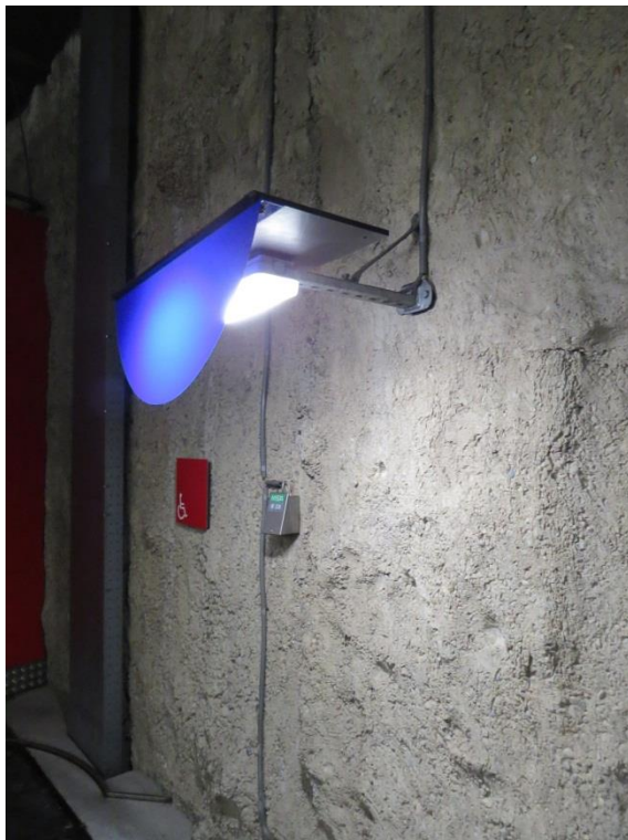
Foto 46: Verlichting aan de diepwand.
