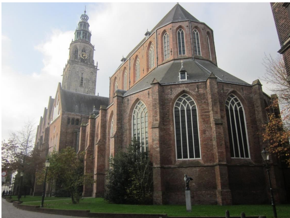
Figuur 6, zuid- en oostgevel van het koor
