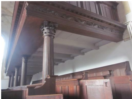
Figuur 29, Balkon met balustrade dragend op kolommen
