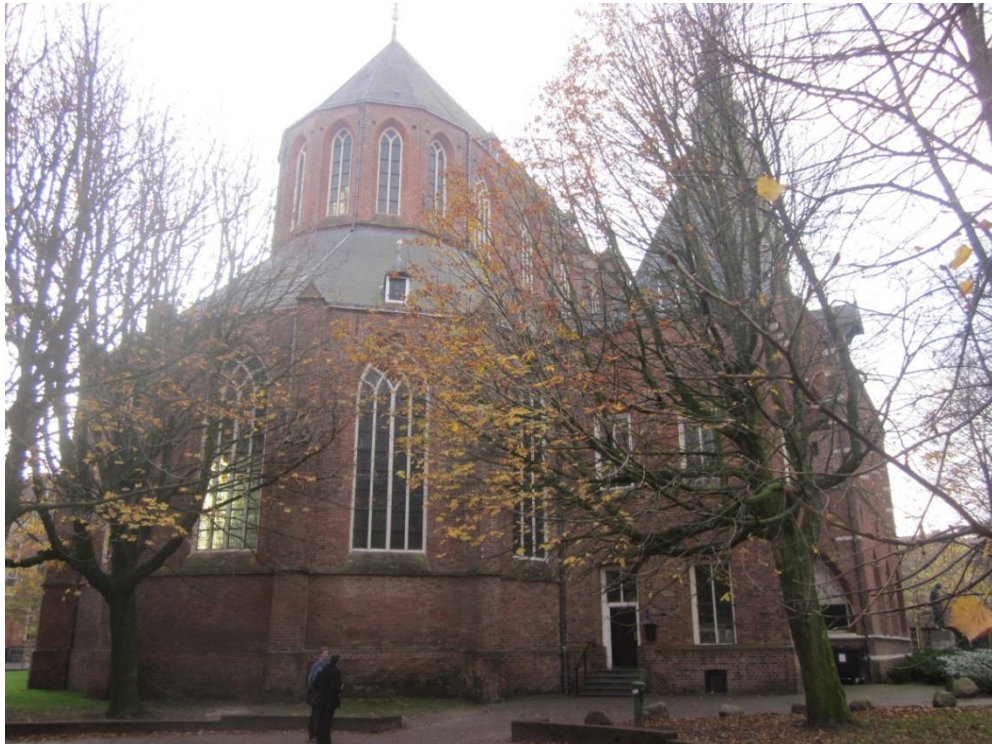
Figuur 7, oost- en noordgevel van het koor en de kapel
