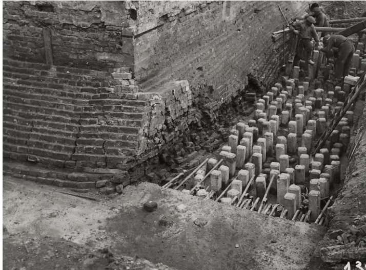
Figuur 44, versterking van de fundering van de Martinitoren
