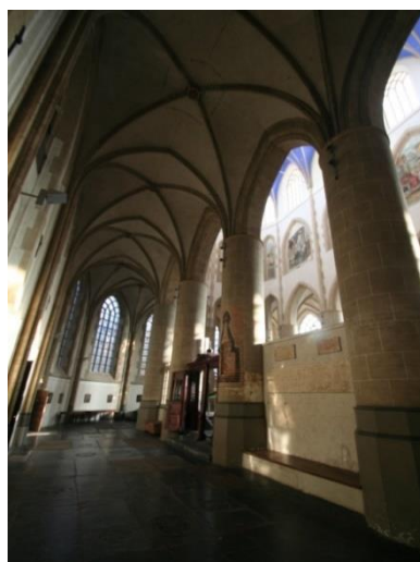
Figuur 23, natuursteen vloerafwerking koor en pleisterwerk op gewelven
