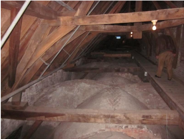
Figuur 25, bovenzijde gemetselde gewelven
