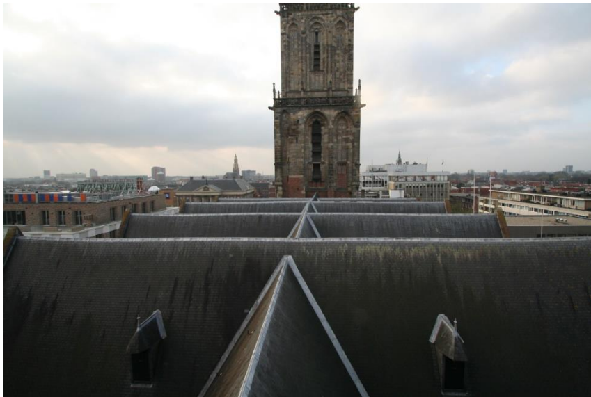
Figuur 38, langs- en dwarskappen van het middenschip met zicht op de Martinitoren
