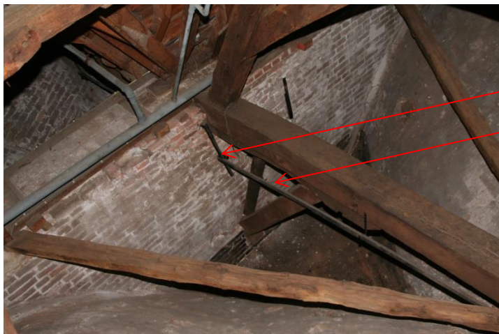
Figuur 42, koppeling van het muuranker van de steunbeer aan de gesmede trekstang. Zie ook de gemetselde gewelven onder en rechts op de foto
