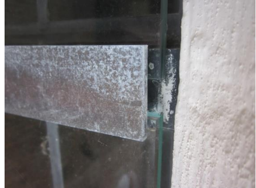
Figuur 14, bevestiging voorzetrampen t.p.v. brugstaaf
