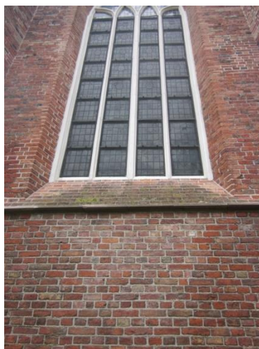
Figuur 12, gemetselde waterslagen
