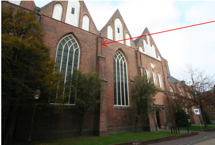
Figuur 41, zijgevel met penanten in langsricting en steunberen in dwarsrichting. Zie ook de muurankers aan de bovenzijde van de steunberen
