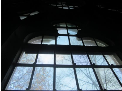
Figuur 13, voorzetrampen aan buitenzijde kapel
