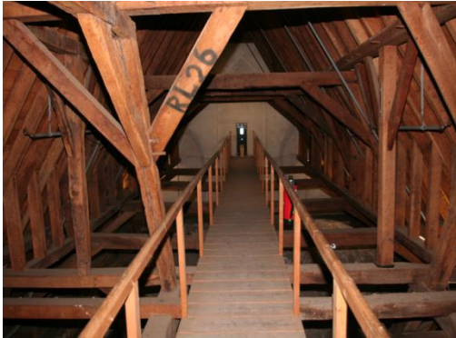
Figuur 16, houten kapconstructie middenschip
