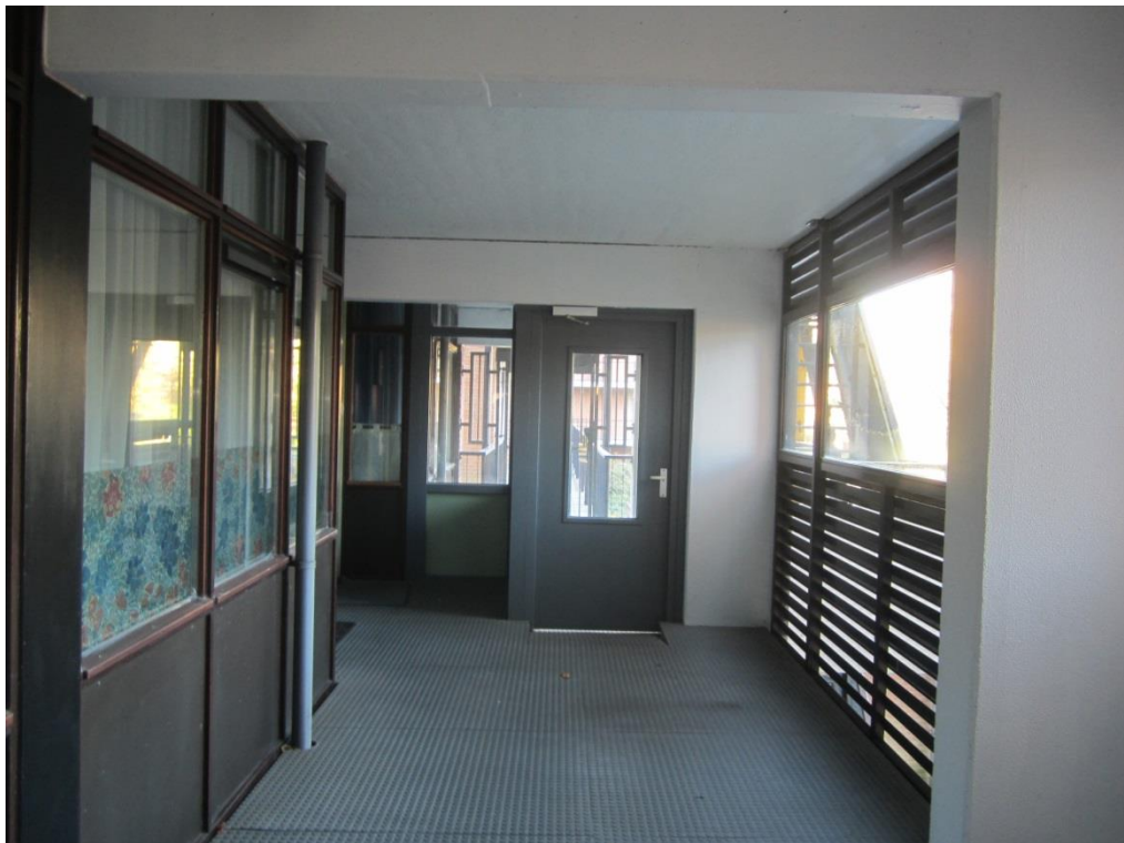
Foto C4: Beton portalen t.b.v. galerij
