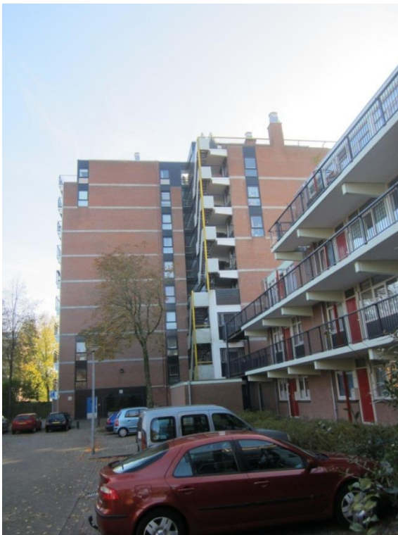
Foto B4: Gevelaanzicht Noordzijde
