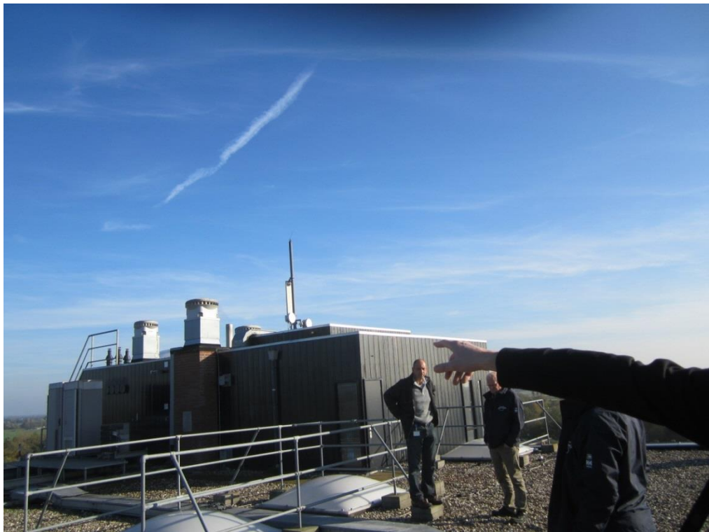
Foto B 8: Overzicht dak met lichtkeopels
