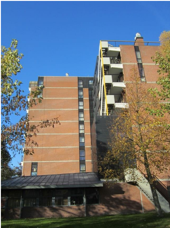
Foto B3: Gevelaanzicht Zuidzijde
