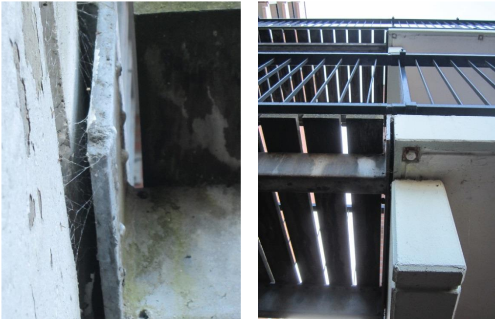
Foto B15: Verankering Links en Rechts van loopbrug
