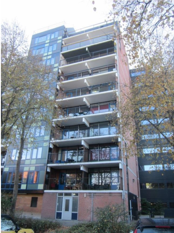
Foto B9: Stalen spijlen hekwerk
