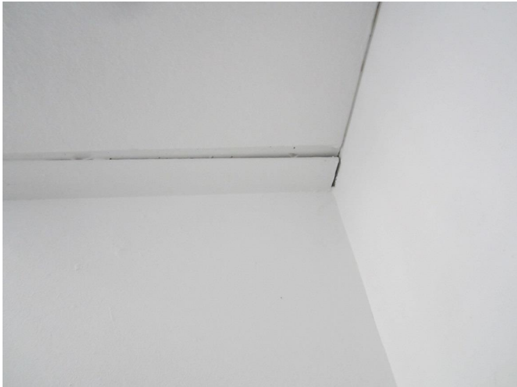
Foto B13: Oplegging tussenbordes
