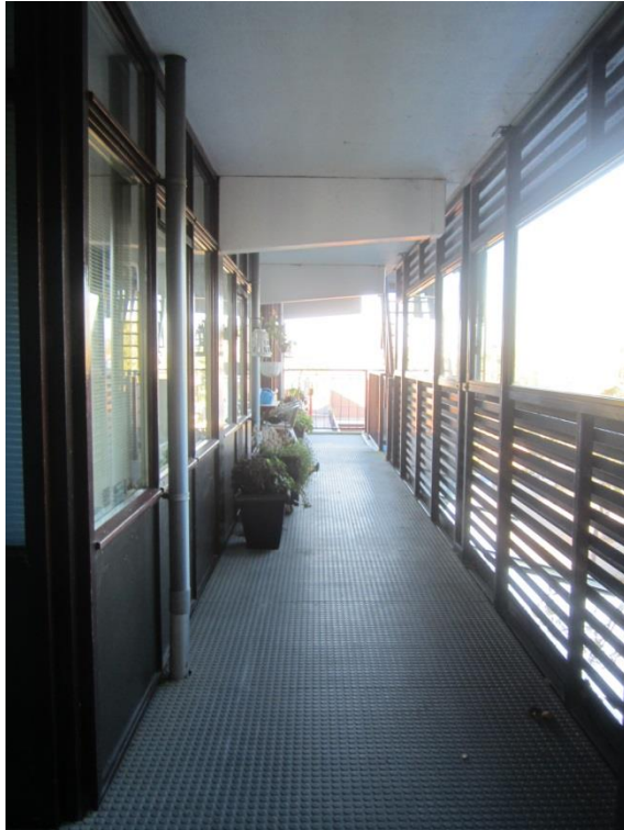
Foto C3: Beton consoles t.b.v. balkon en galerij
