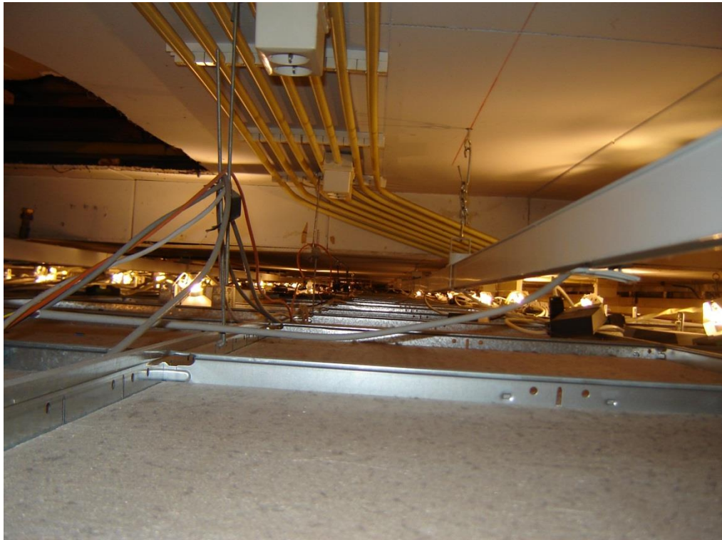
Foto 5: Boven het plafond: onderzijde balklaag brandwerend bekleed.
