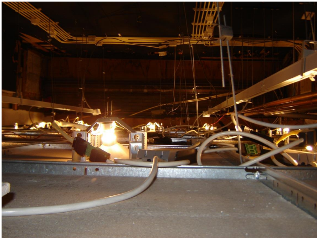
Foto 6: Ophanging plafond, installaties en verlichting.
