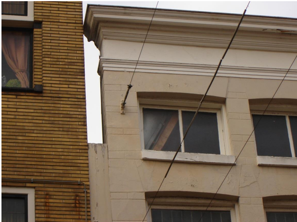
Foto 2: Minimale dilatatiebreedte naar naburige pand. Opening afgedicht met hout.
