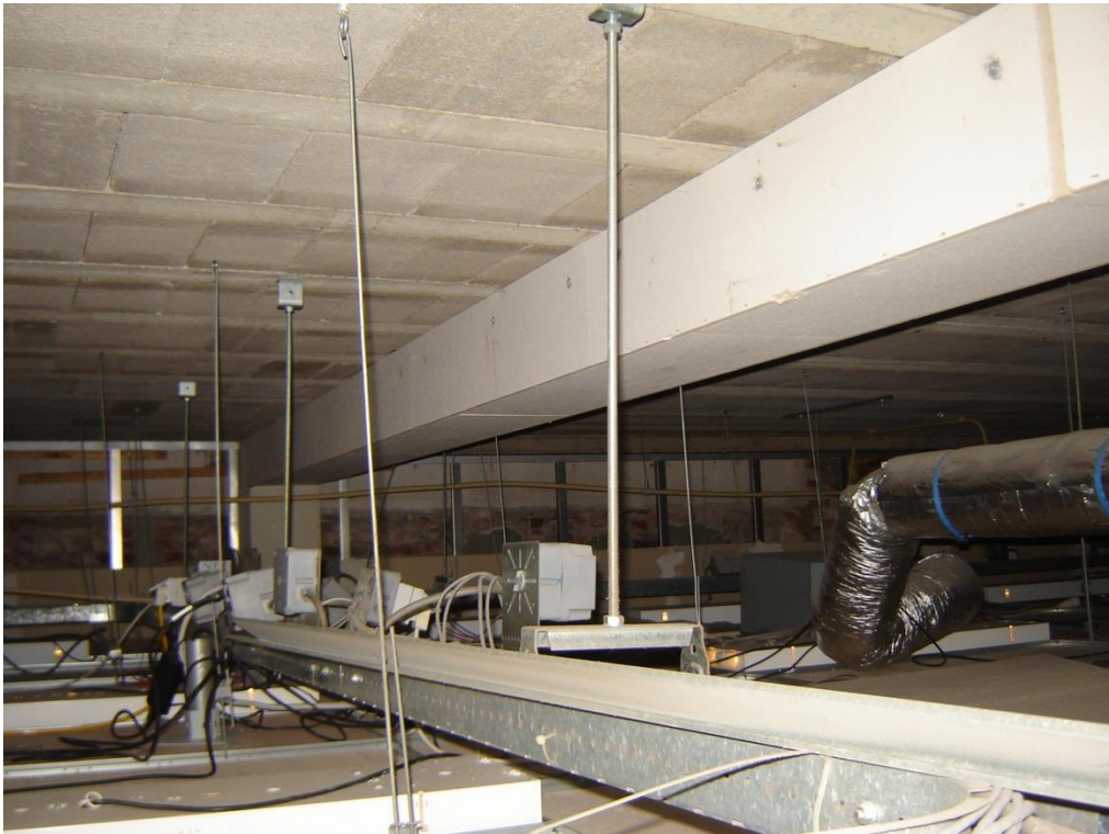
Foto 5: Brandwerend beklede stalen balken boven verlaagd plafond.
