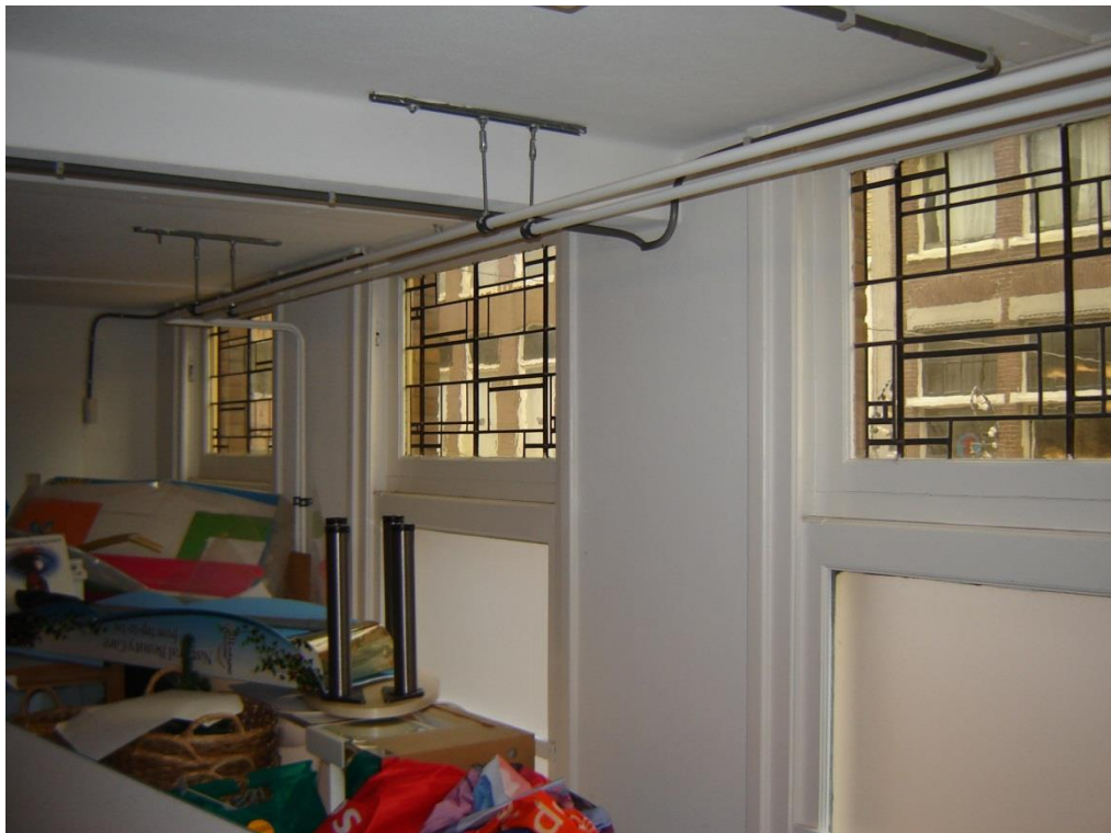
Foto 8: Voorgevel eerste verdieping.
