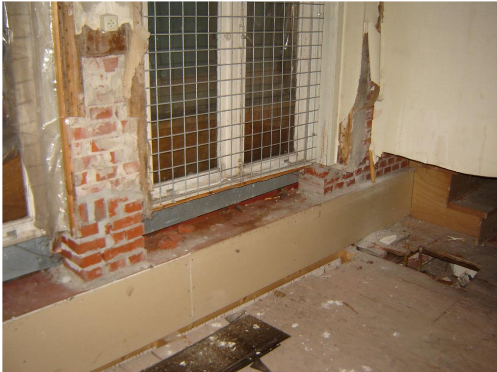
Foto 11: Stalen balk tweede verdieping onder achtergevel bovenbouw (brandwerend bekleed).
