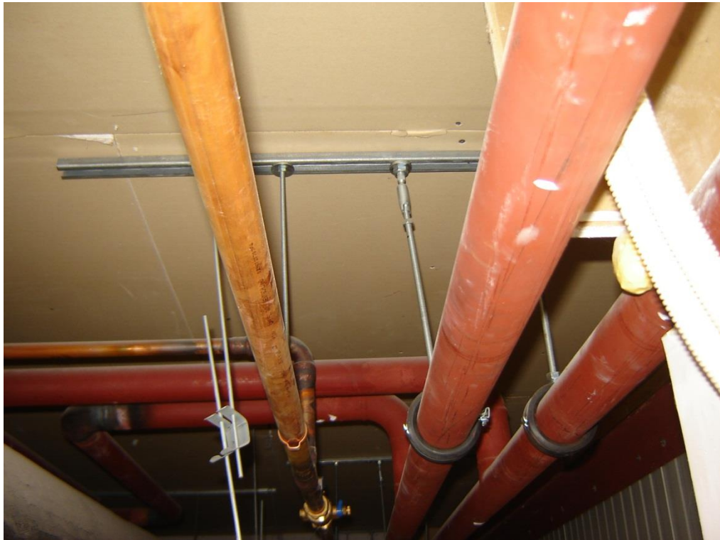
Foto 7: Installaties en brandwerende bekleding boven plafond eerste verdieping.
