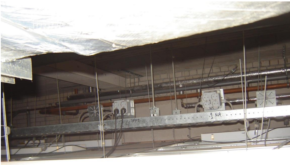
Foto 5: Brandwerend beklede stalen balken boven verlaagd plafond.
