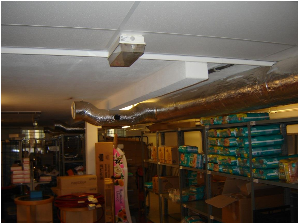
Foto 9: Stalen balk en kolommen op de eerste verdieping (brandwerend bekleed).
