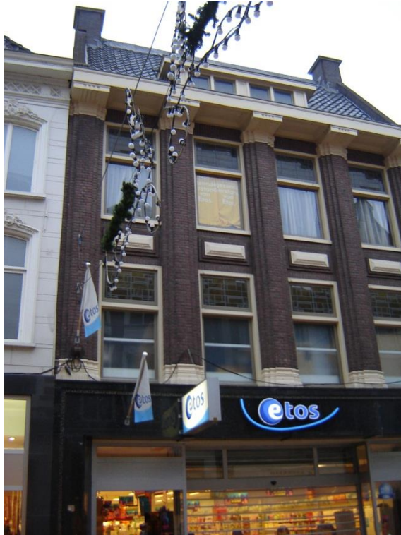
Foto 1: Voorgevel bovenhuis pand 27-29.
