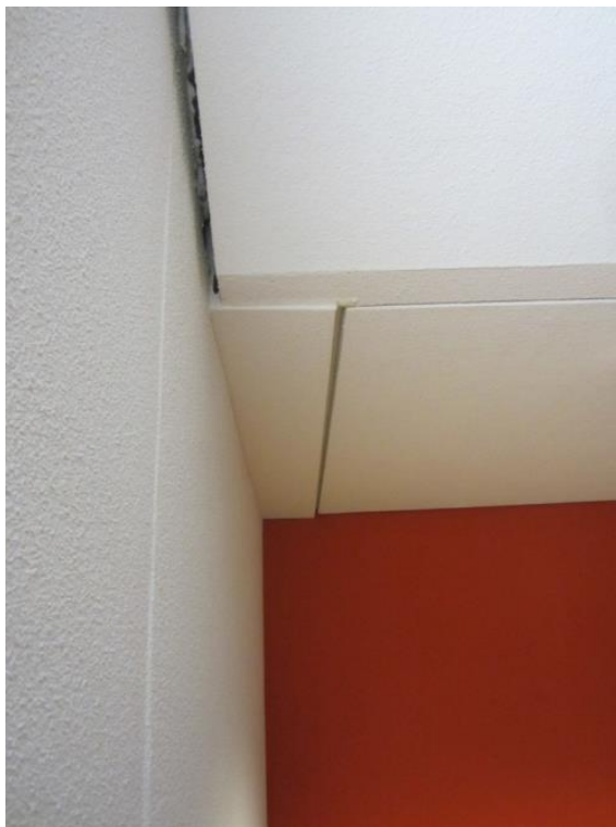
Foto 18: Oplegging tussenbordes op hoekstaal
