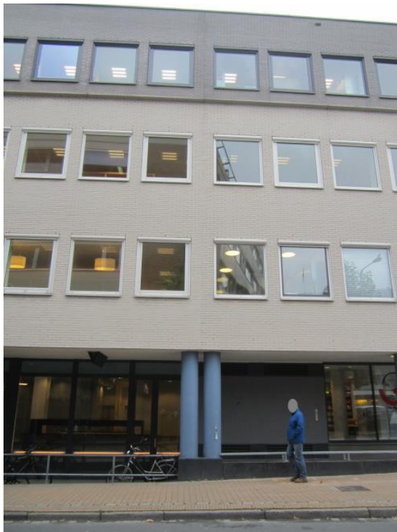
Foto 5: Dilatatie tussen verschillende bouwdelen vanaf straat
