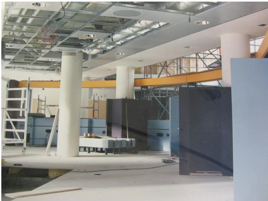
Foto 20: Foto van renovatie, verhoogde vloer en leidingen
