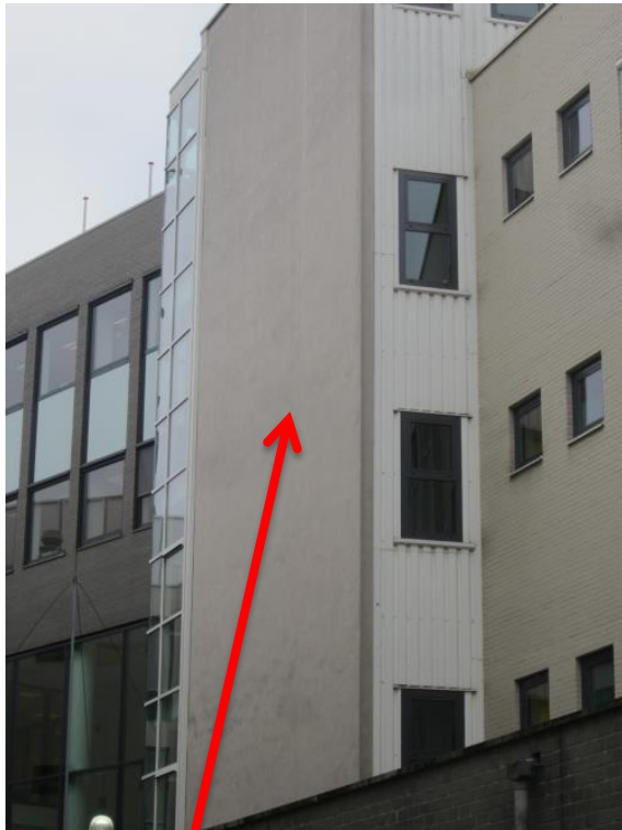
Foto 11: Stucwerk op buitengevelisolatie
