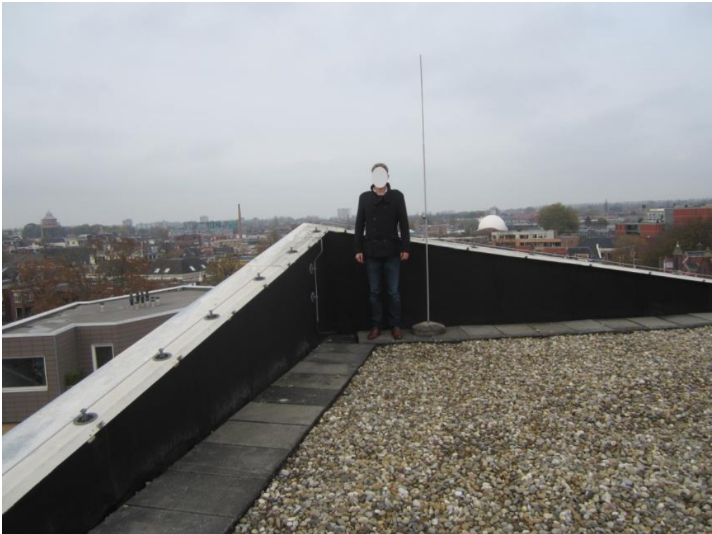
Foto 13: Oplopende gemetselde dakrand
