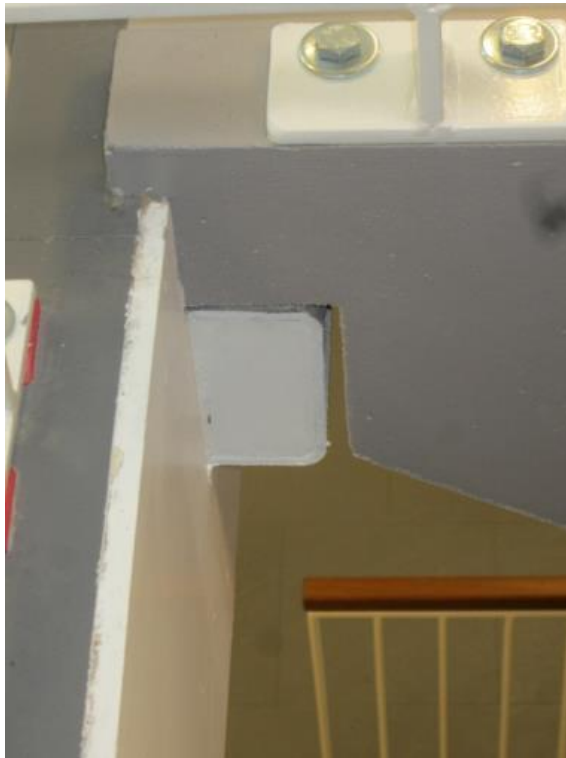
Foto 17: Oplegging betonnen steektrap
