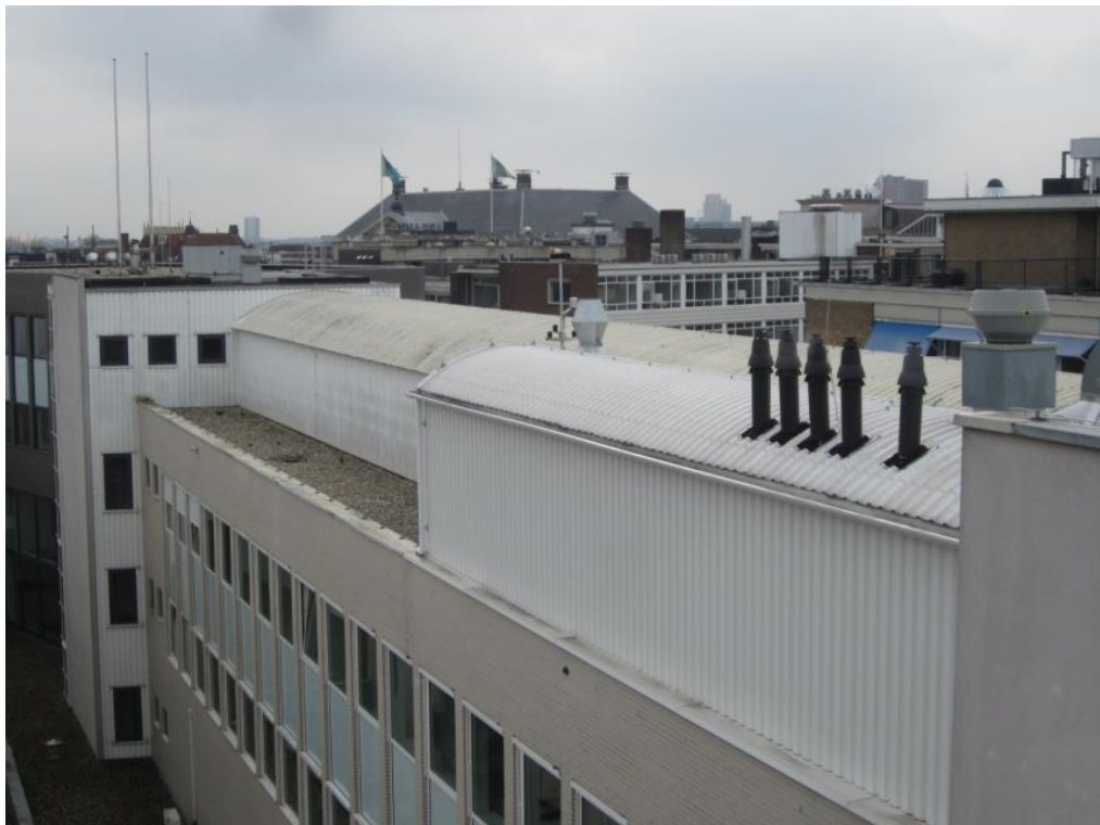
Foto 12: Stalen gevel- en dak beplating
