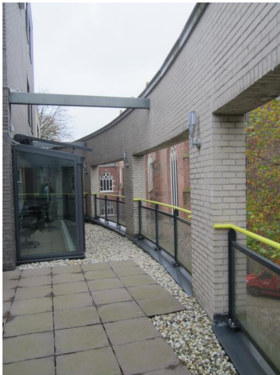
Foto 6: Schijfgevel afgesteund op bouwdeel C
