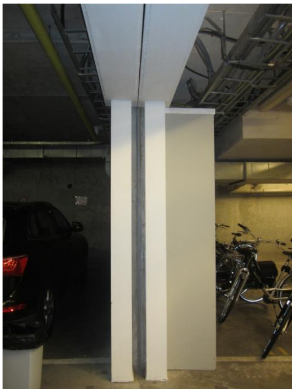
Foto 3: Dilatatie tussen verschillende bouwdelen vanuit kelder
