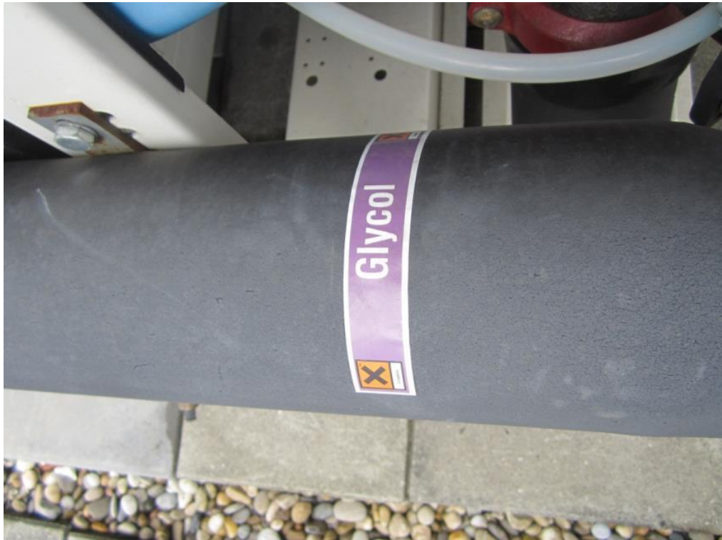
Foto 23: Koeling: leiding koelvloeistof
