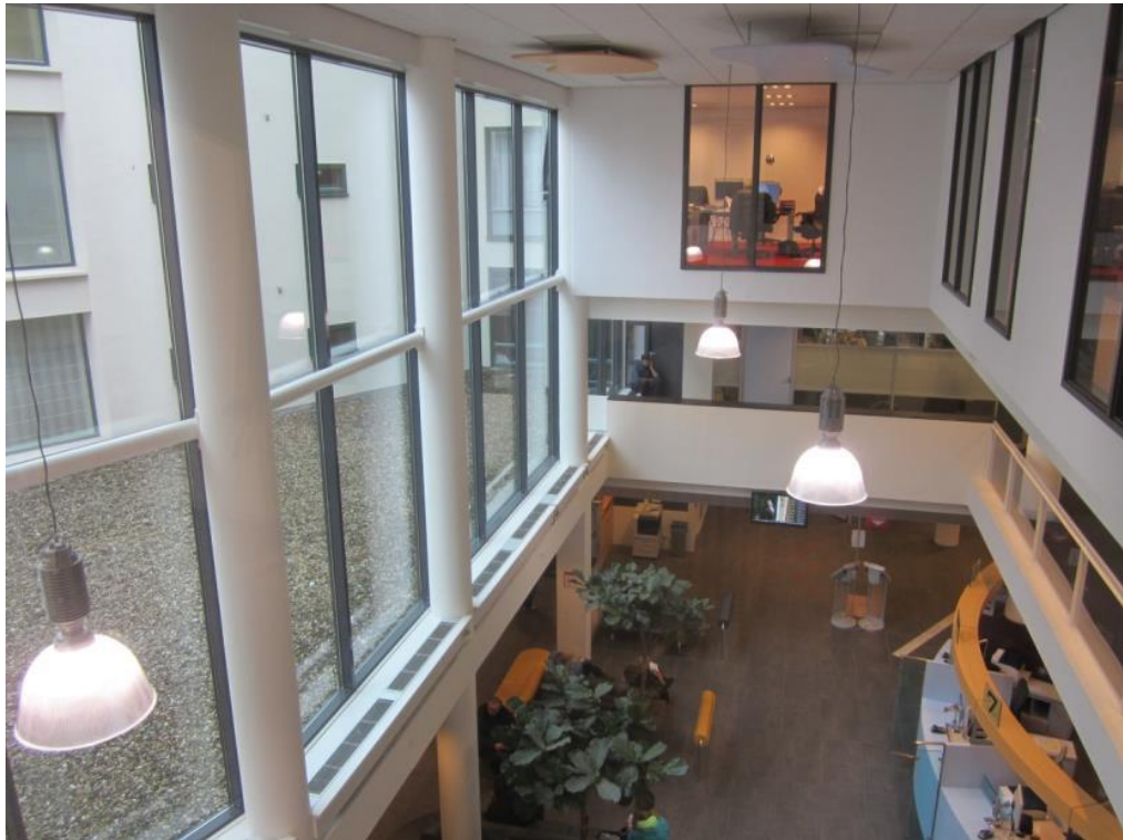
Foto 1: Betonnen raamwerk in gevelvlak ter plaatse van vide in bouwdeel C
