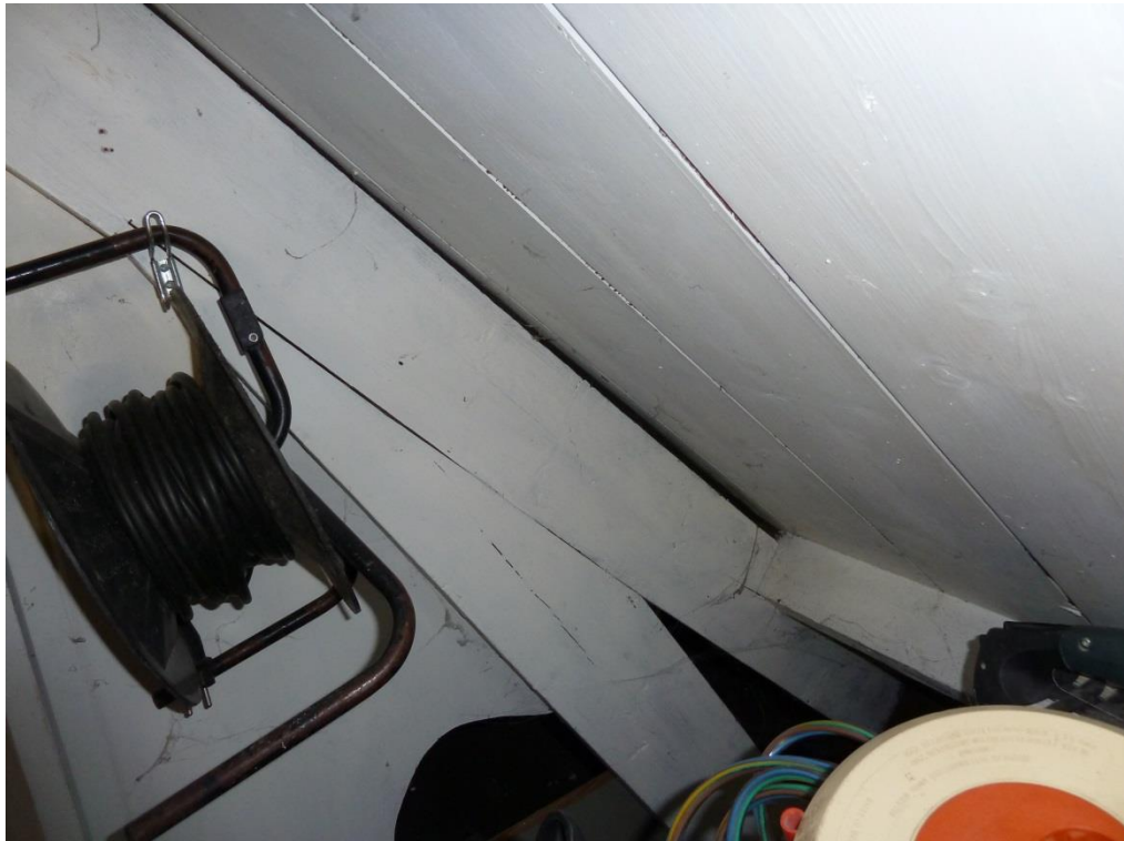
Foto 29: Aansluiting Houten spant met gordingen
