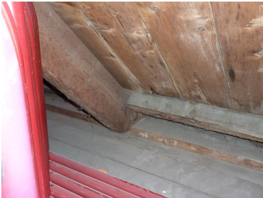
Foto 30: Aansluiting houten spant met de muurplaat
