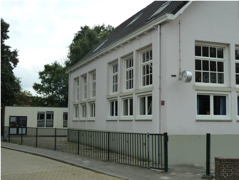
Foto 2: Zijgevel (Zuid - Oostzijde)
