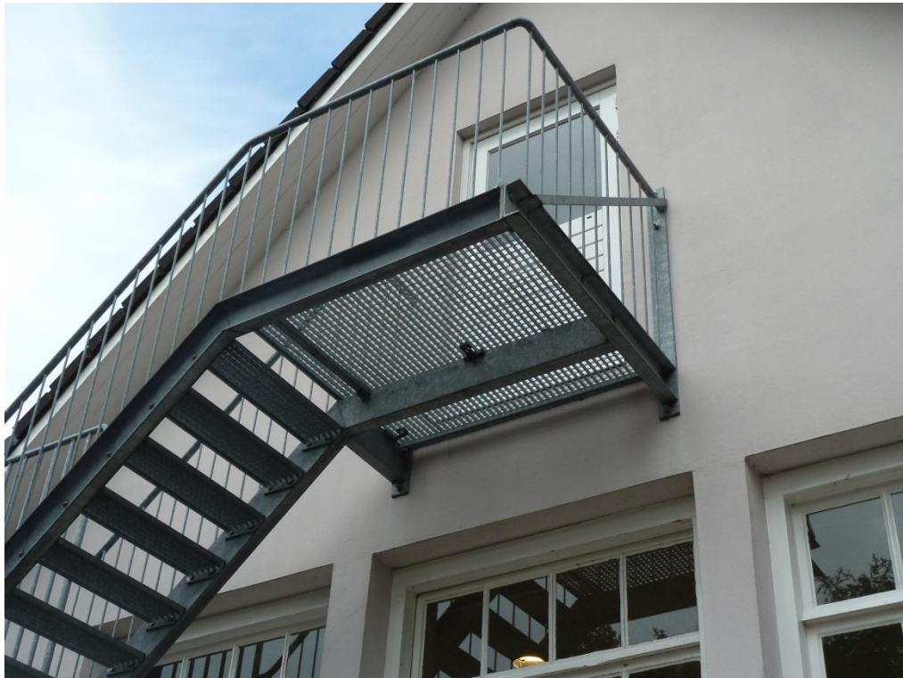
Foto 25: Bevestiging vluchttrap aan de metselwerk achtergevel (overzicht)
