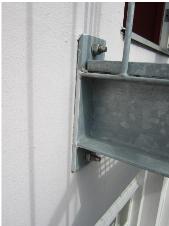
Foto 26: Bevestiging vluchttrap aan de metselwerk achtergevel (detail)
