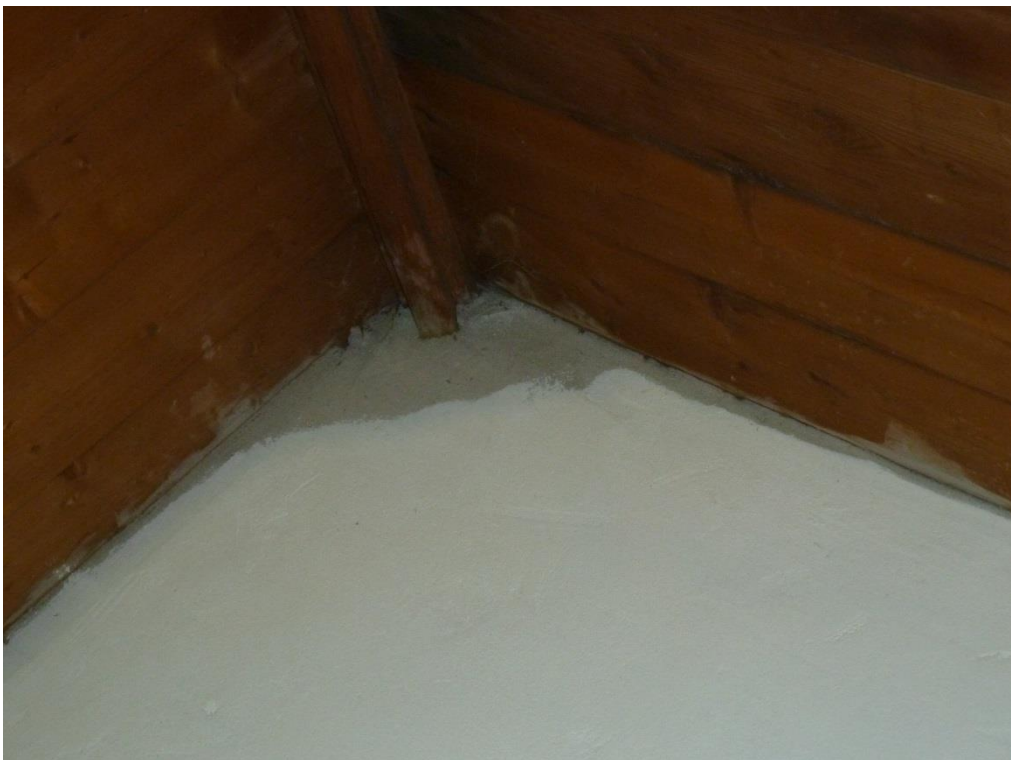
Foto 32: Aansluiting dakconstructie met topgevel
