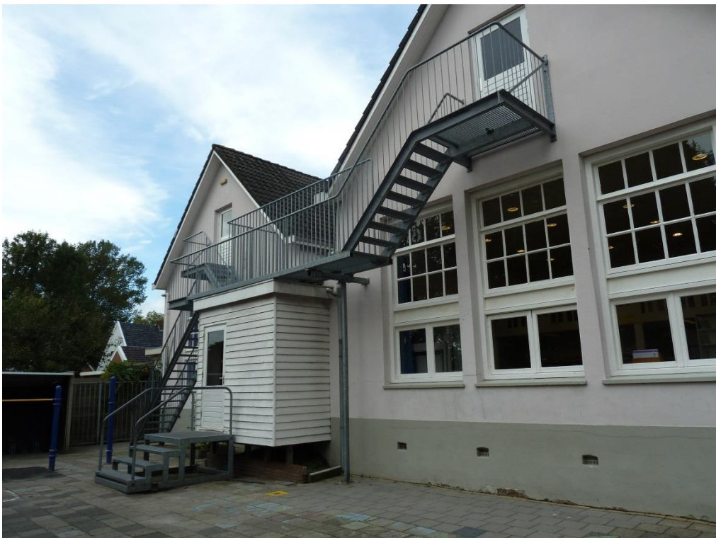
Foto 3: Achtergevel (Zuid - Westzijde)
