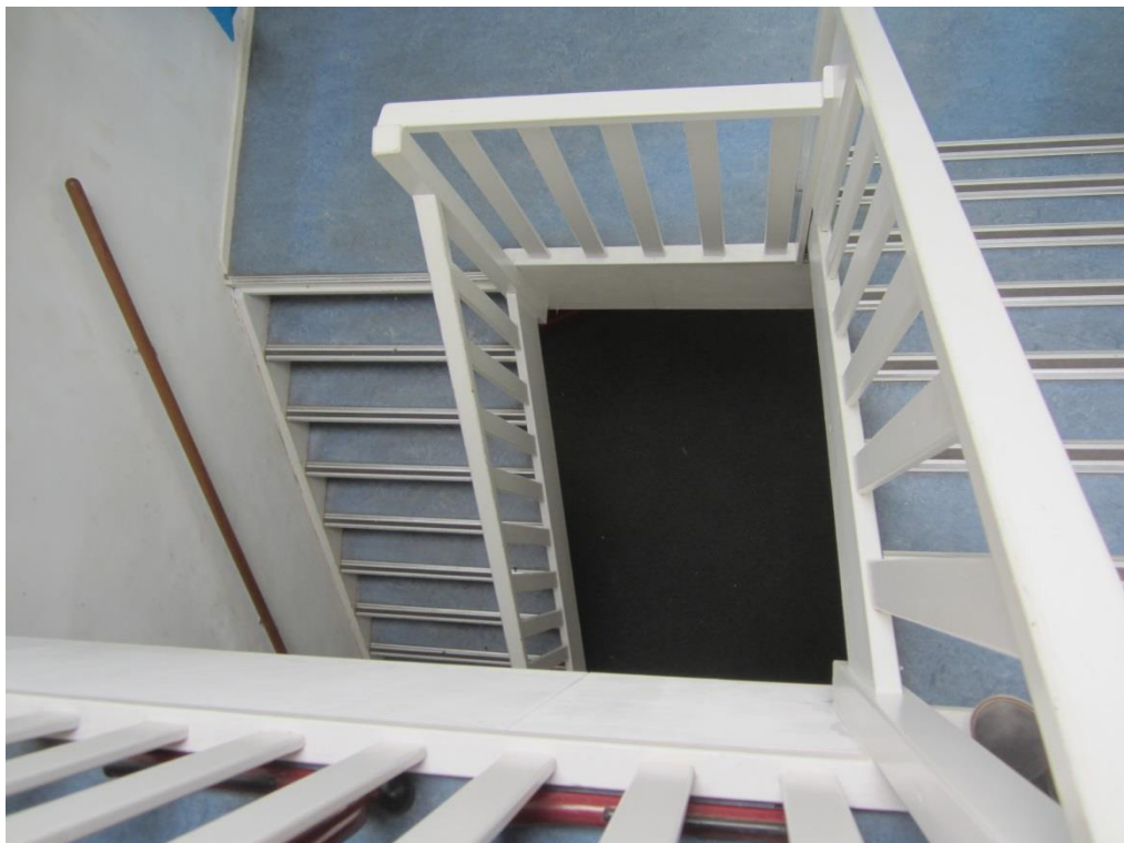
Foto 10: Trappenhuis 1 e verdieping
