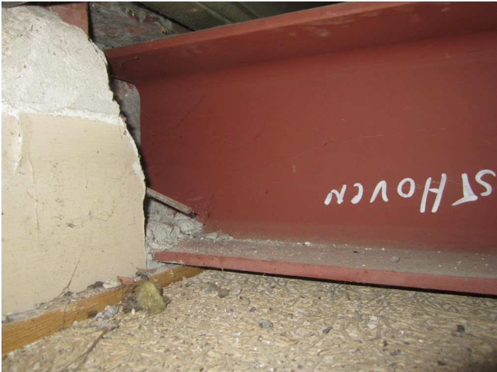
Foto 19: 1 e verdiepingvloer; oplegging stalen onderslagbalk op metselwerk wand (1)
