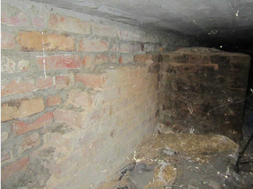
Foto 7: Oplegging betonnen begane grondvloer op metselwerk
