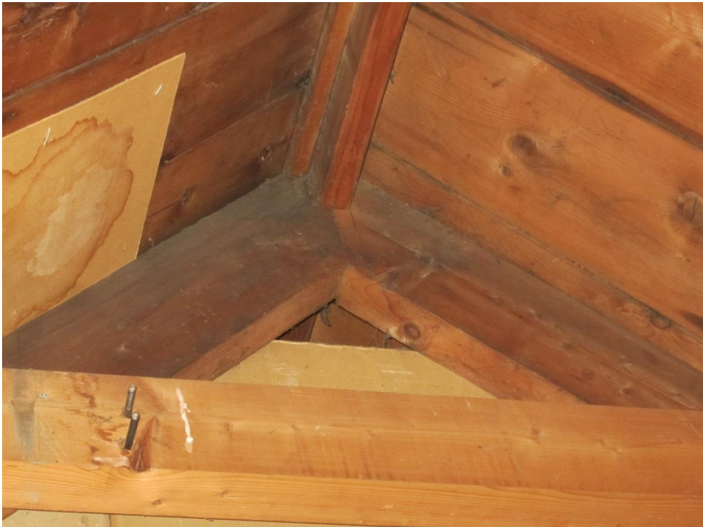
Foto 31: Houten spant t.p.v. de nok
