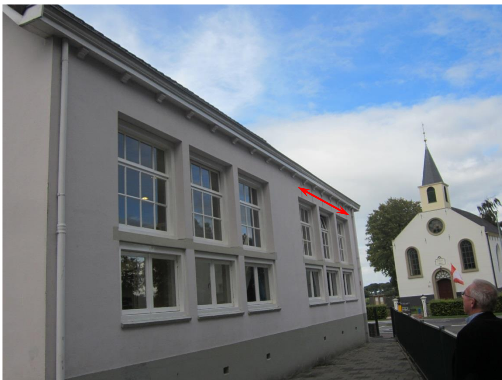
Foto 24: Verankering van de verdiepingvloer aan de Zuid - Westzijde
