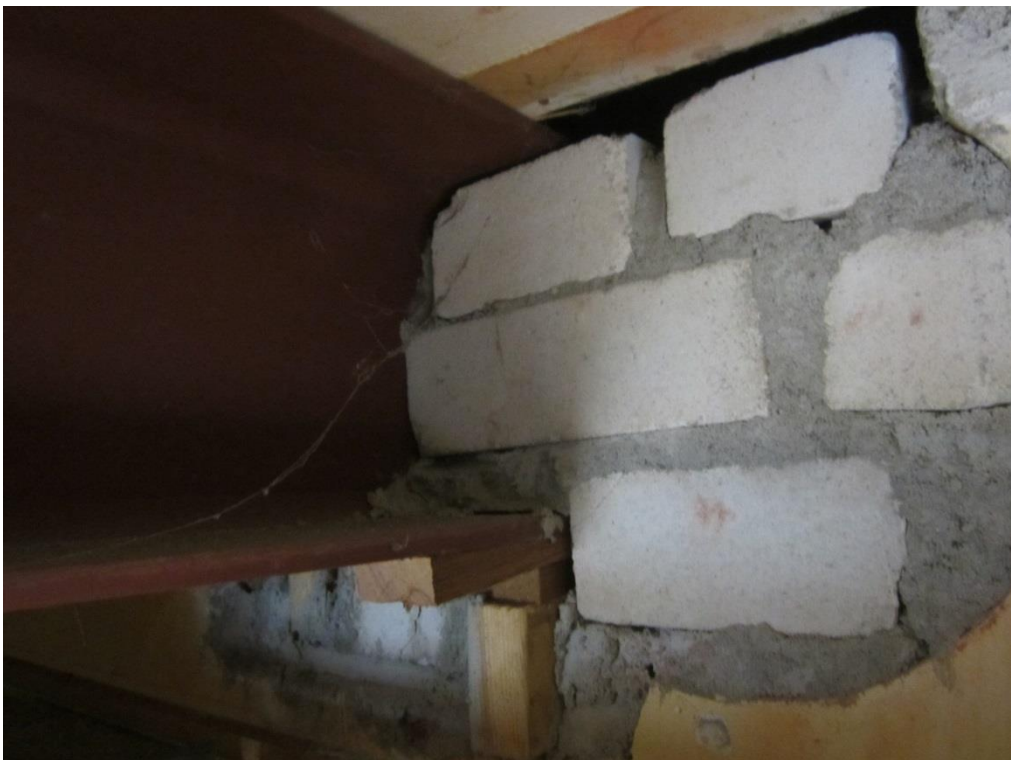
Foto 20: 1 e verdiepingvloer; oplegging stalen onderslagbalk op metselwerk wand (2)
