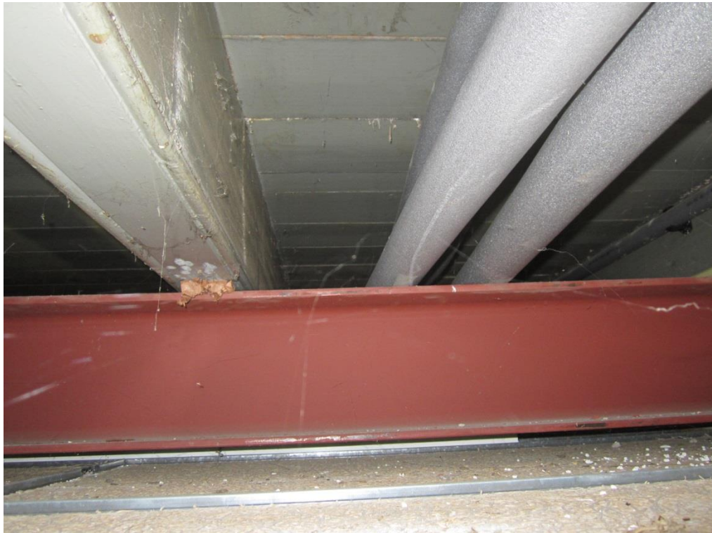
Foto 21: 1 e verdiepingvloer; houten balklaag op stalen onderslagbalken
