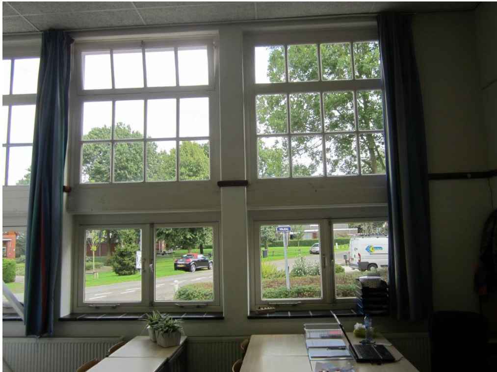
Foto 15: Metselwerk penant in de gevel
