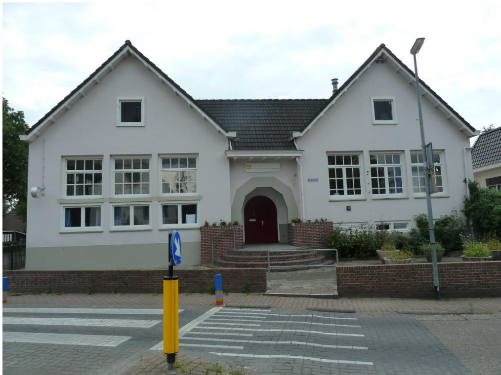
Foto 1: Voorgevel (Noord - Oostzijde)
