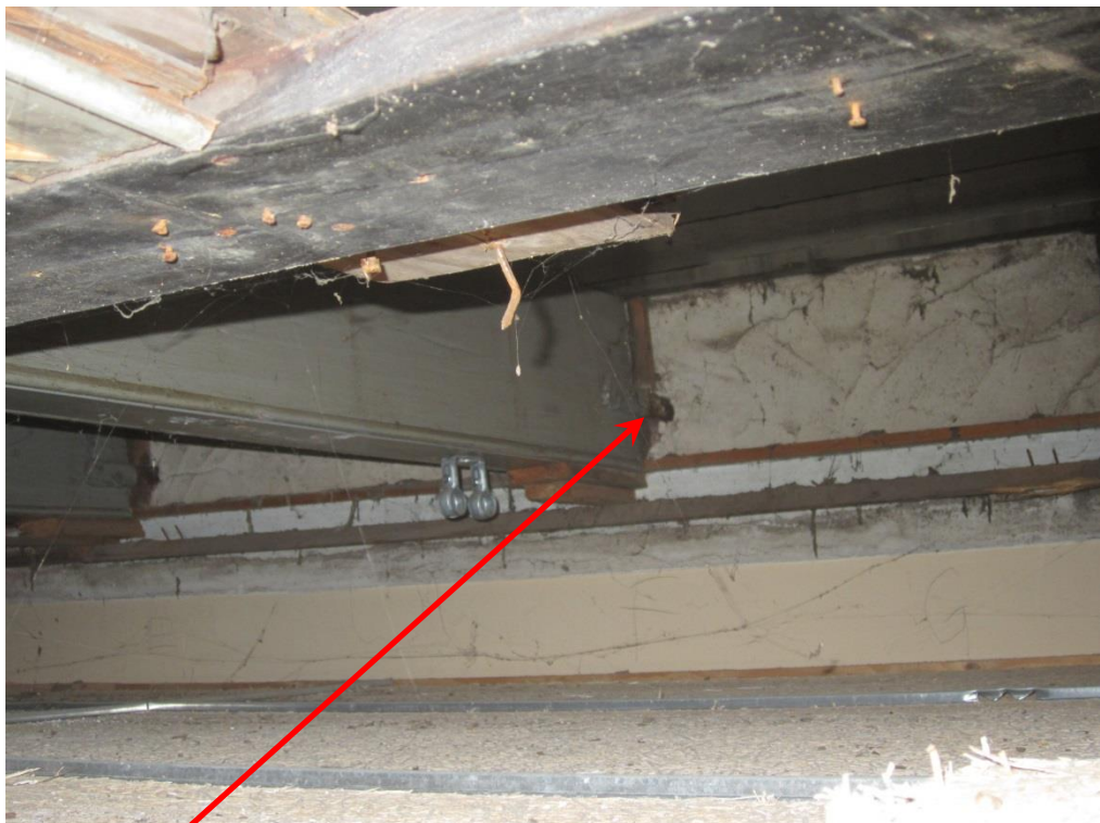
Foto 22: Verankering van de verdiepingvloer aan metselwerkwand
