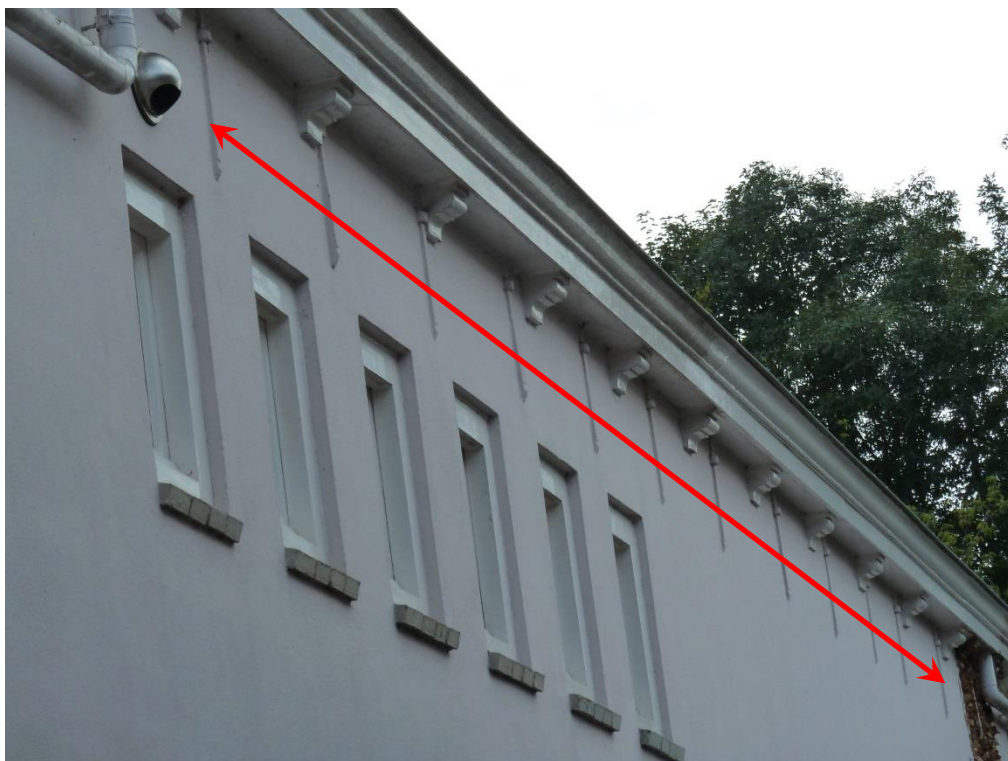
Foto 23: Verankering van de verdiepingvloer aan de Noord - Oostzijde
