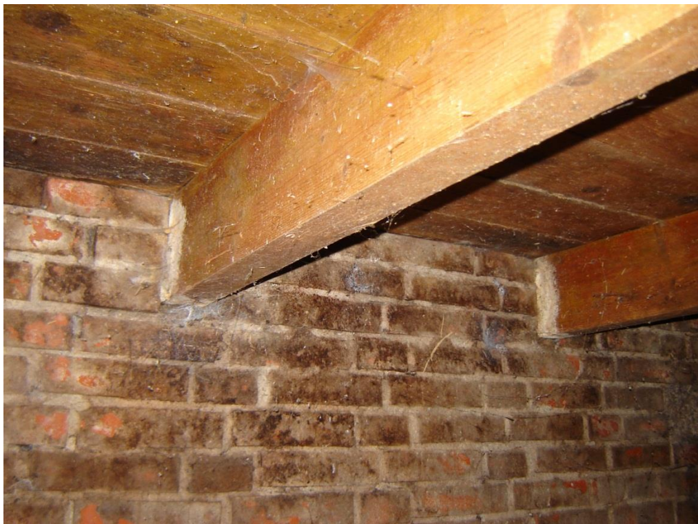
Foto 24: Oplegging balken in dragend metselwerk.
