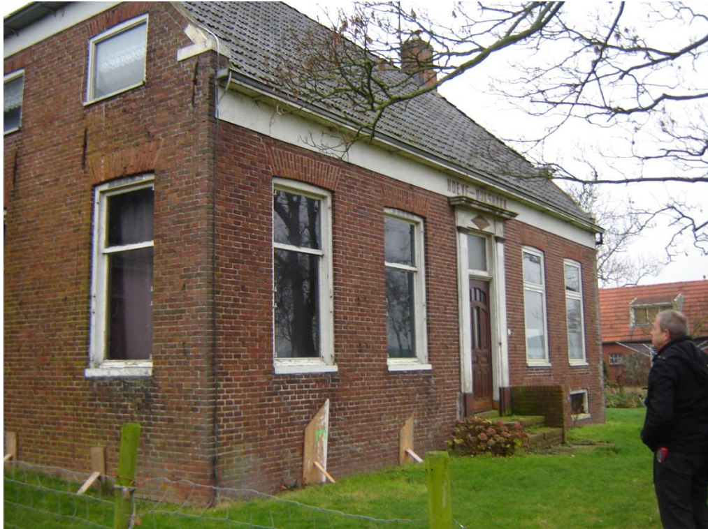
Foto 1: Voorgevel woonhuis (Zuidwestgevel).
