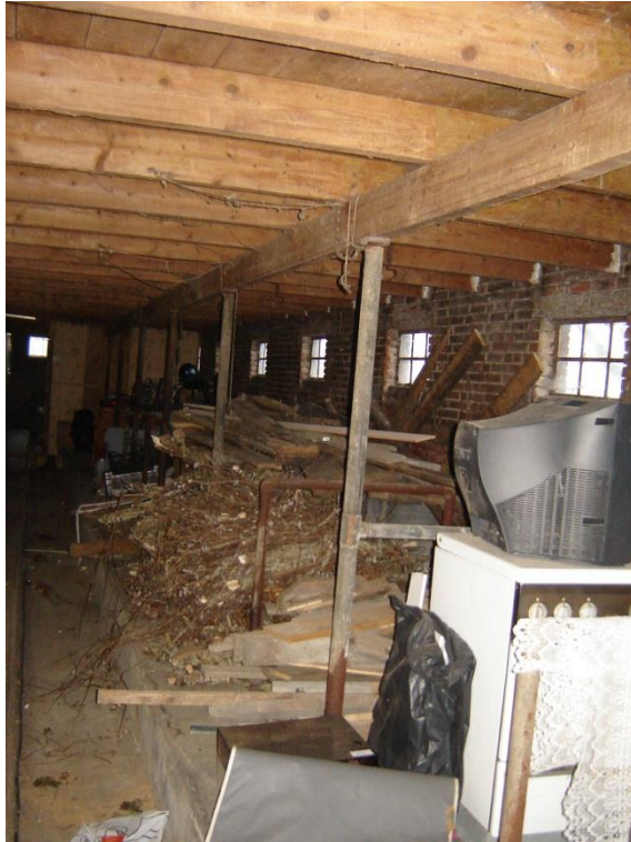
Foto 23: Koegang aan Zuidwestgevel schuur met tussenvloer.
