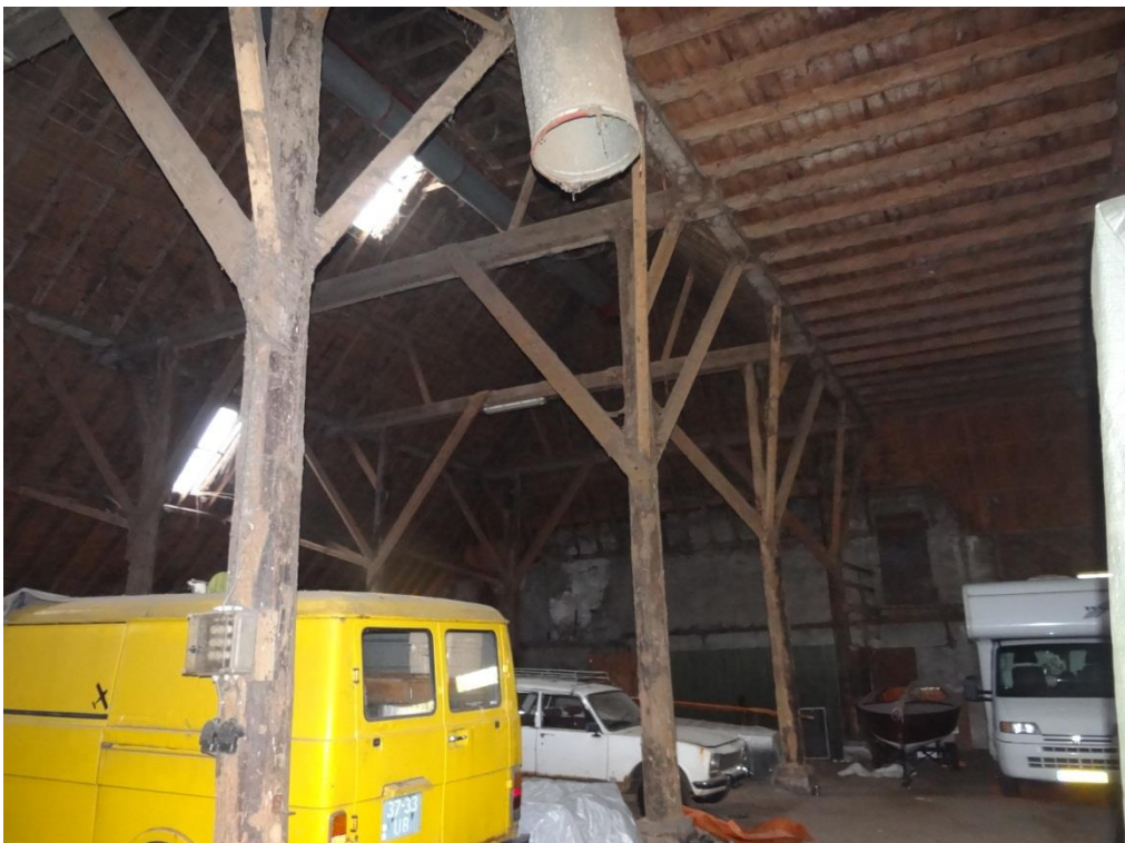
Foto 26: Kolommen en spanten in de schuur.
