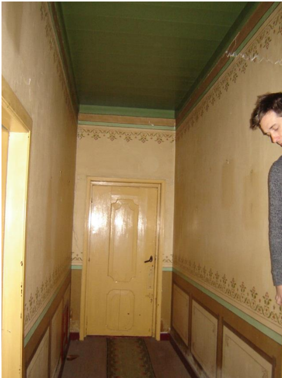
Foto 17: Gang met aan weerszijde halfsteens wanden en een houten plafond.
