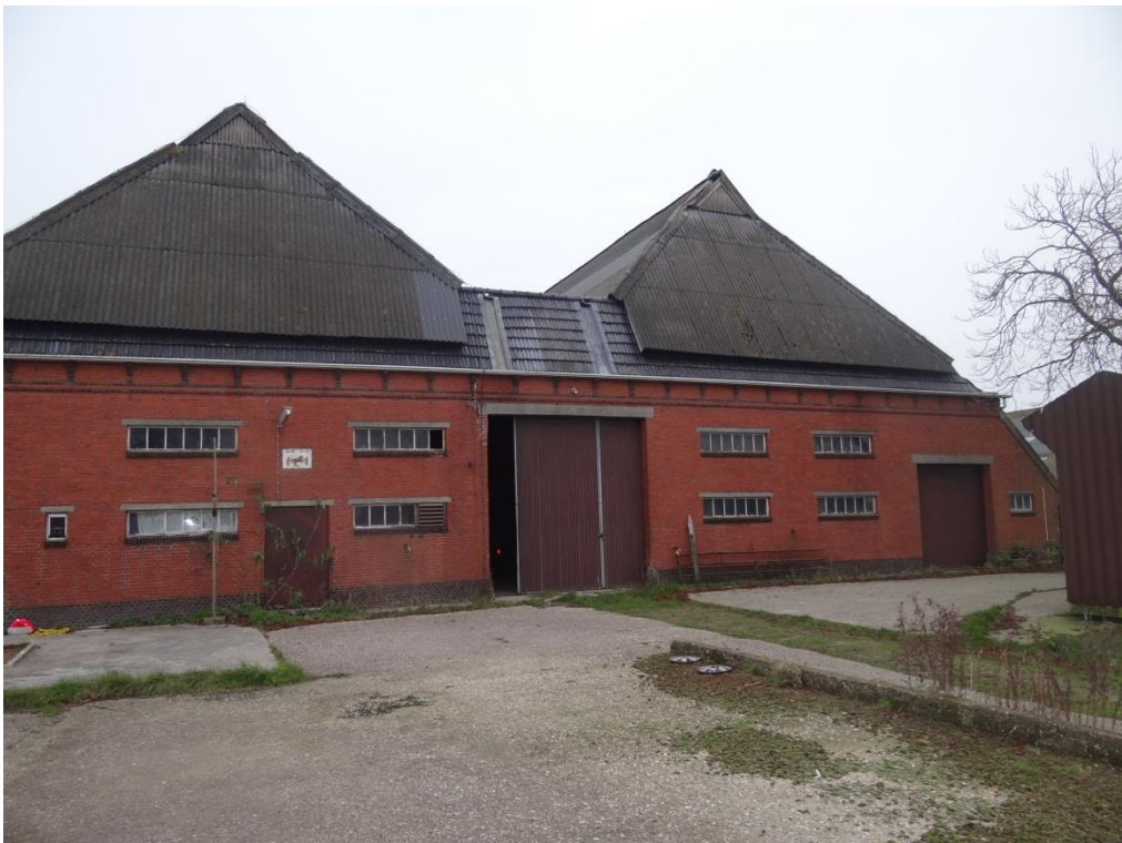
Foto 6: Achtergevel (Zuidwestgevel) schuur.
