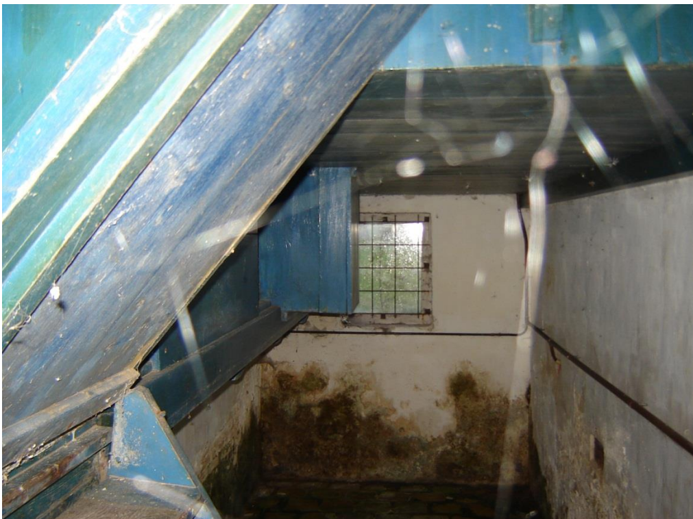
Foto 14: Kelder onder woonkamer.
