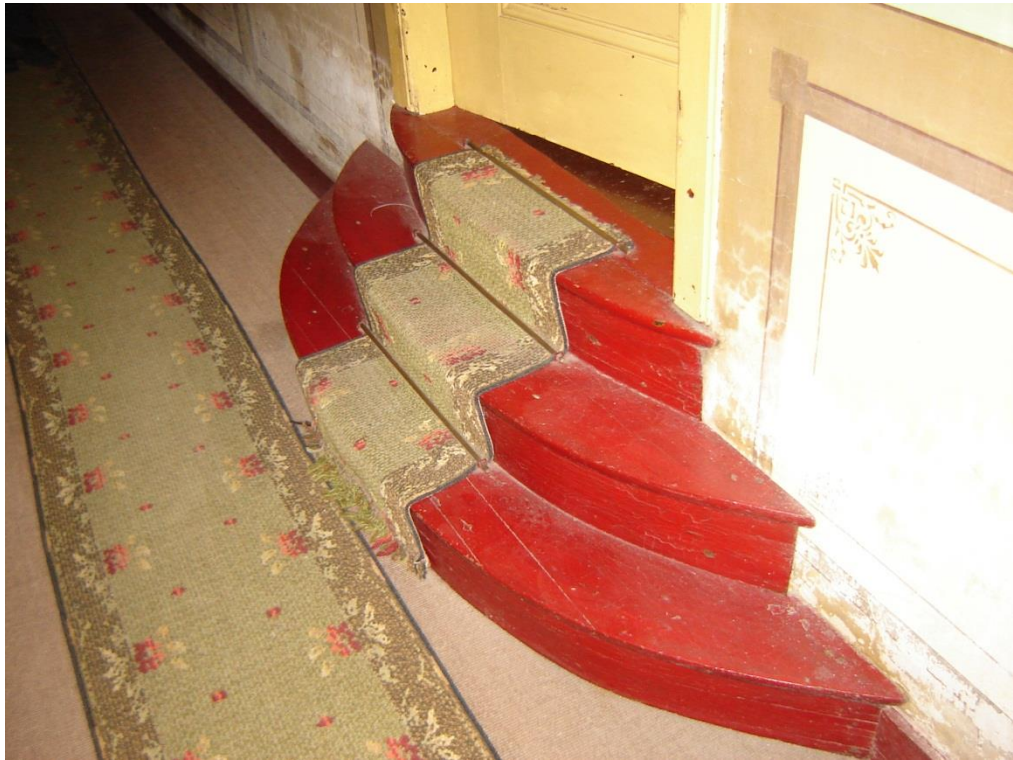
Foto 19: Houten trap ten behoeve hoogte overgang van gang naar voorkamer (opkamer).
