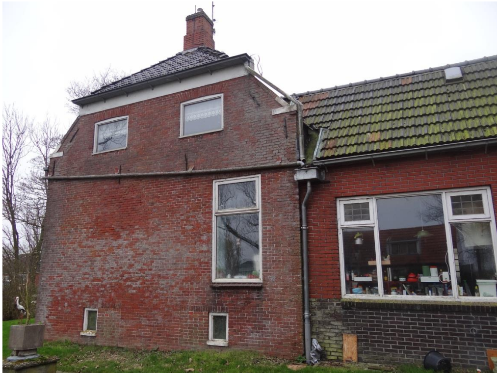
Foto 9: Rechter zijgevel woonhuis (Noordwestgevel).
