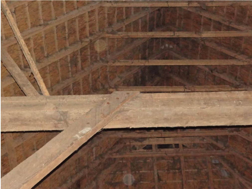
Foto 29: Verbinding schoor aan horizontale balk in kapconstructie.
