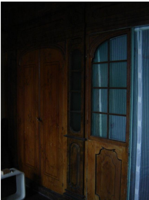
Foto 18: Houten wanden en betimmering in voorkamer (opkamer).
