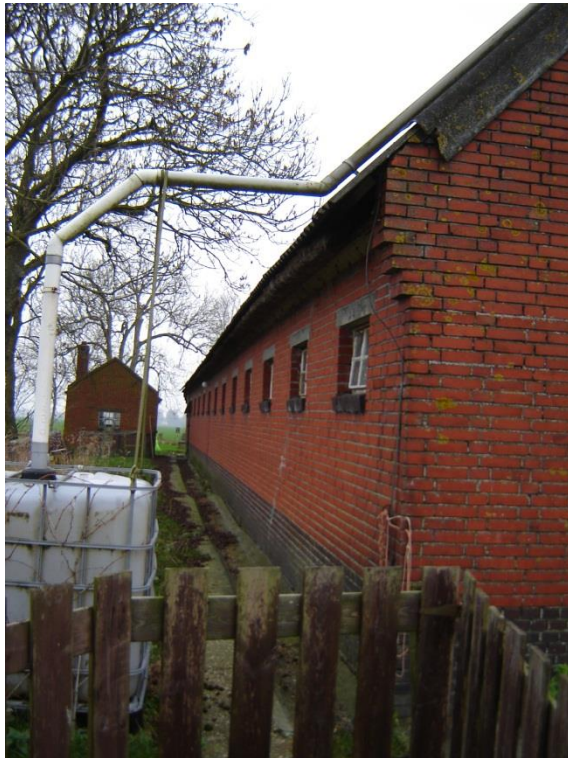
Foto 7: Rechter zijgevel schuur (Noordwestgevel).
