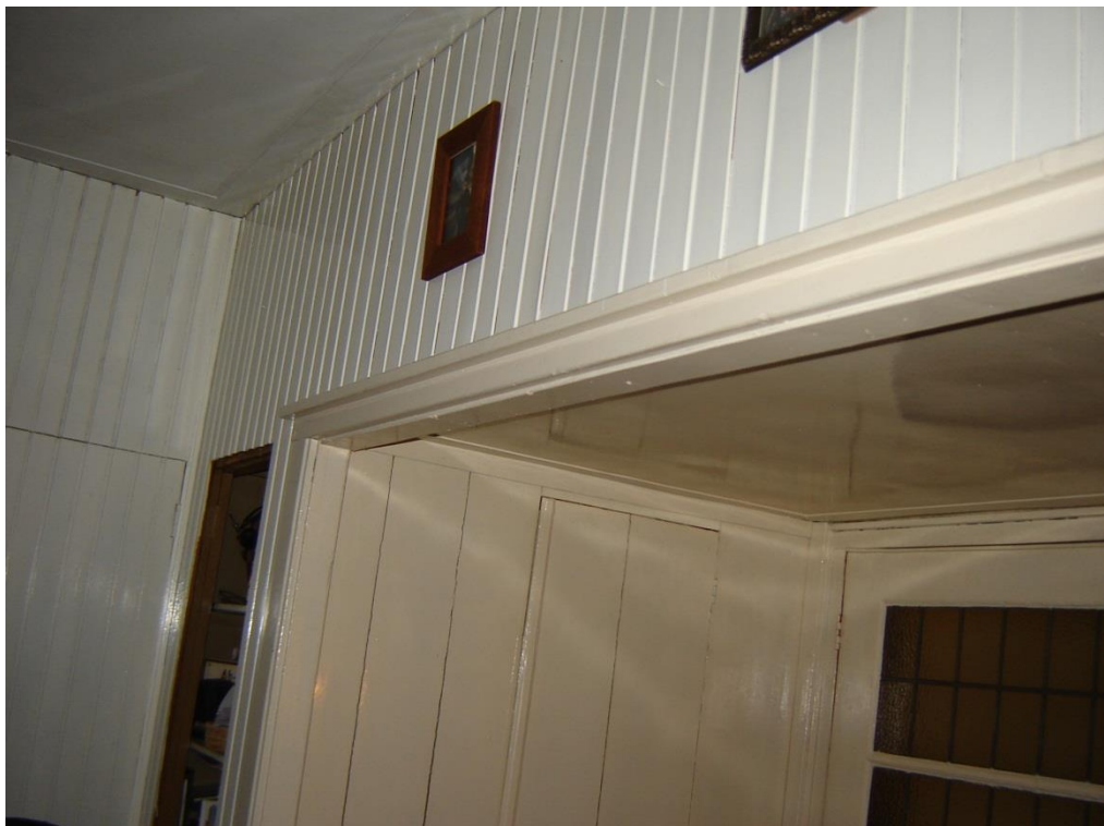
Foto 16: Houten wanden en betimmering in woonkamer.
