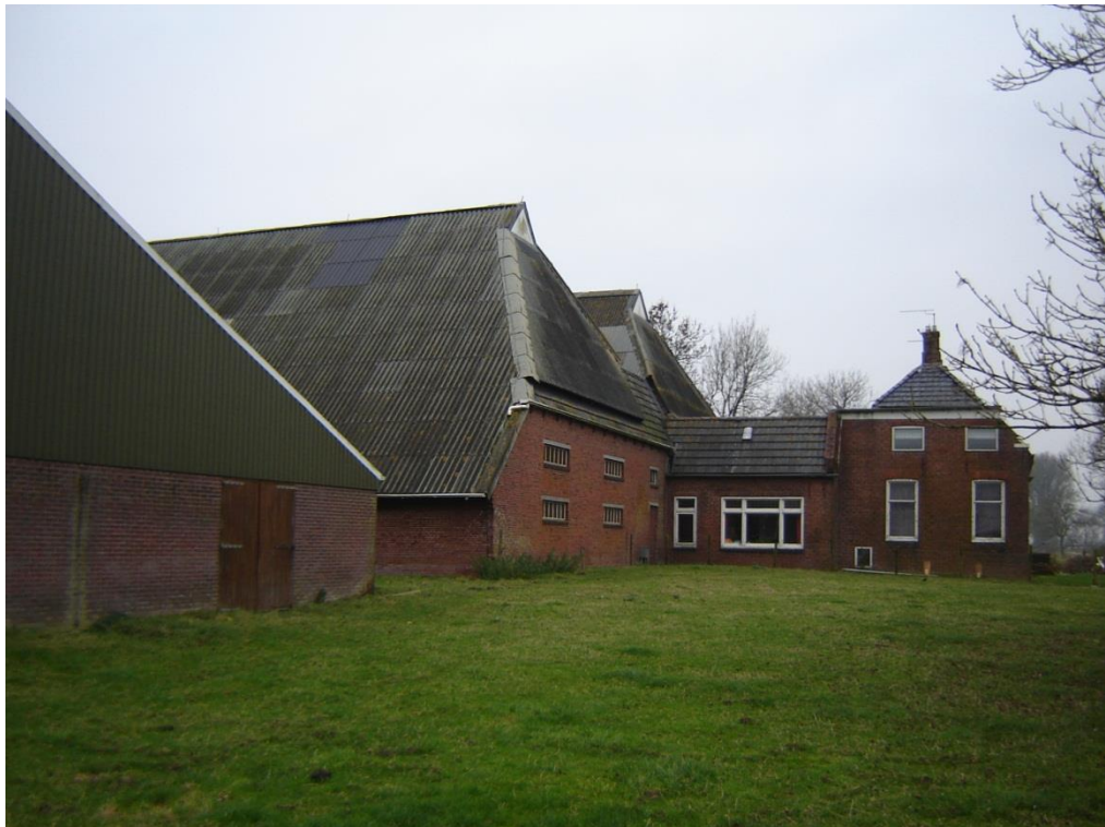
Foto 2: Linker zijgevel woonhuis (Zuidoostgevel) en voorgevel schuur.
