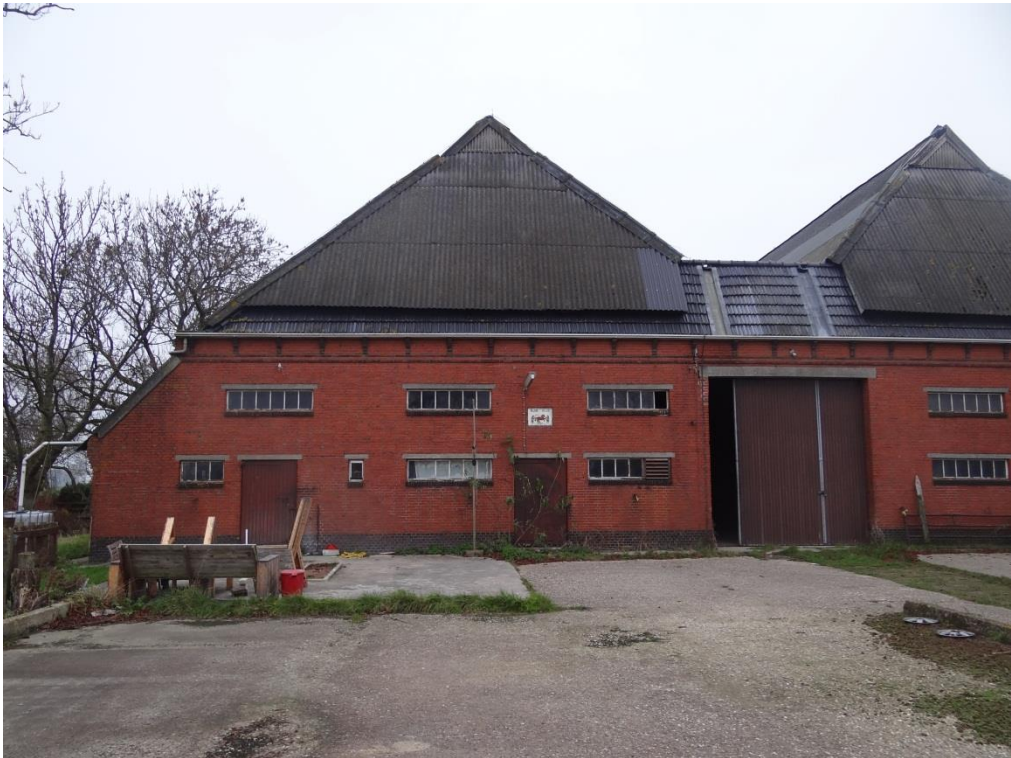
Foto 5: Achtergevel (Zuidwestgevel) schuur.
