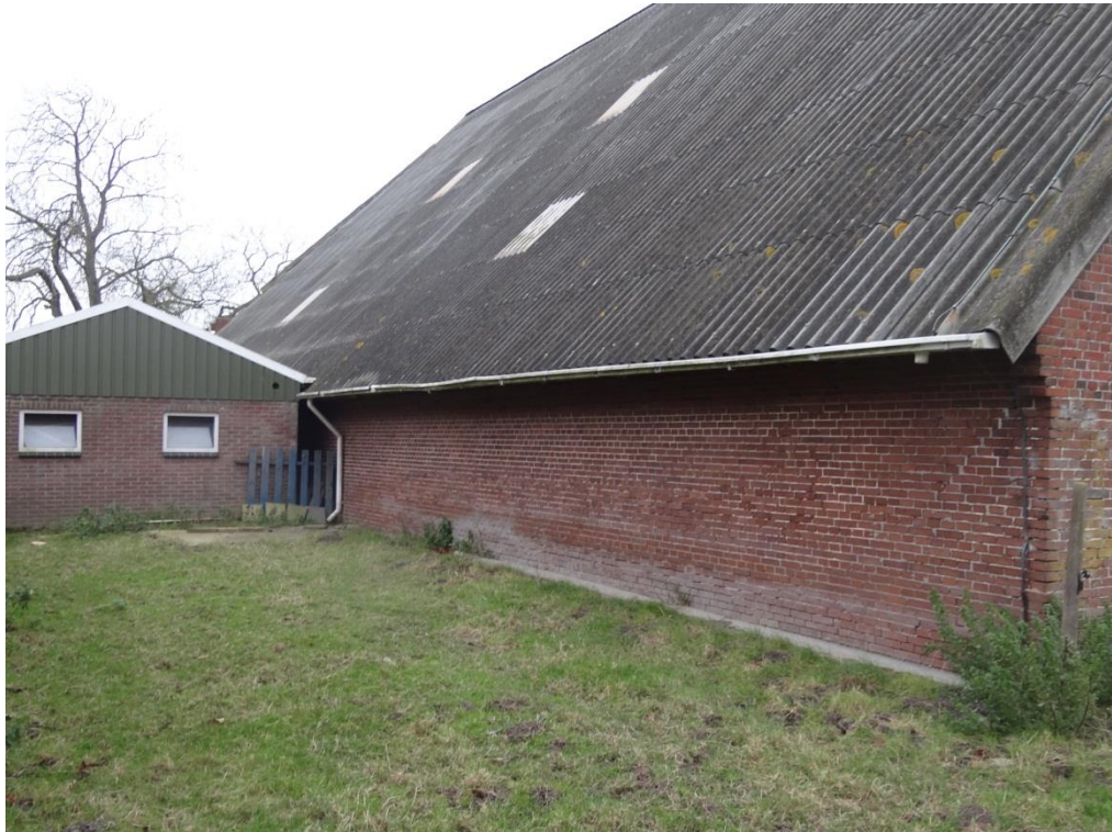
Foto 3: Linker zijgevel schuur (Zuidoostgevel) met de dilatatie naar de aangrenzende bebouwing.
