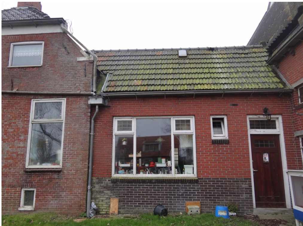
Foto 10: Rechter zijgevel woonhuis met ingang woonhuis.
