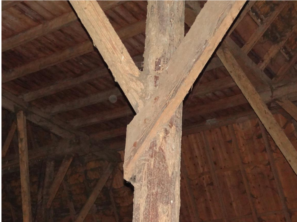
Foto 28: Verbinding kolom aan schoren.
