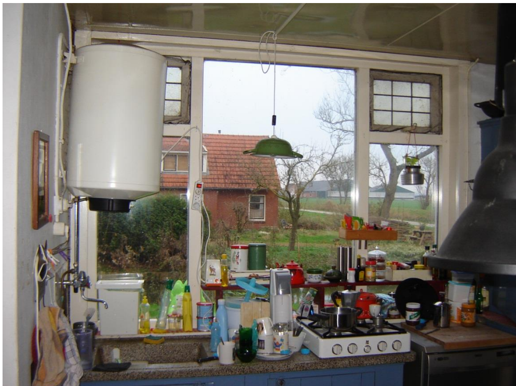
Foto 22: Keuken met kozijn, houten plafond en boiler.
