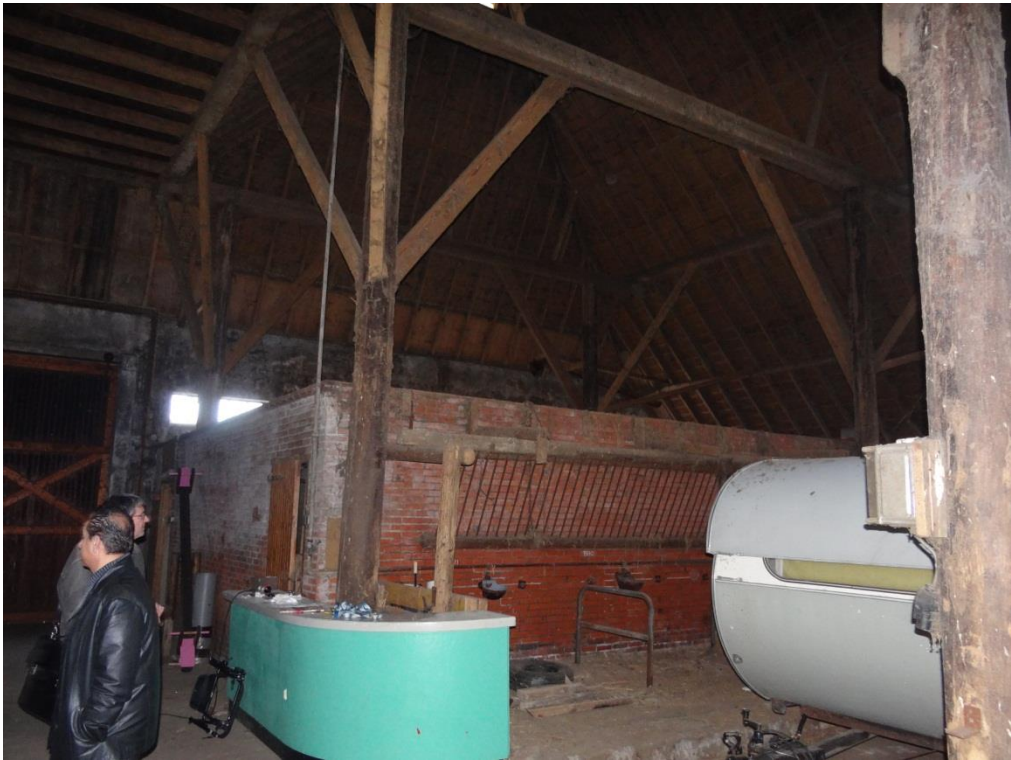
Foto 25: `Buitenzijde` van dek koegang in de schuur.
