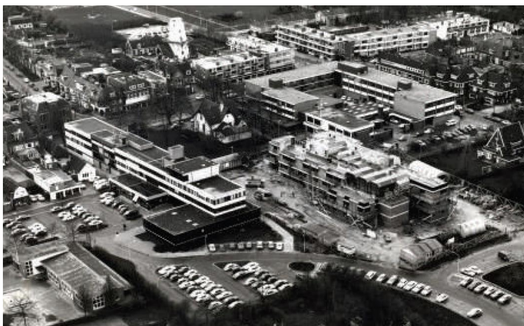
Luchtfoto 1974 vanaf de Hortuslaan richting Rijksweg. Met gemeentehuis in aanbouw, winkelcentra met wonen erboven gereed. Villa de Bulten is nog aanwezig.
