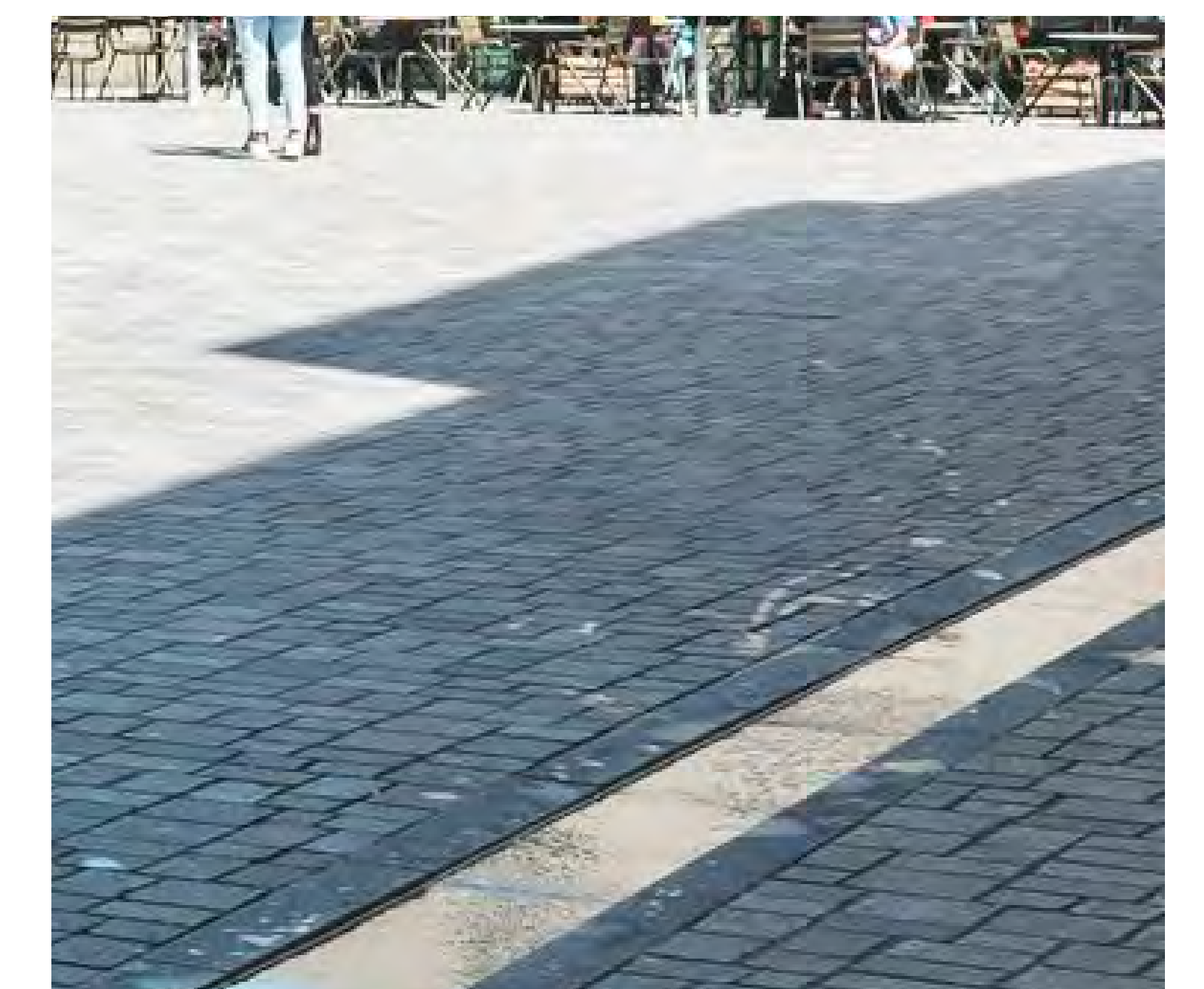
Molgoten met zichtbare waterafvoer
