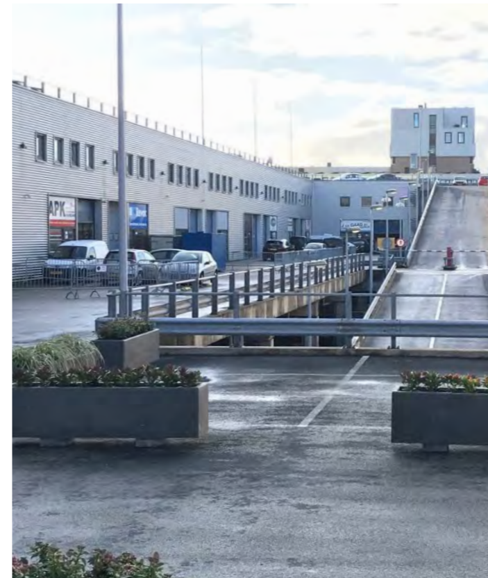
Binck twins, gestapeld bedrijfsgebouw, Den Haag
