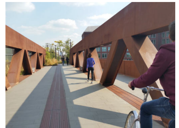
Paleisbrug, Den Bosch Foto door Nanda Sluijsmans
