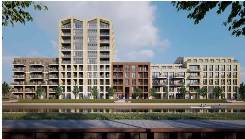
Eenvoudige vormtaal van de gebouwen
