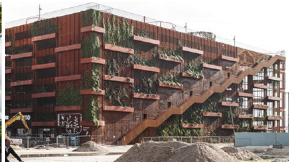
Activering van de gevel door trappen en groene verschijning door beplanting
