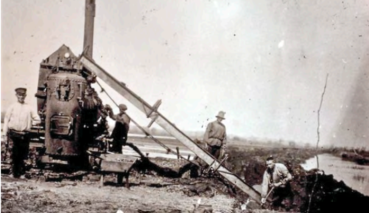
④ Machinale turfwinning tussen de Waterdijk en de Osdijk rond 1930. Bron: Groninger Archieven.
