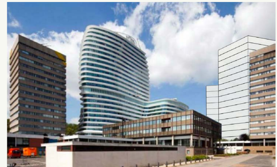
Een beeldbewerking van de iconische foto waarin het oude Rijkskantoor en de nieuwbouw in 2008 naast elkaar bestonden. Als toevoeging de volumestudie van Koning/Koningin als verkenning van het nieuw te ontwikkelen volume
