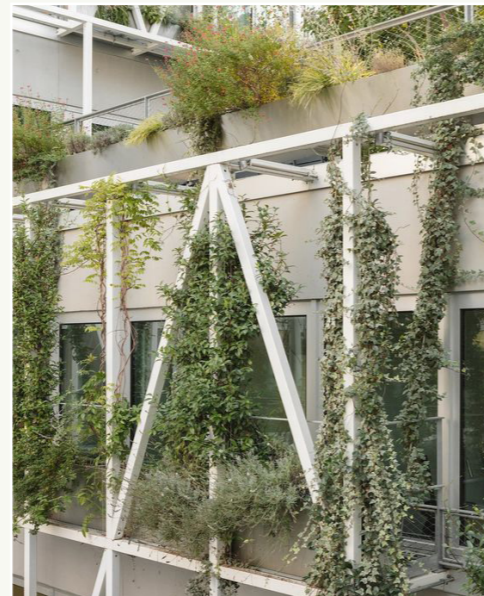
D. CONSTRUCTIES DIE GEVELBEGROEIING MOGELIJK MAKEN
