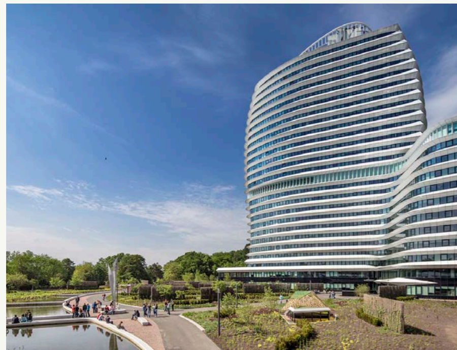
Het bestaande Rijkskantoor met de 2 laagse, donkere plint en witte horizontaal vormgegeven verdiepingvloeren. Het einde van het gebouw is ontworpen als uitstekende entergelegen kam.
