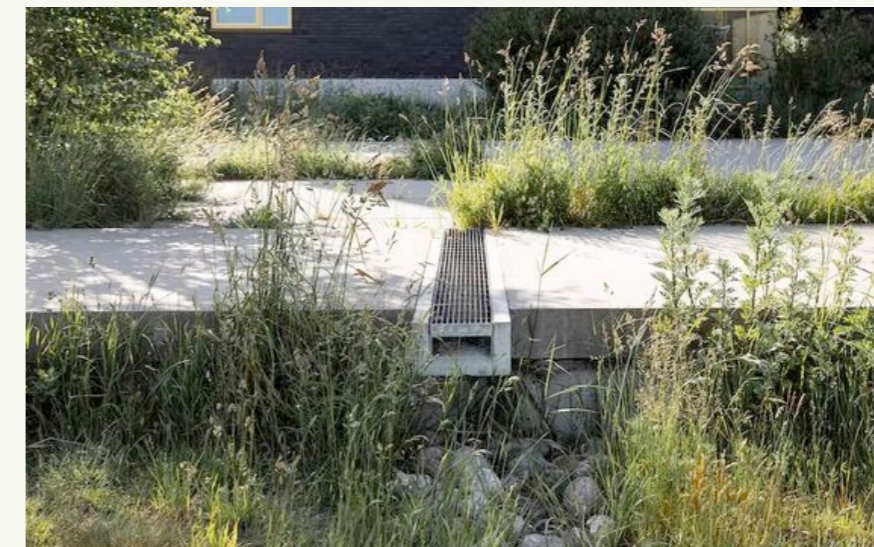
Mooi vormgegeven detail voor zichtbare afwatering van een gebied
