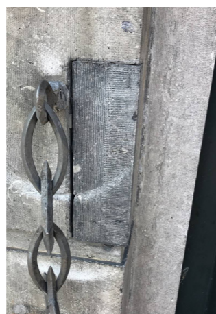
Loszittende elementen opnieuw verlijmen
