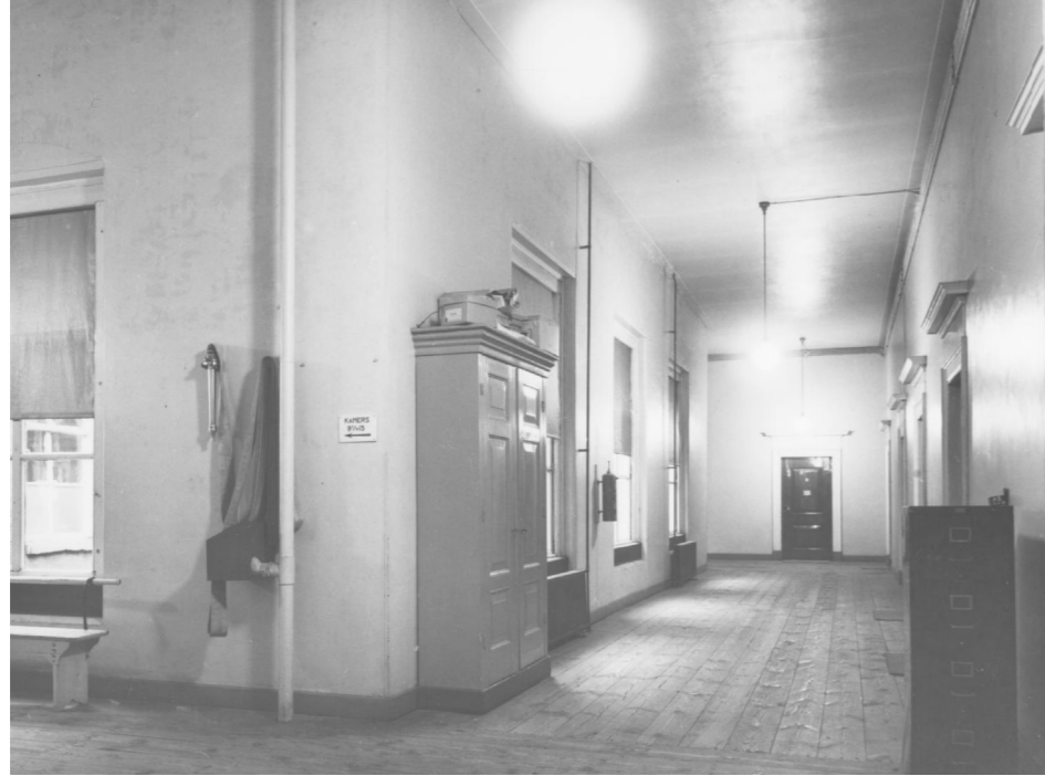
Sobere afwerking van de vloer met grenen houten planken (foto 1962)
