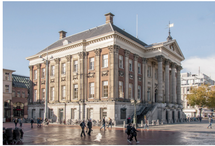
Werkzaamheden aan de buitengevel: schoonmaken zandsteen; schoonmaken metselwerk; schilderen kroonlijst conform kleur zandsteen; schilderen kozijnen en raamhout.
