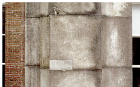
Afboerend zandsteen vervangen nadat ankers zijn uitgeboord
