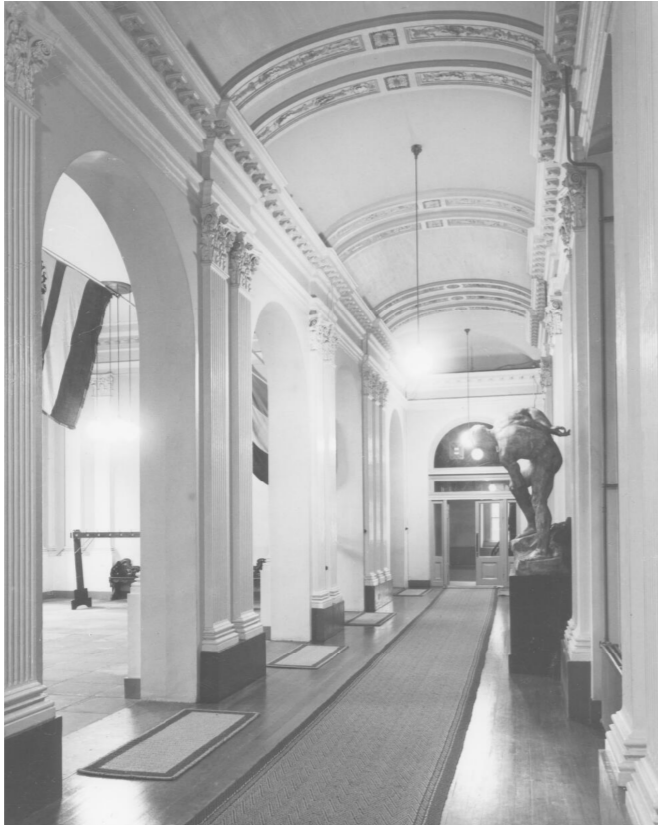
De centrale gang op de eerste verdieping is voorzien van een loper (foto 1962)
