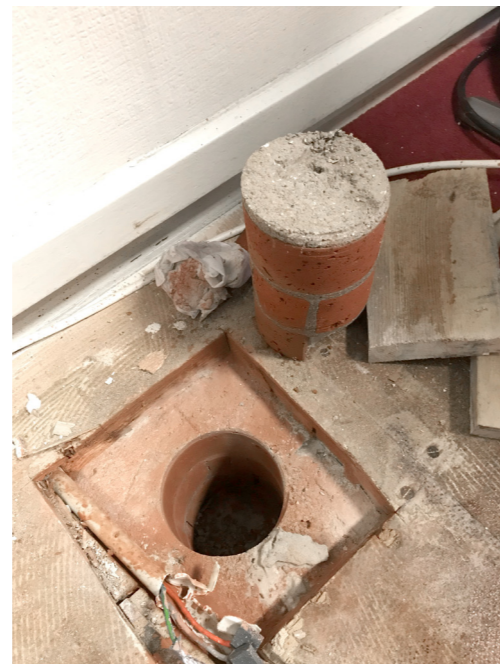
Destructief onderzoek naar de vloeropbouw
