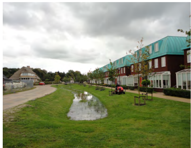
Voorbeeld van een Water Afvoer Door Infiltratie (WADI) in de wijk Helpermaar
