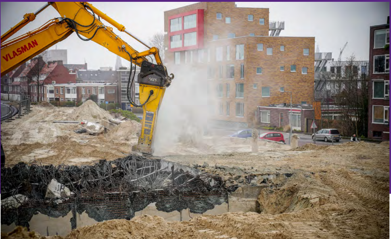
Stof bij de sloop van de Amaliatunnel © foto Raymond Bos
