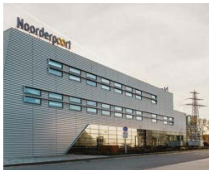
Middelbare school in P3/oude skivijver. Noorderpoort Automotive & Logistiek Groningen. © Logistiek Noord
