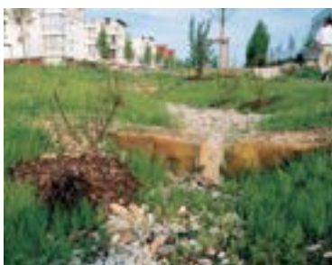
Waterinfiltratie in openbare ruimte: naast voetpad en wadi in park
