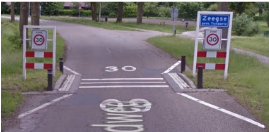
Foto: voorbeeld komversterking gecentreerde versmalling
