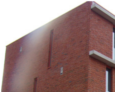
Vleermuis inbouwstenen Waveka >3m hoog, zuid-zuidoost, op kopgevel 6-8 neststenen per deelgebied
