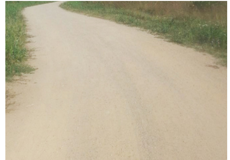
Halfverharding koersmix tpv paden bij de dijk
