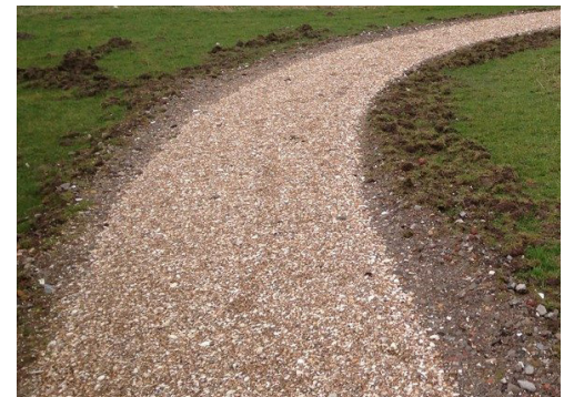
Halfverharding, gewassen kleischelpen
