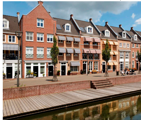
Stevige wanden kadere het sluisplein in.
