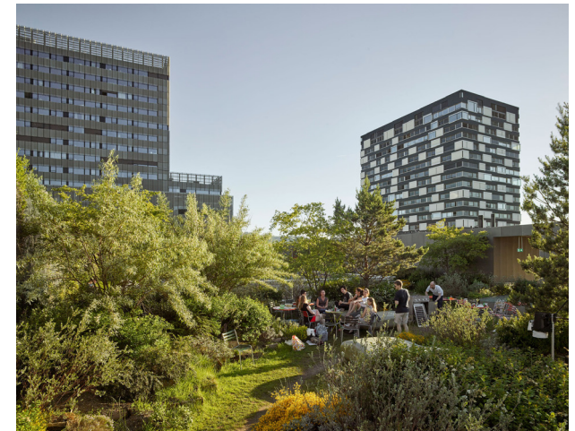
Afbeelding 53: Groen op het dak verlengt de openbare ruimte en heeft positieve effecten op de omgeving | Toni Areal, Zürich
