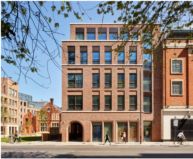
Afbeelding 42.1: Toynbee Hall, Londen | Platform 5 Architects
