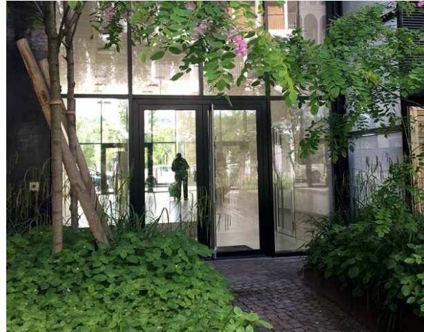
Afbeelding 98: Zicht op de groene strip vanuit de straat, door het gebouw heen | Clichy-Batignolles, Parijs
