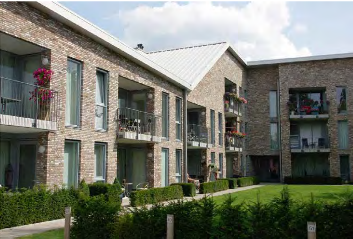
Doorlopende daklijn, voormalige NAM-locatie Oldenzaal
