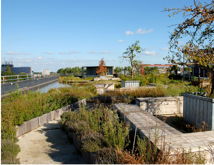
Afbeelding 36: Daktuin Bylon, Amsterdam (De Dakdokters)
