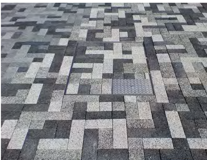
Afbeelding 107: Modulaire deksels worden opgenomen in de bestrating en kunnen makkelijk uitgehaald worden wanneer er onderhoud nodig is.
