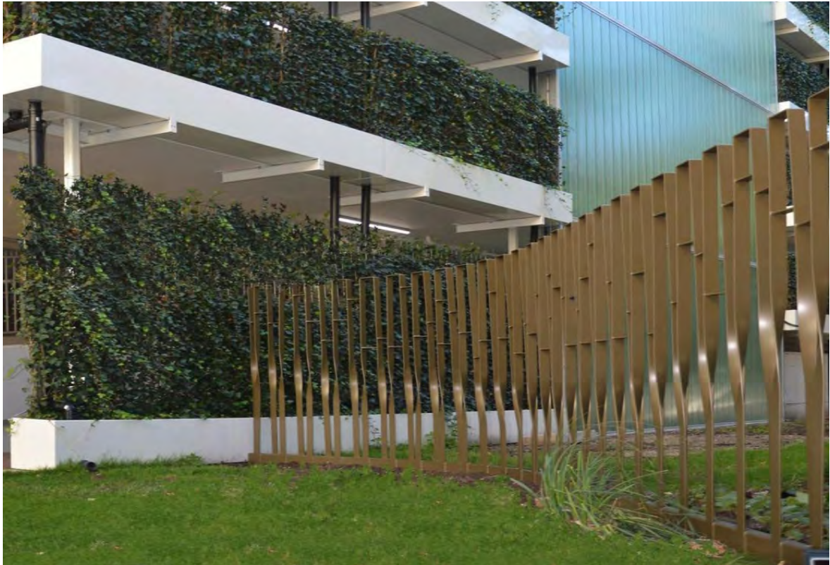
Afbeelding 179: Op een subtiële manier afgeschermd van de publieke ruimte | Kantoortuin First Rotterdam (Loos van Vliet)
