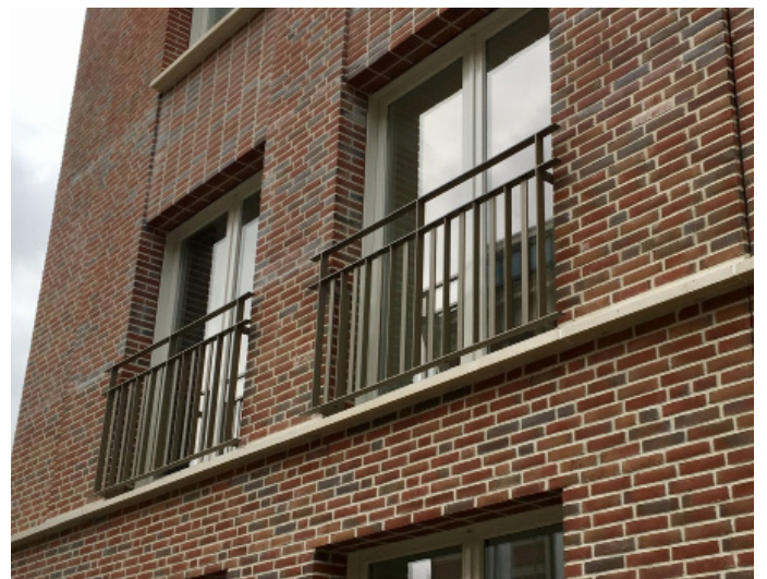
Afbeelding 17: Balkons steken niet te ver uit de gevel, zodat lichtinval in de straat behouden blijft | Housing IJburg block 8, Amsterdam (AWG Architecten)
