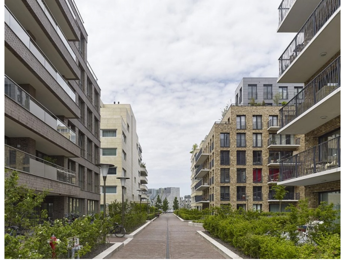
Afbeelding 19: Setbacks van de bovenbouw | Campus Overhoeks, Amsterdam (Geurst & Schulze)
