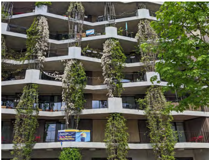
Afbeelding 30: Groene gevel met balkons/galerij | Hunziker Areal, Zürich (Duplex)
