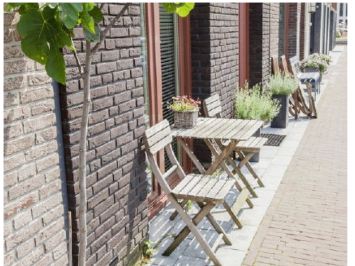
Afbeelding 94: Invulling door bewoners in de gevelzone met planten en meubilair | Leeuwendveld, Weesp
