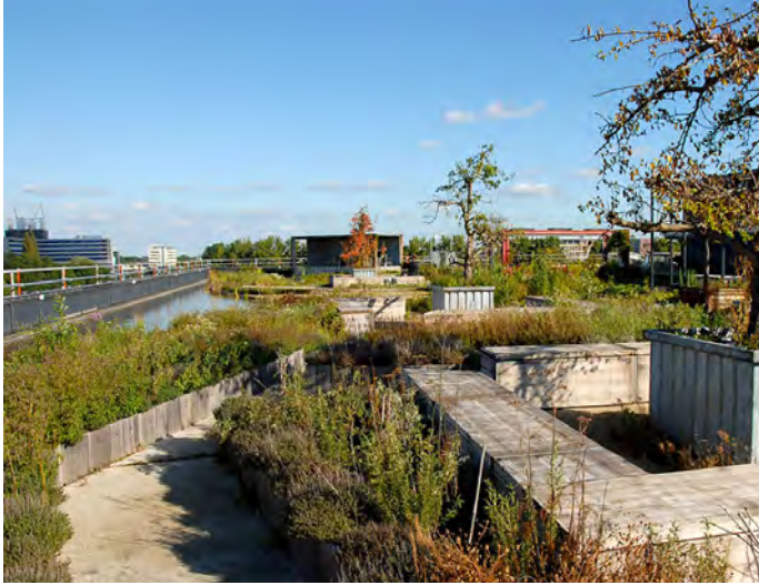
Afbeelding 36: Daktuin Bylon, Amsterdam (De Dakdokters)
