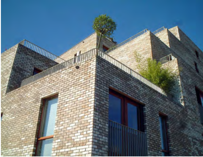
Afbeelding 15: Het geveloppervlak dat zichtbaar wordt door de push-ins heeft hetzelfde materiaal als de voorgevel | Altera Aqua, Breevaarthoek (KCAP)
