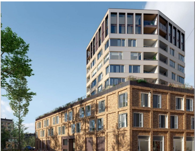
Afbeelding 20: Versprwing van bovenbouw | Octagon, Leiden (NL Architects)
