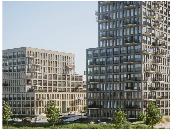
Afbeelding 9: Ensemble met variaties in gevelgrid en setbacks van de bovenbouw | Akropolis & De Generaal, Zeeburgereiland, Amsterdam (studioninedots)
