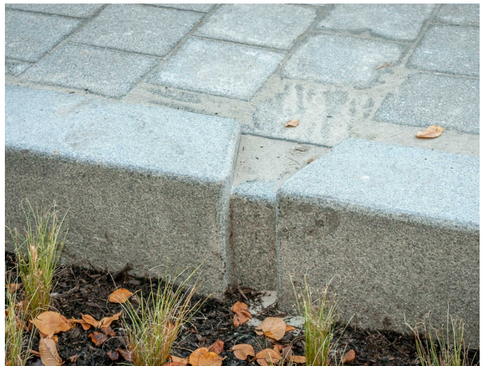
Afbeelding 134: Goed afgewerkte rand tussen stoep en lager gelegen groenstrook | Rainproof Amsterdam
