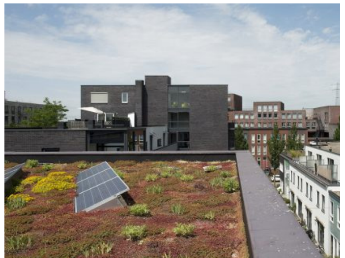
Afbeelding 41: Groen dak met zonnepanelen | Neptunusschool, IJburg, Amsterdam (Premark)
