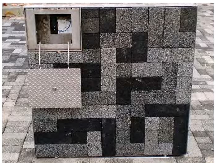
Afbeelding 107: Modulaire deksels worden opgenomen in de bestrating en kunnen makkelijk uitgehaald worden wanneer er onderhoud nodig is.
