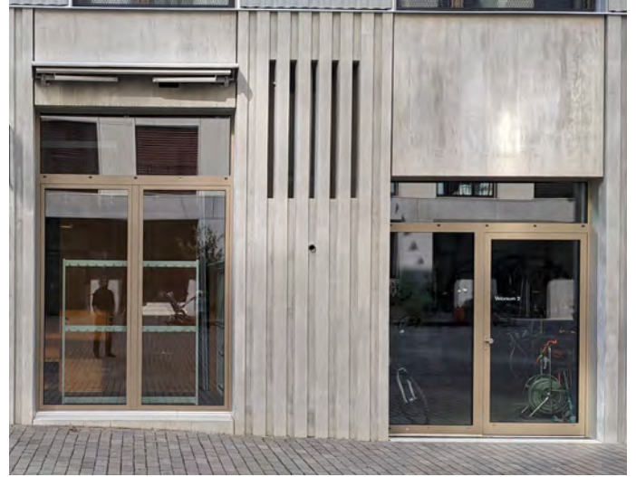
Afbeelding 54: De vloer aan de binnenzijde sluit aan bij het maaiveld. Kleine aanpassingen ten hoogte van de ingang zijn opgelost in de openbare ruimte | Zürich
