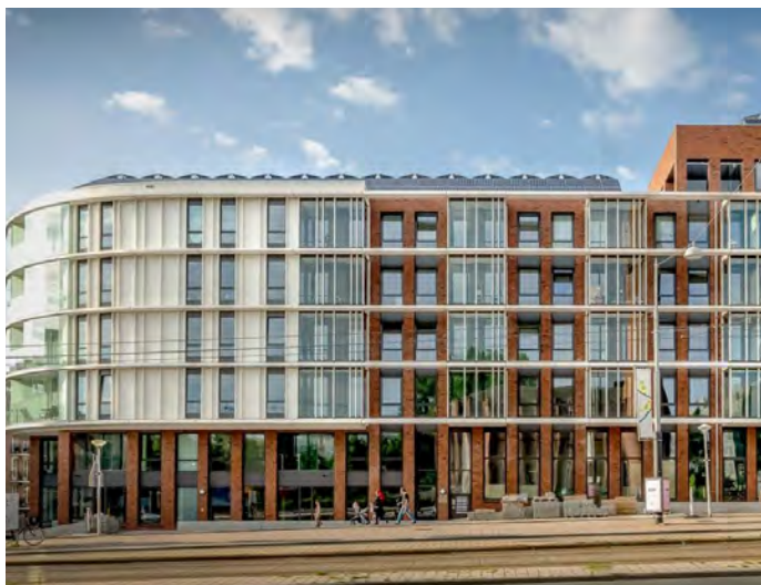
Afbeelding 47: De bovenlijn van de plint blijft op dezelfde hoogte, ondanks de aflopende omgeving | Rhapsody, Amsterdam-West (Tangram)
