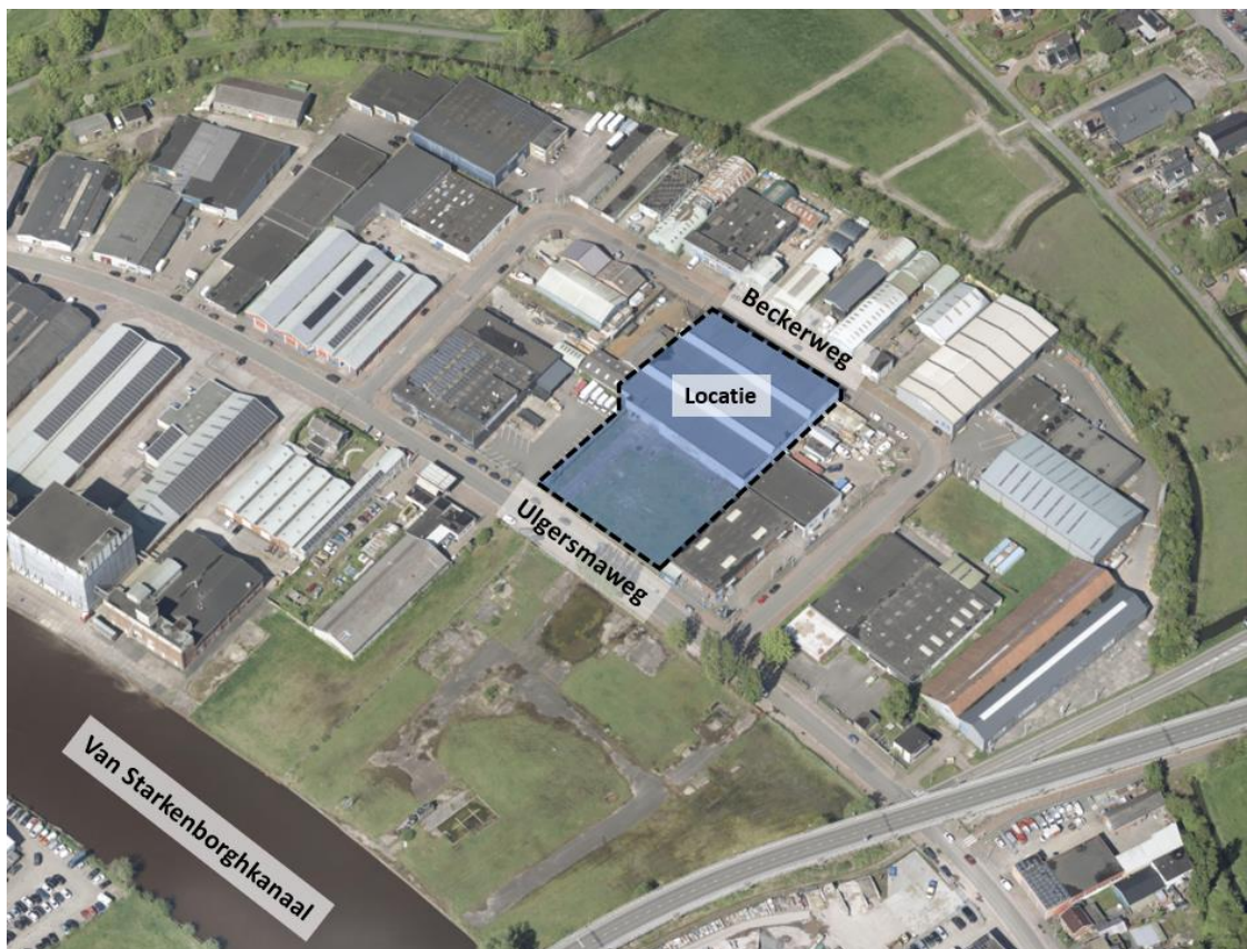
Gemeentelijke loods aan de Ulgersmaweg 51/ Beckerweg 8
