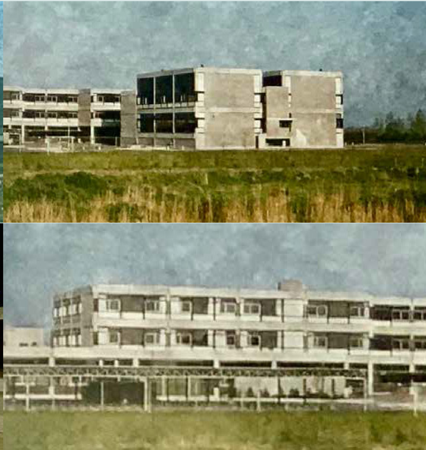
Oorspronkelijk was de fietsenstalling alleen een dak op dunne poten; een schakel in de vierkanten-structuur van het complex (dia collectie CSG Selion).
