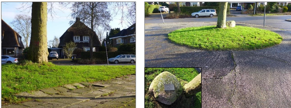
Afbeelding 12/13: Opdruk van tegels (plataan nr. 10) en asfalt (plataan nr. 11) door wortels die dicht aan de oppervlakte zijn gegroeid. Bij boomnummer 11 ligt een steen met een vriendschapsplaquette (zie inzet).
