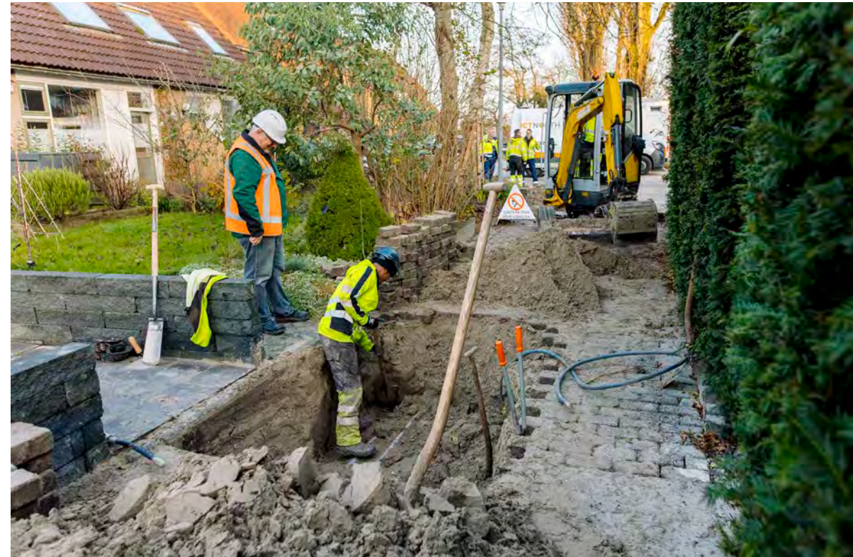
Tijdens werkzaamheden onder de grond is het belangrijk om het wortelpakket goed te beschermen. Daarom is er in Groningen een systeem van structureel toezicht op graafwerkzaamheden bij bomen.
