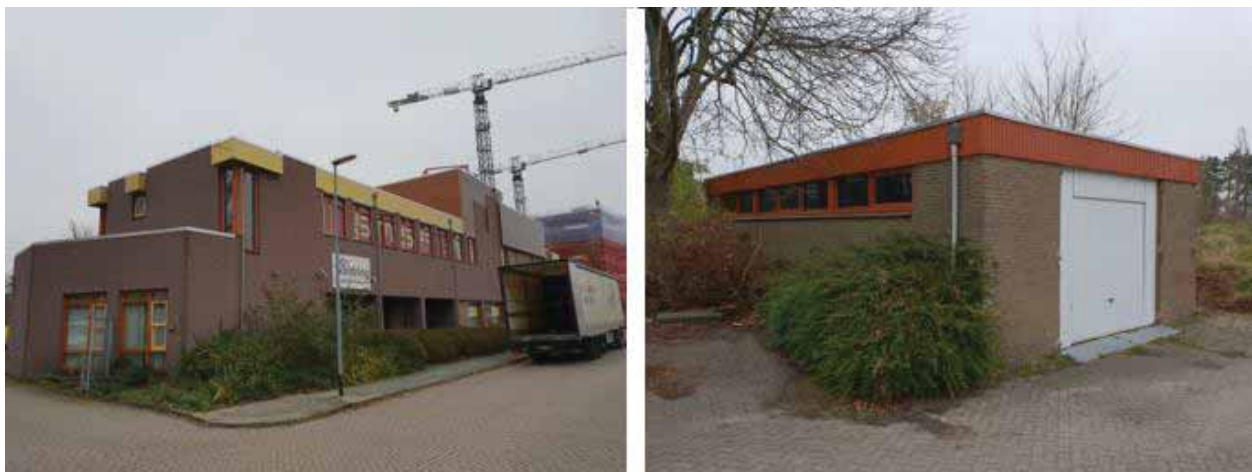
Figuur 2-3: Impressie van het plangebied met het kantoorpand voorzijde, aanwezige garage, watergang Reitdiep en de achterzijde van het kantoorpand. Deze situatie is onveranderd gebleven. Foto's RHDHV 2018.
