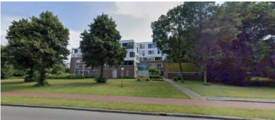
Figuur 3-13 Kantoorpanden Damsterdiep
