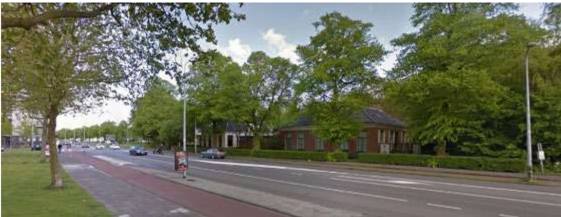
Figuur 3-12 Karakteristieke panden Damsterdiep 231-237
