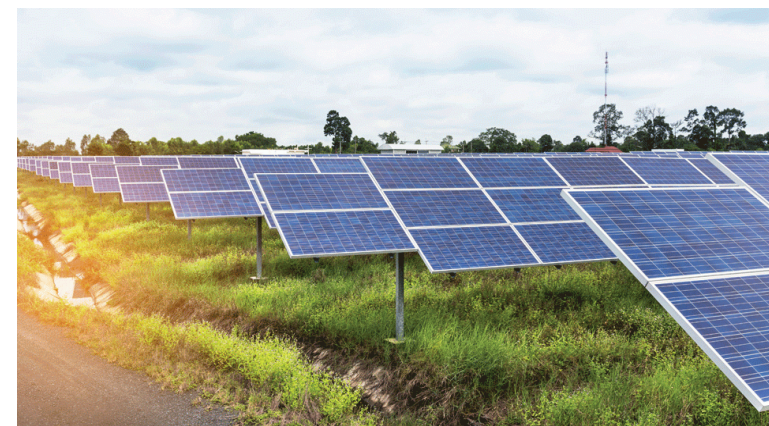
Voorbeeld van een semi-intensief zonnepark
