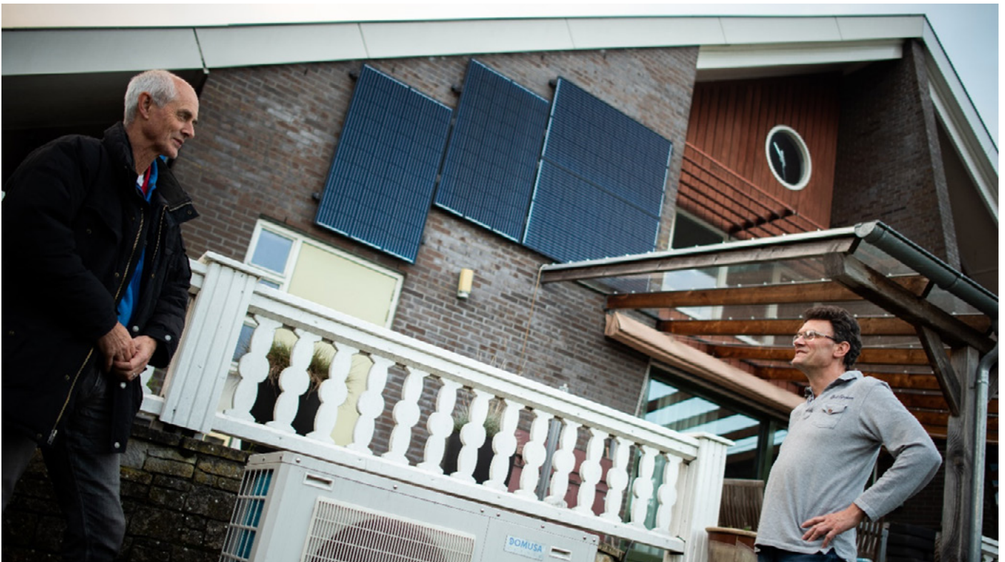
Figuur 13 Verticale opstelling zonnepanelen in Reitdiep. Bron: Mariska de Groot
