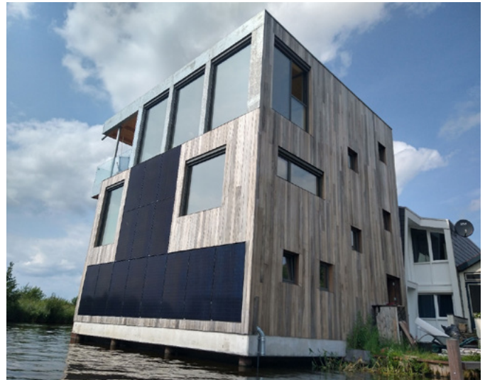
Figuur 12 Voorbeeld van zonnepanelen als gevelbekleding.
