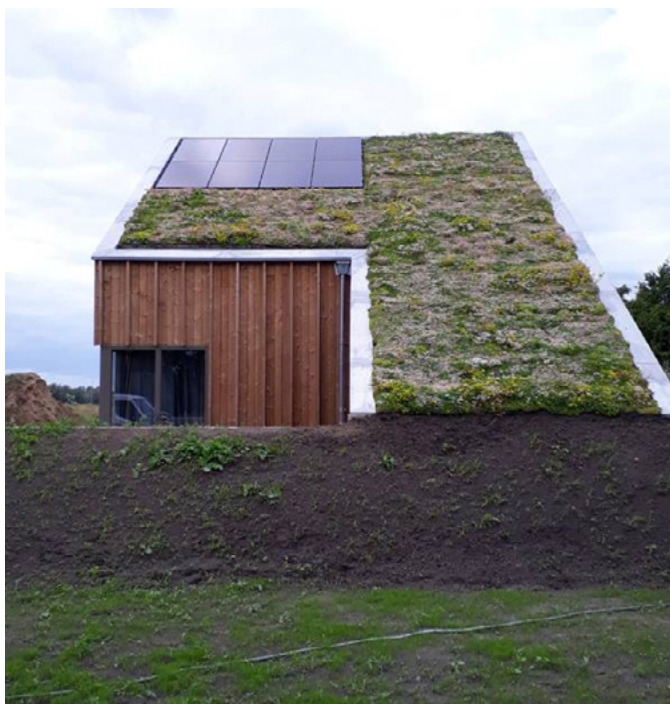
Figuur 2 Zonnepanelen en sedum dak op een schuin dak is ook mogelijk. Bron: Frisia Bergum
