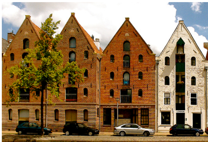
Figuur 2.10: Voorbeeld van eenheid, variatie, verschil tussen onder- en bovengevel en een afwijkende gevelkleur
