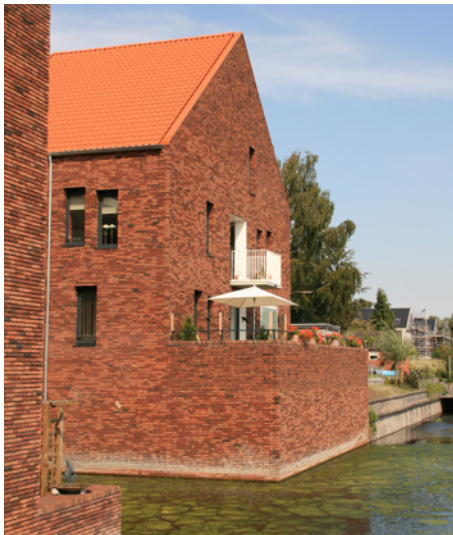
Figuur 7.2: Gevel staat direct in het water.
