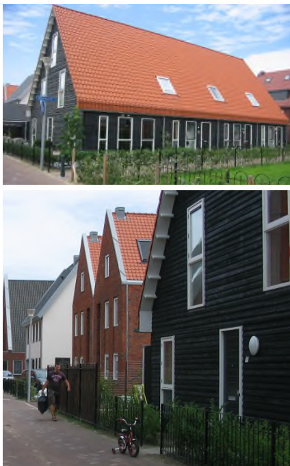
Figuur 6.2: Voorbeelden van beperkt materiaal- en kleurkeuze voor gevel en dak.
