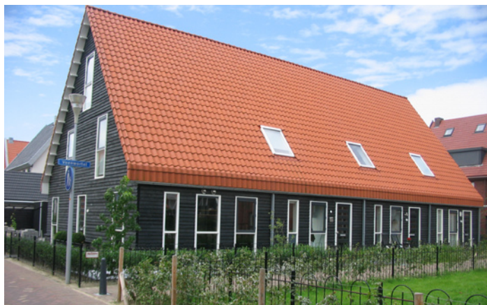
Figuur 3.23: Voorbeelden van beperkt materiaal- en kleurkeuze voor gevel en dak.
