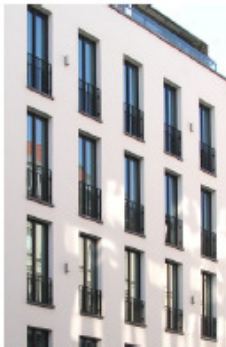
Gevel met openingen in pleisterwerk
