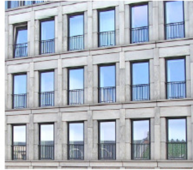
Gevel met openingen in natuursteen
