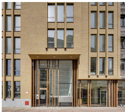
Plasticiteit van plint en eerste verdieping met afleesbare entree
