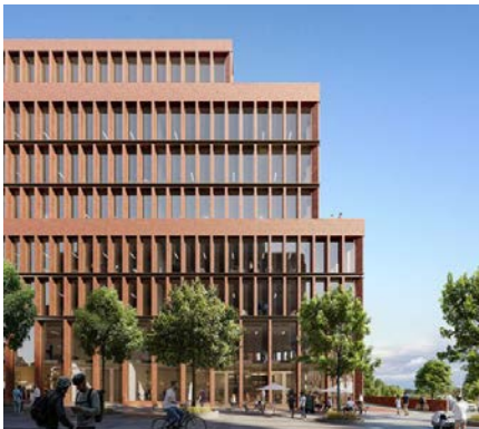
Heldere structuur en gevelopbouw. © 3XN
