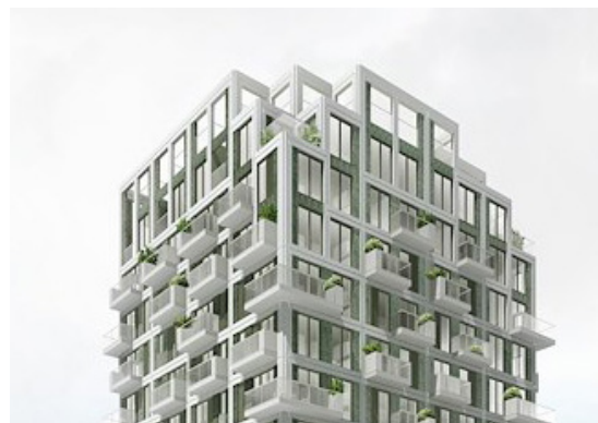
Technische installaties worden uit het zicht geplaatst
