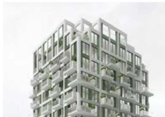
Technische installaties worden uit het zicht geplaatst
