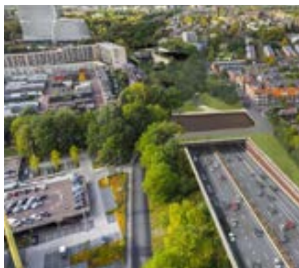
De Ring Zuid verdiept als tunnel onder het Oude Winschoterdiep
